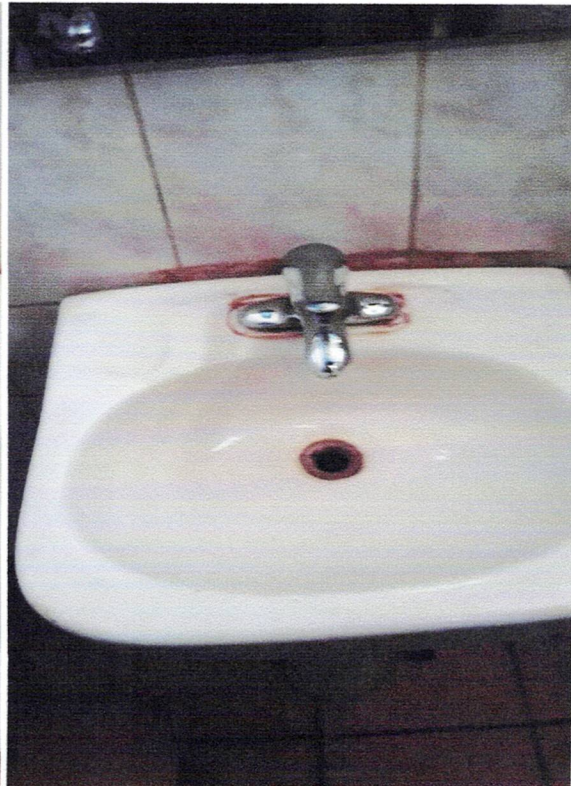
LLAVE NUEVA INSTALADA
