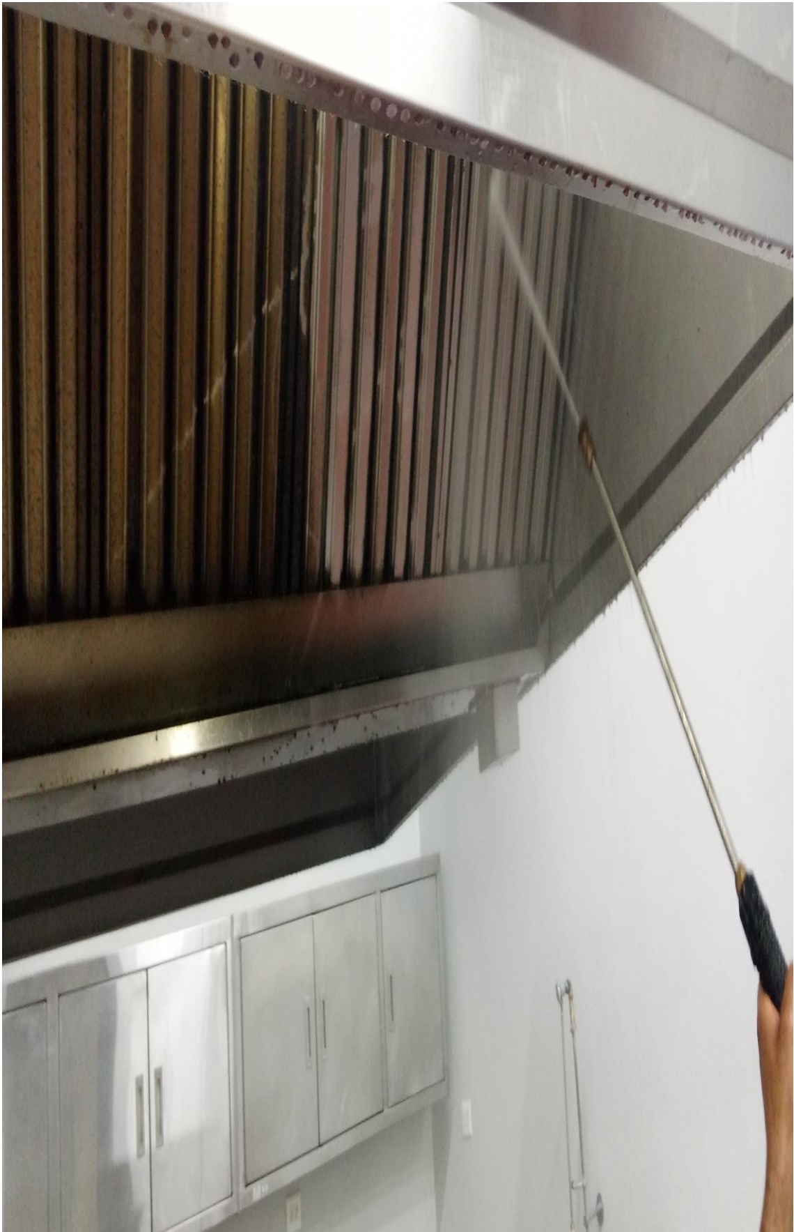
Limpieza de extractor 07/03/2024
