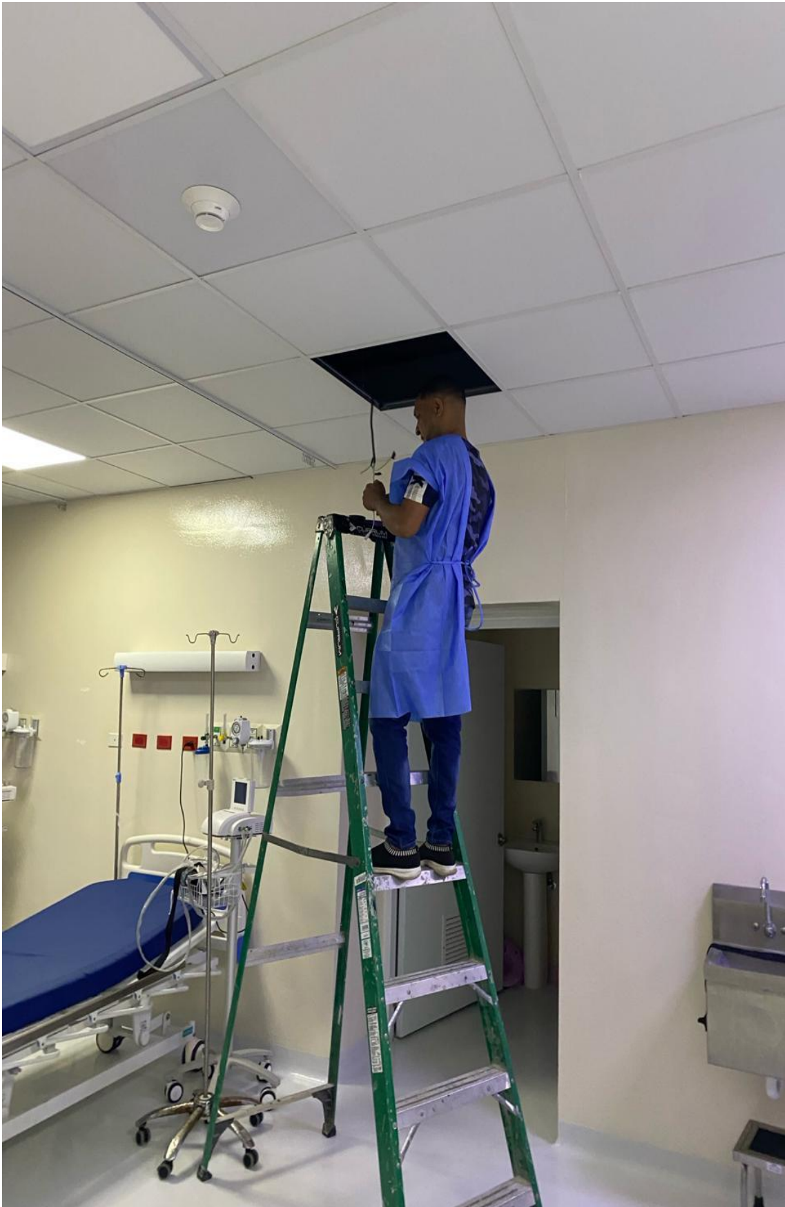
Cambio de lámpara en parto
