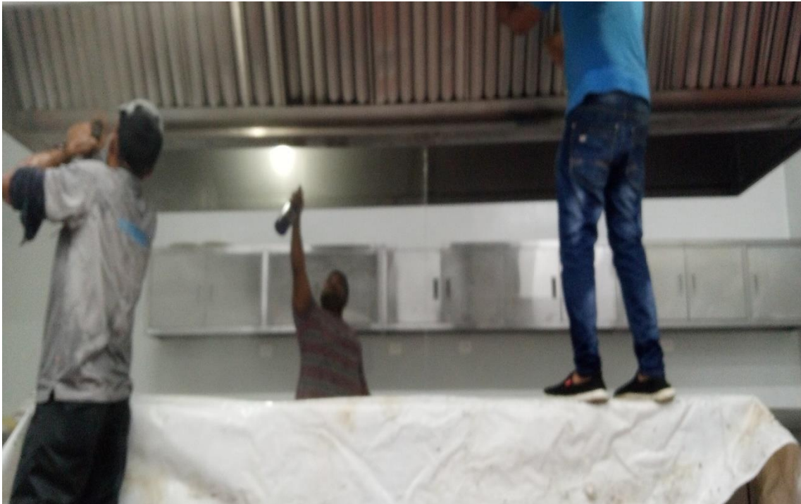
Limpieza de extractor 07/03/2024
