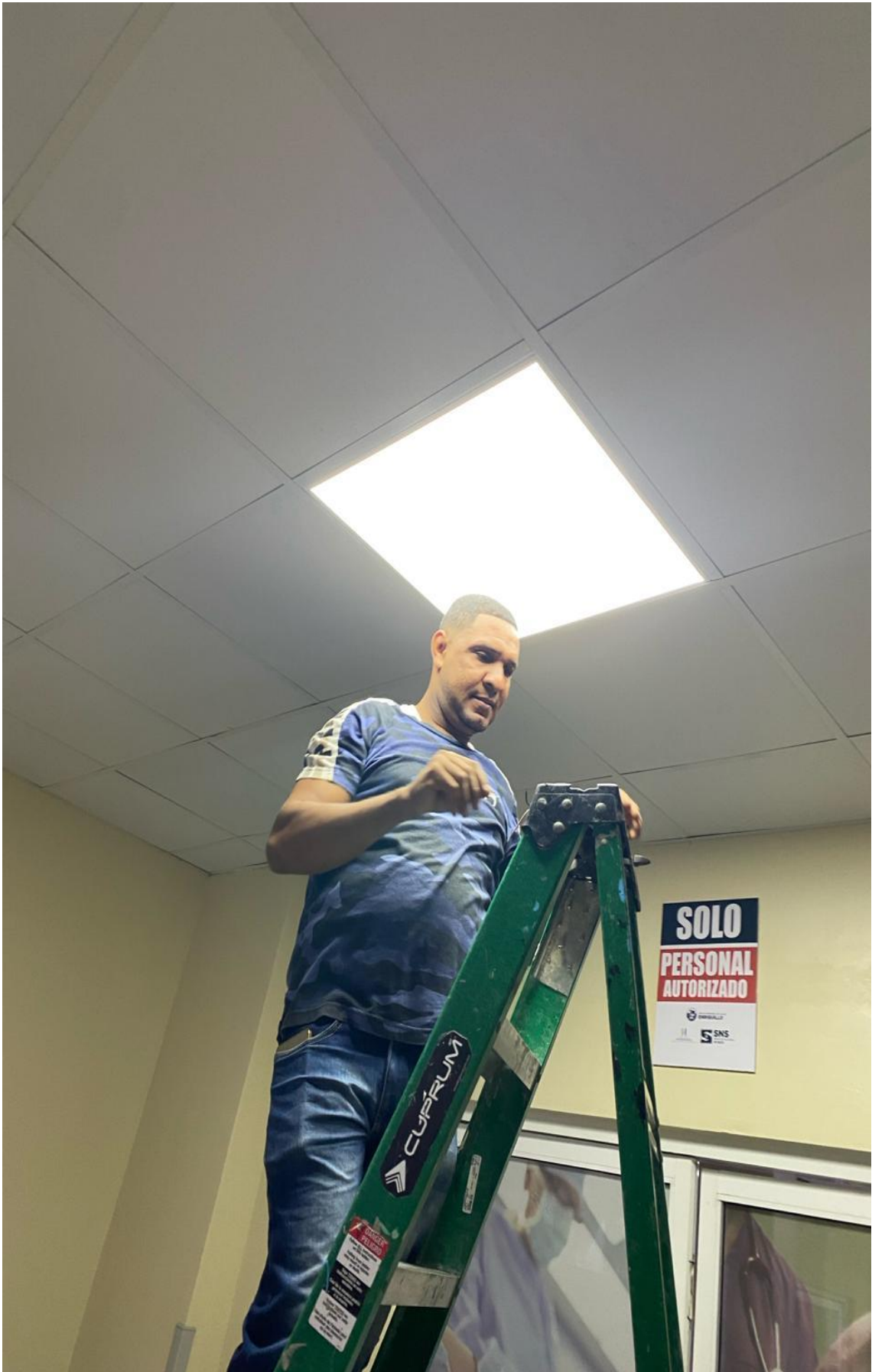
Pasillo de internamiento 04/03/2024
