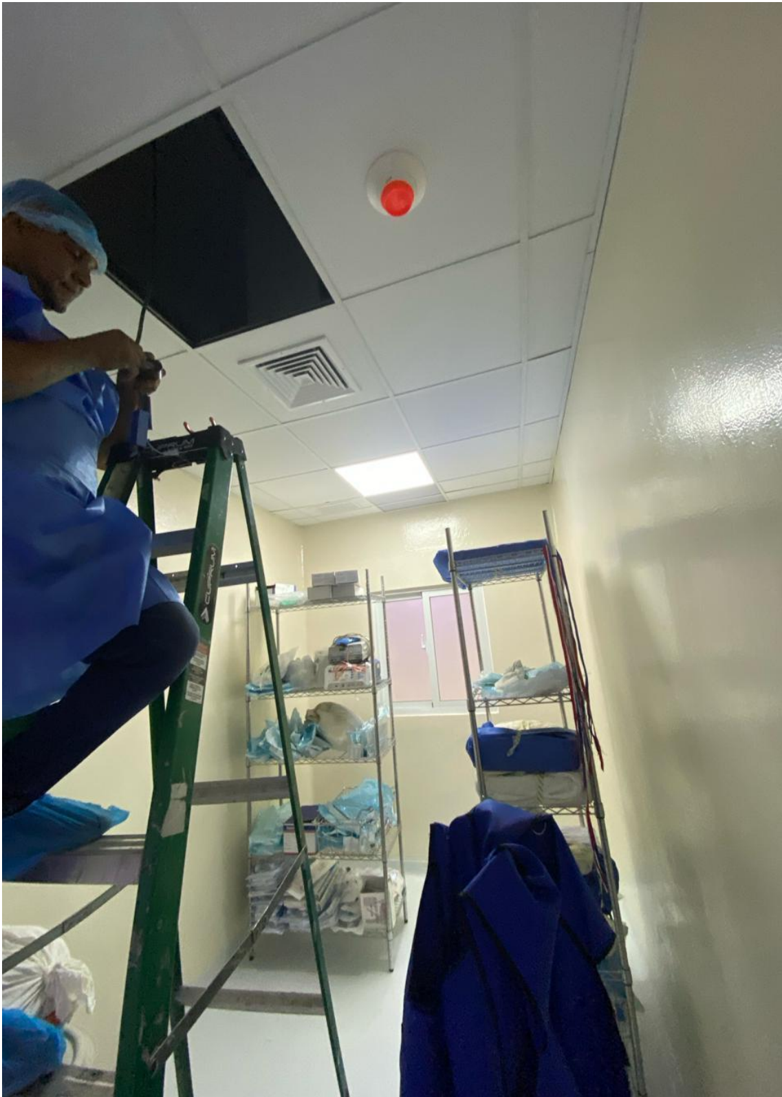
Cambio de lámpara en almacén de esterilizados 04/03/2024
