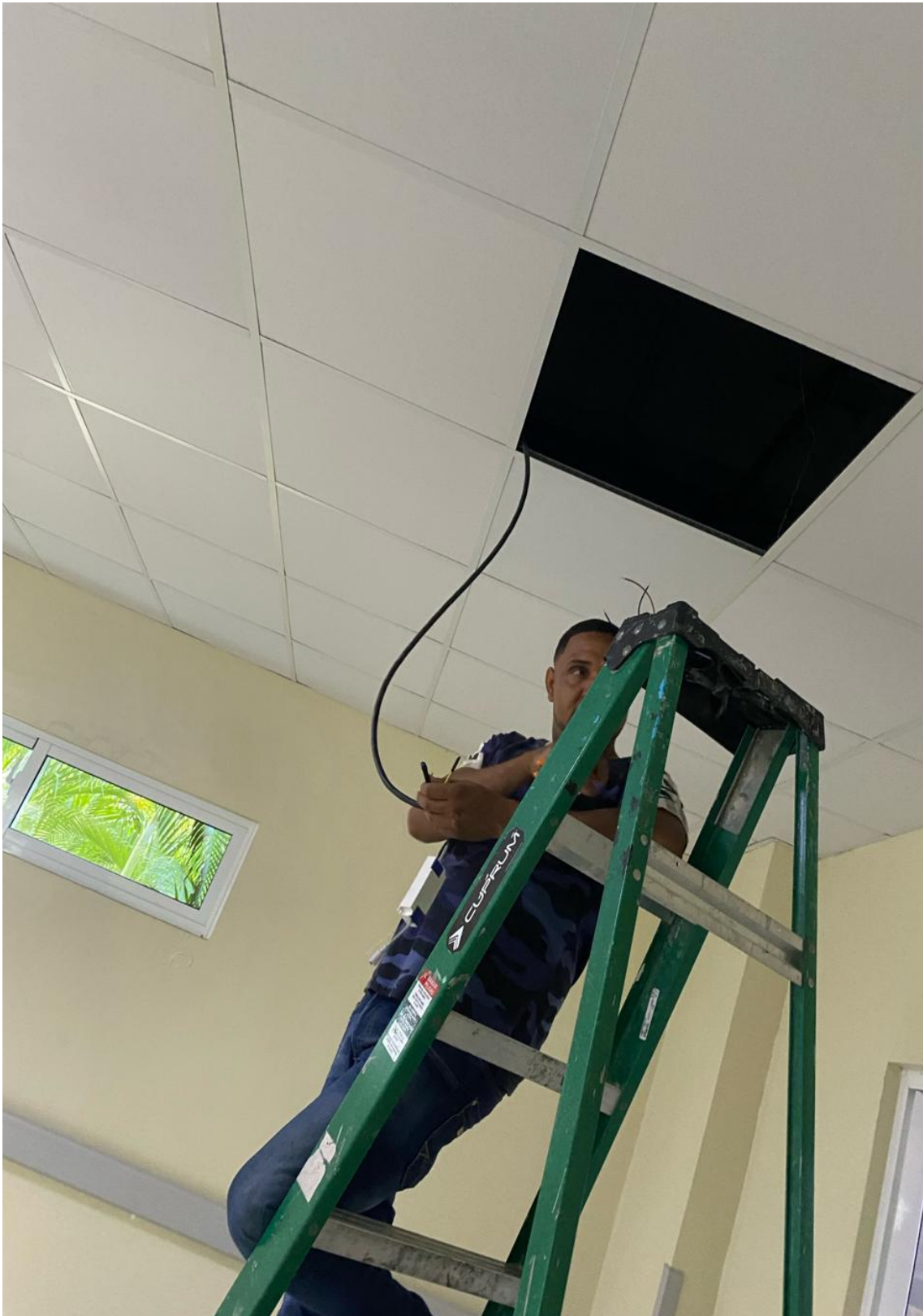
Cambio de lámpara en pasillo de internamiento 04/03/2024
