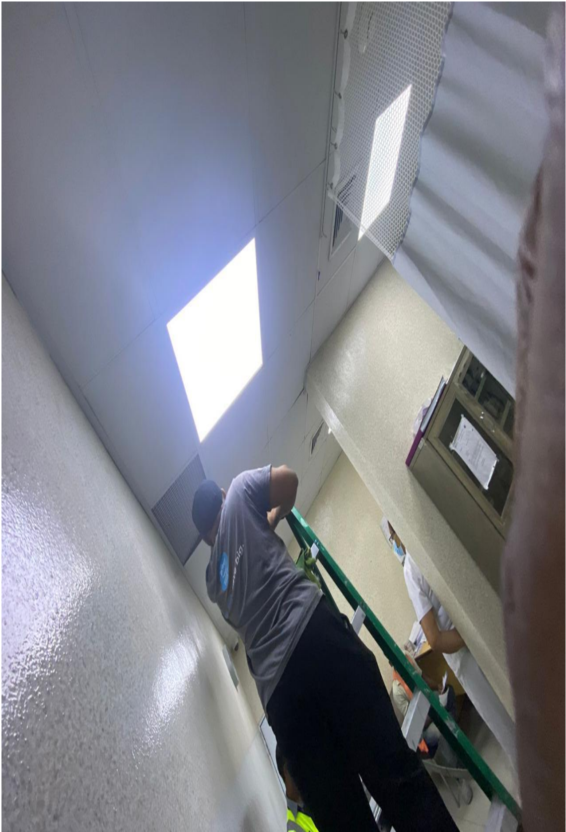
Limpieza de filtos de aire 07/03/2024
