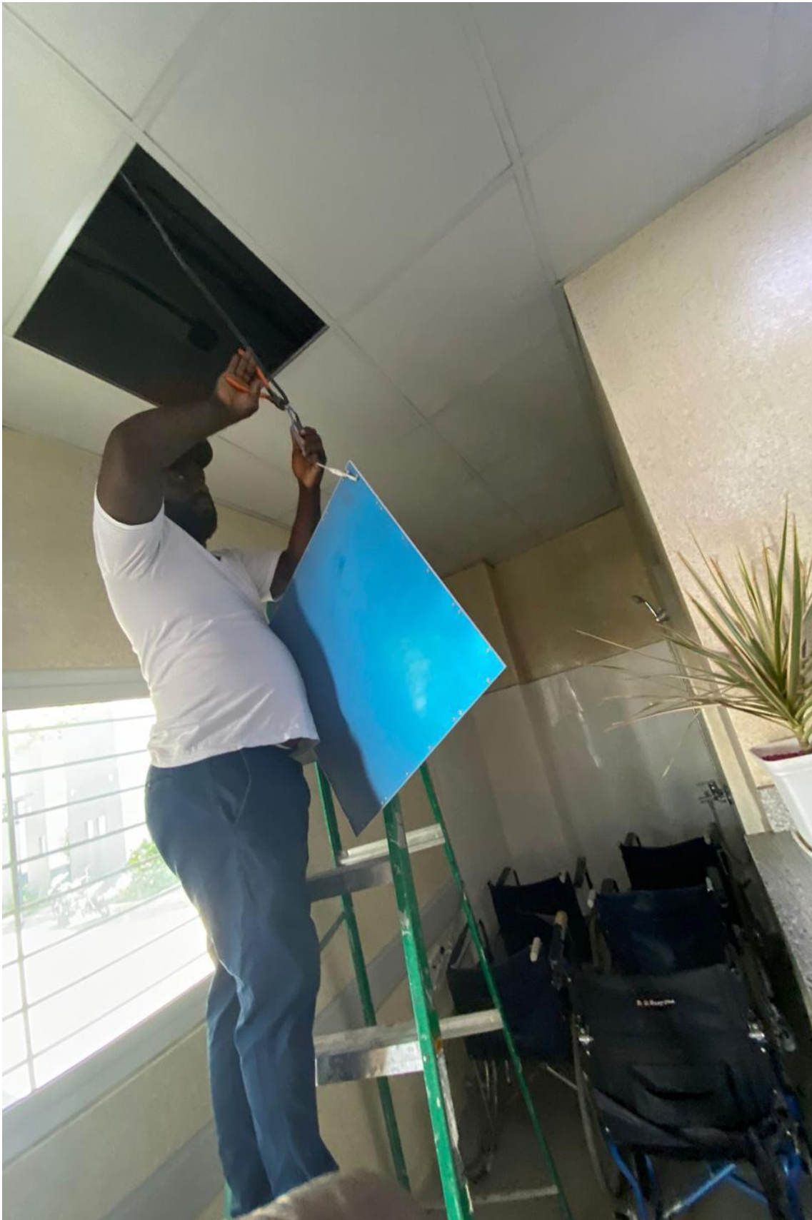
Cambio de lámpara en pasillo trauma shock 07/03/2024
