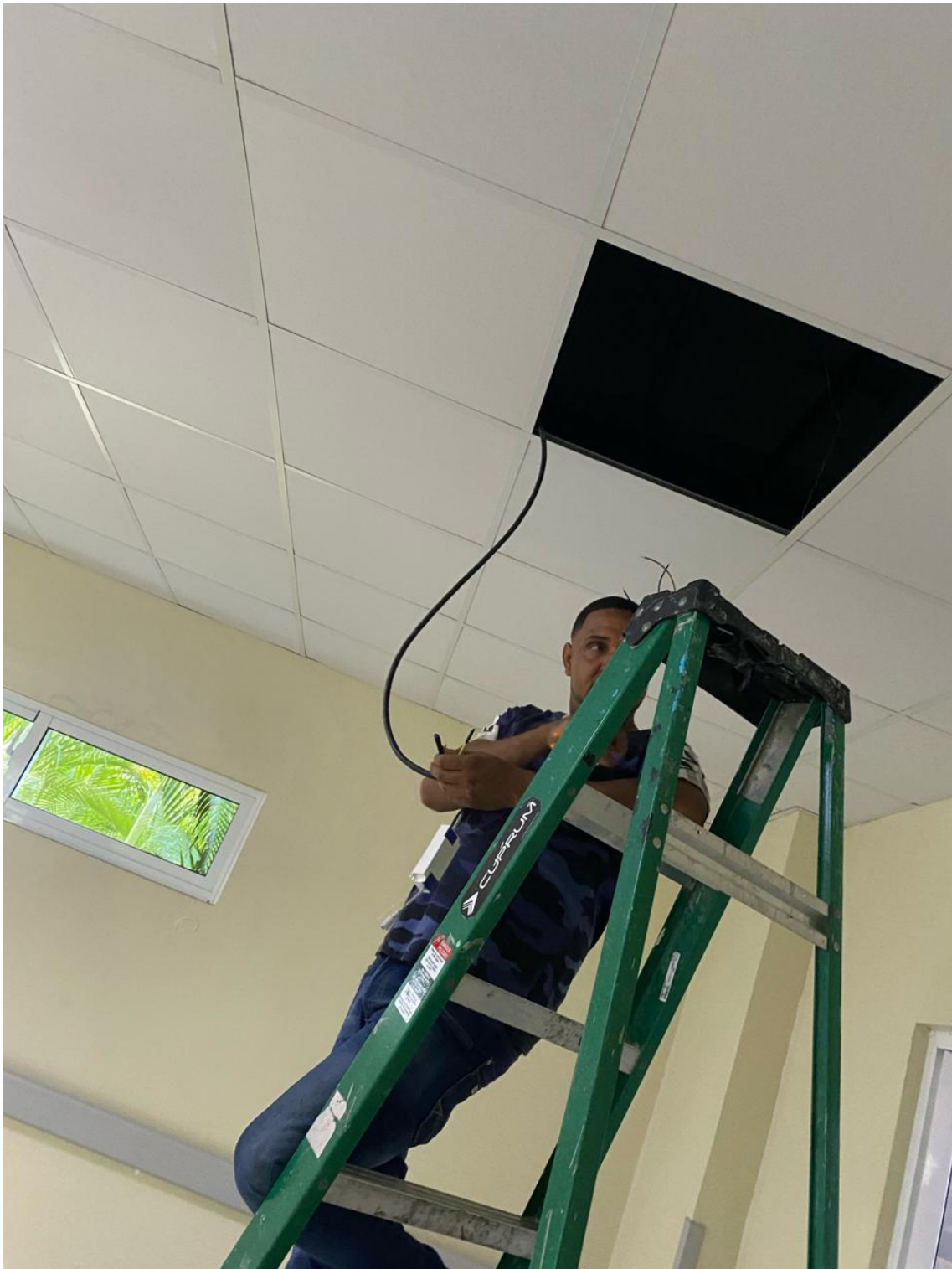
Pasillo de internamiento 04/03/2024
