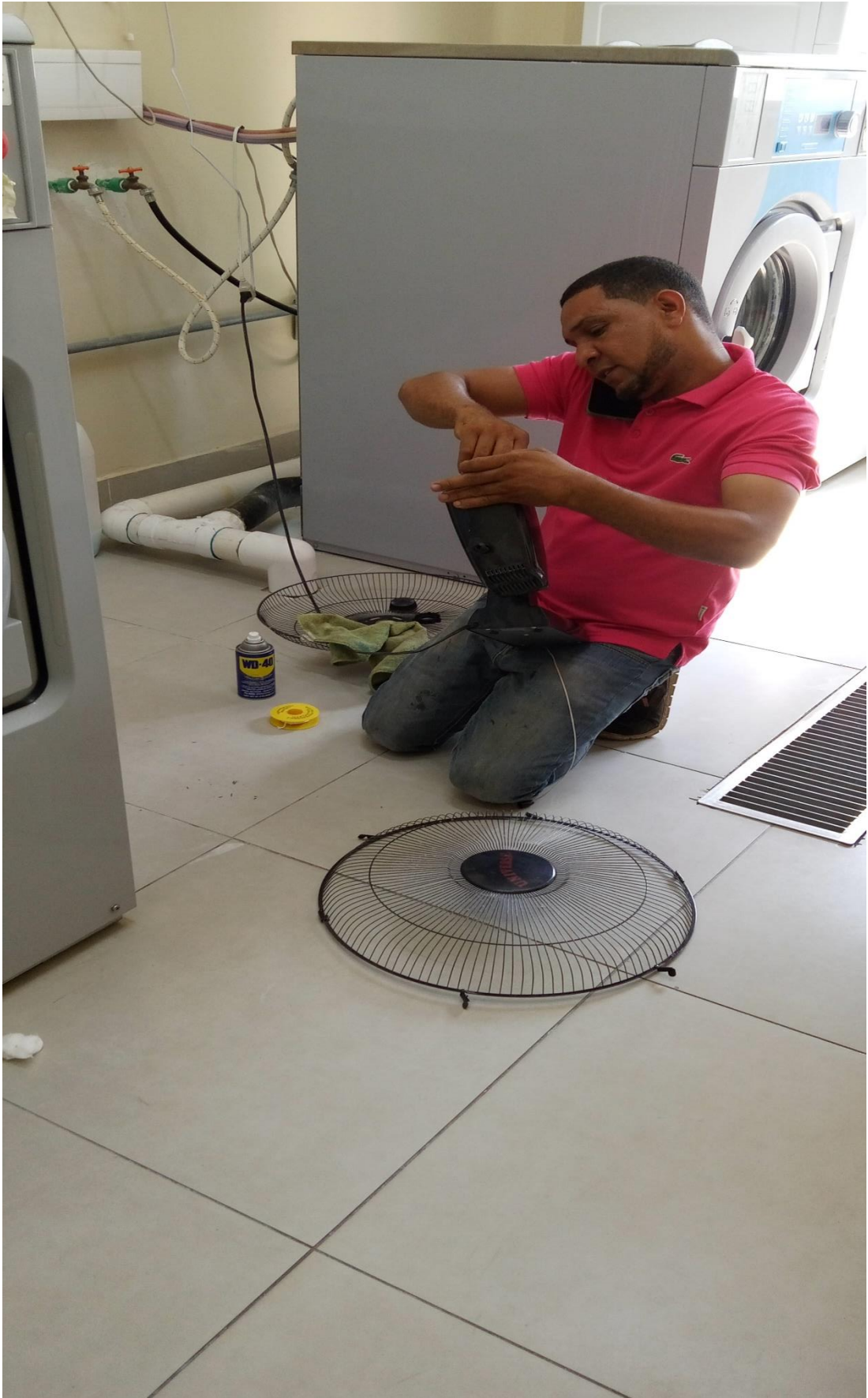
Mantenimiento abanico de lavanderia 18/03/2024
