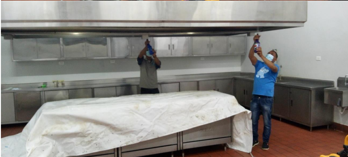
Limpieza de extractor 07/03/2024
