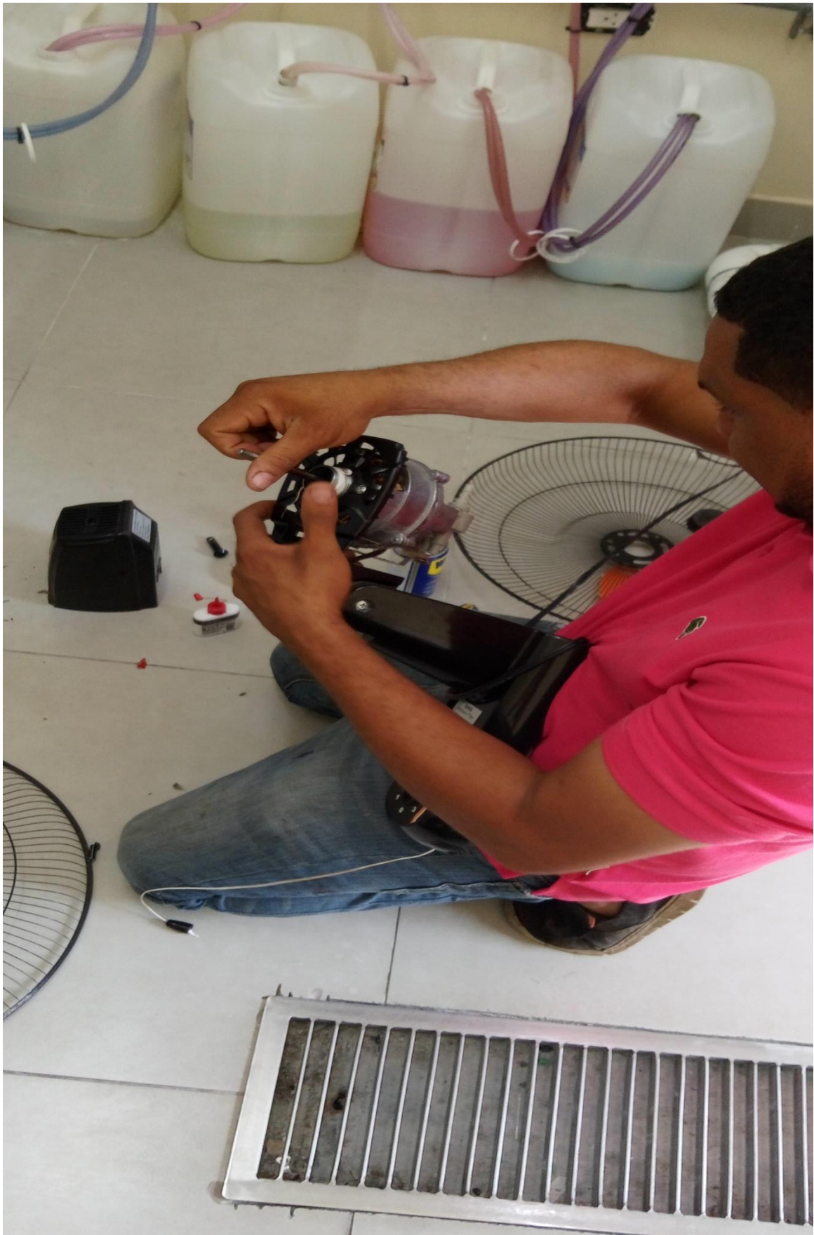
Mantenimiento abanico de lavanderia 18/03/2024
