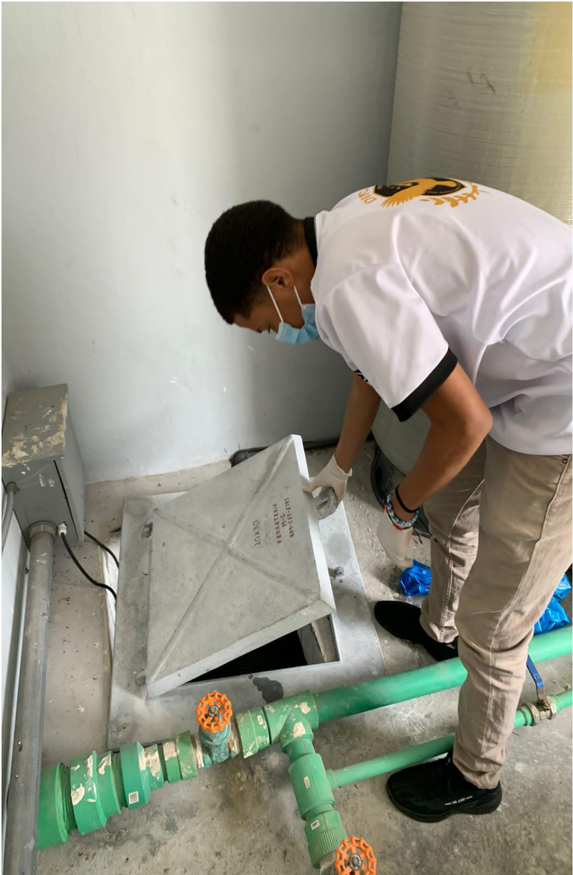
Clorificación a la cisterna 15/03/2024
