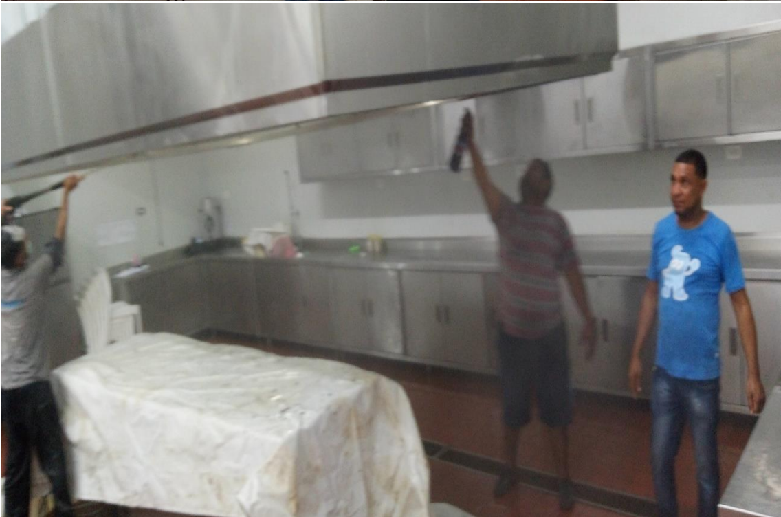
Limpieza de extractor 07/03/2024
