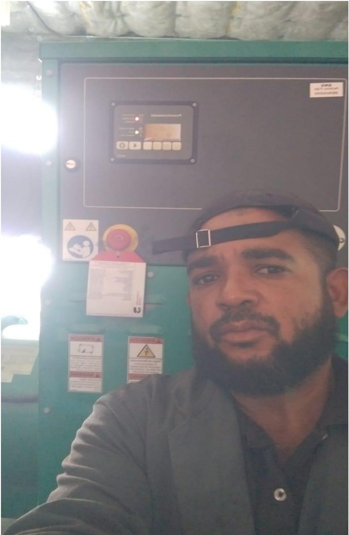
Mantenimiento a planta eléctrica 26/03/2024
