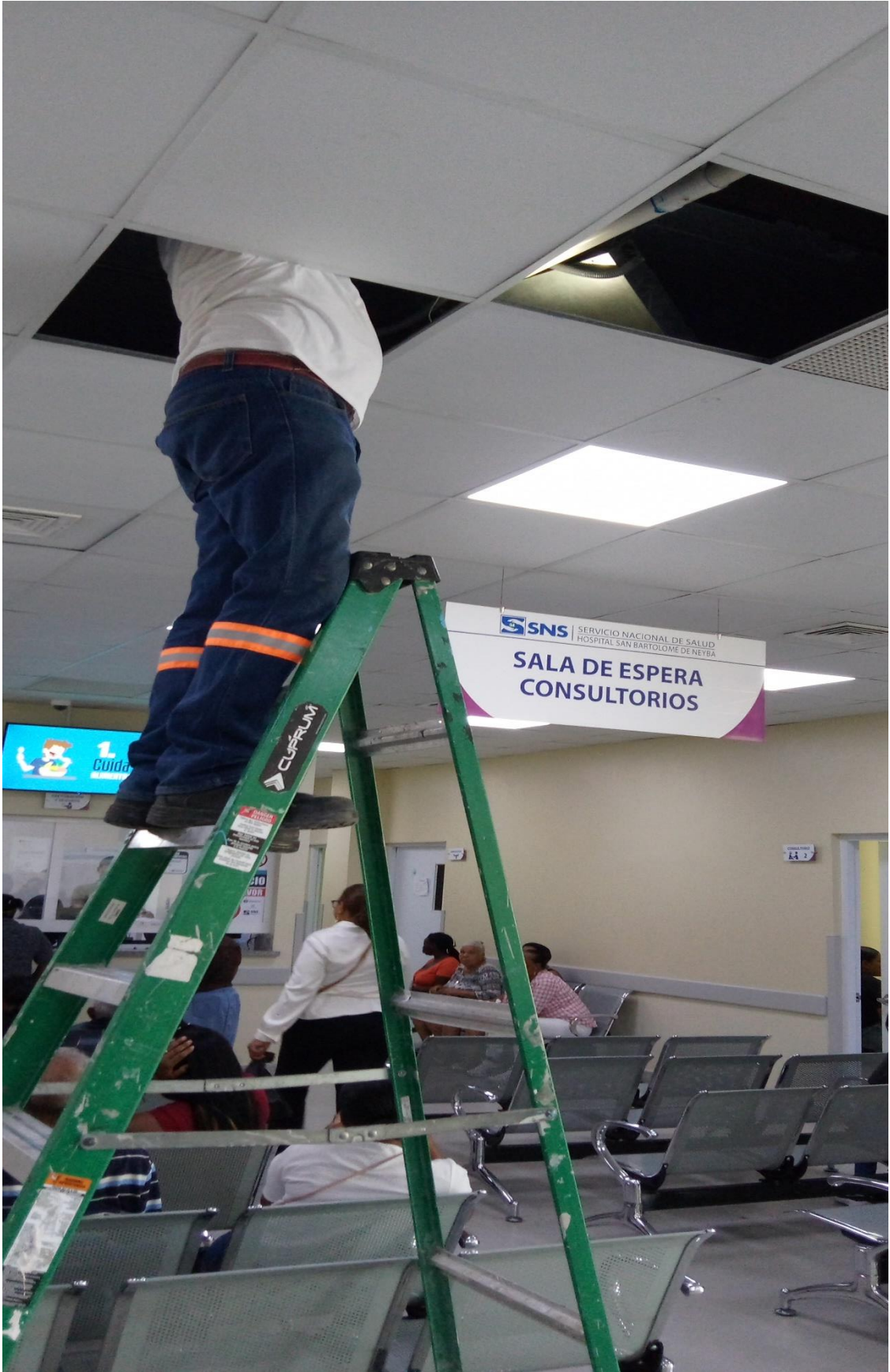
Aire acondicionado de facturación 01/03/2024
