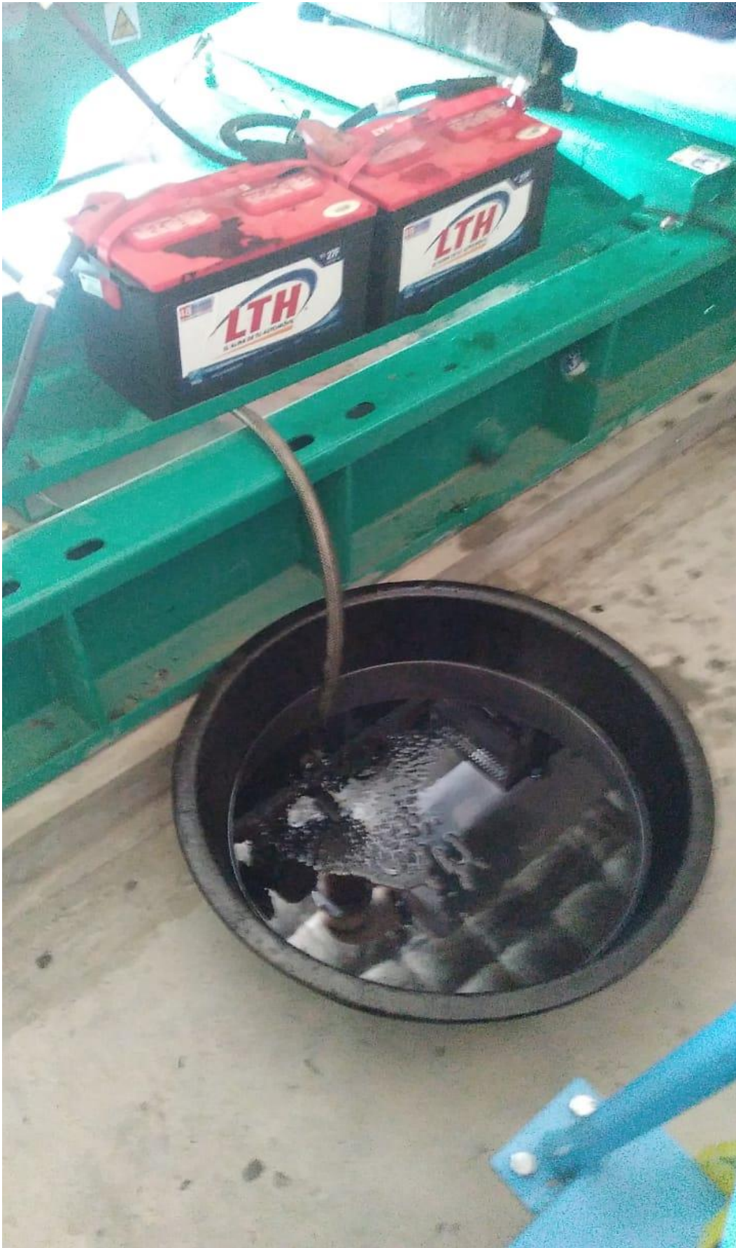
Mantenimiento a planta eléctrica 26/03/2024
