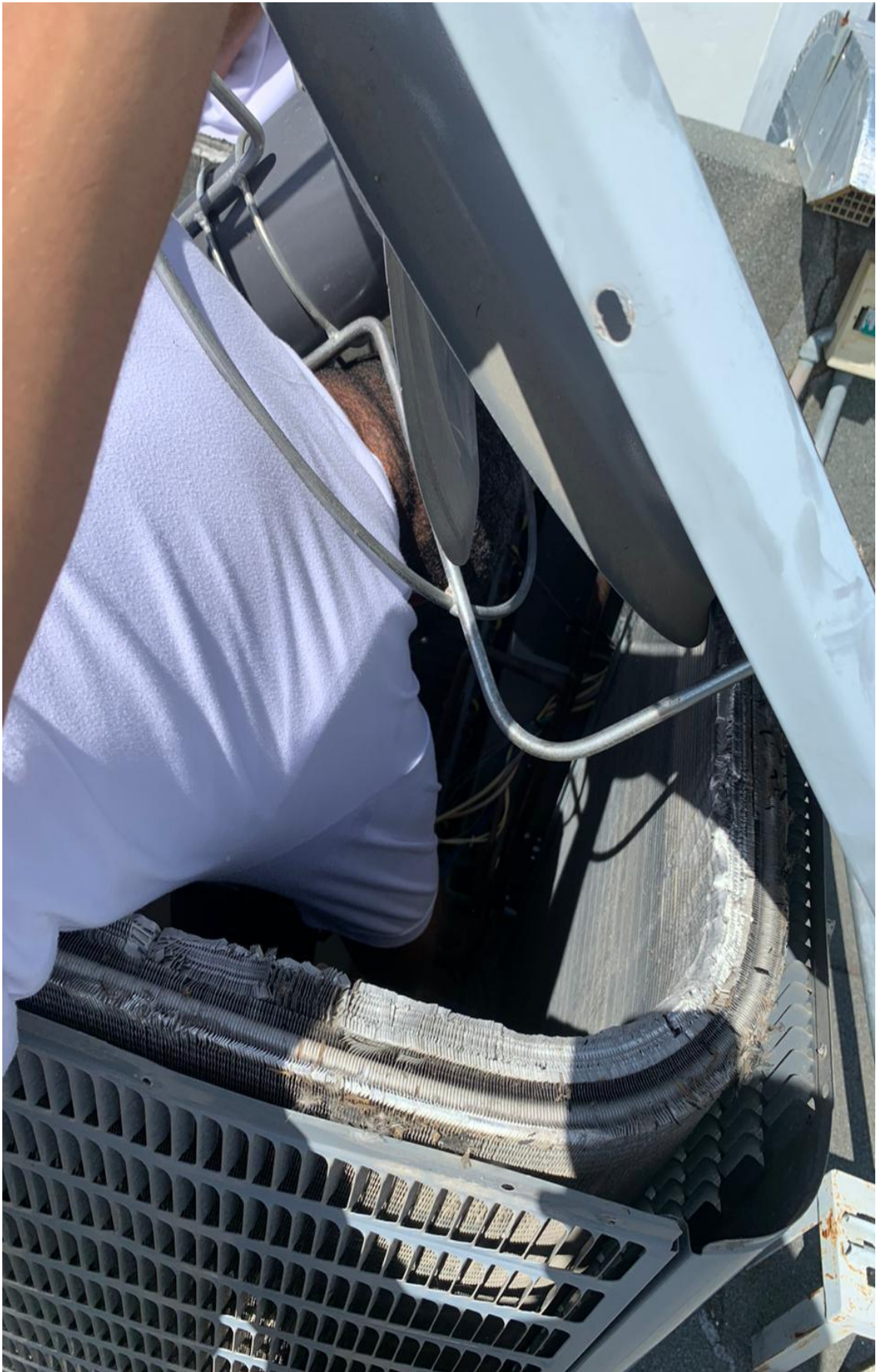
Mantenimiento aire acondicionado 01/03/2024
