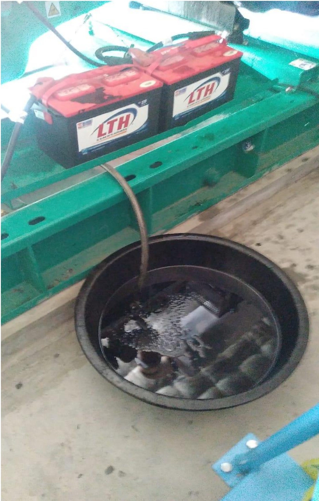
Mantenimiento a planta eléctrica 26/03/2024
