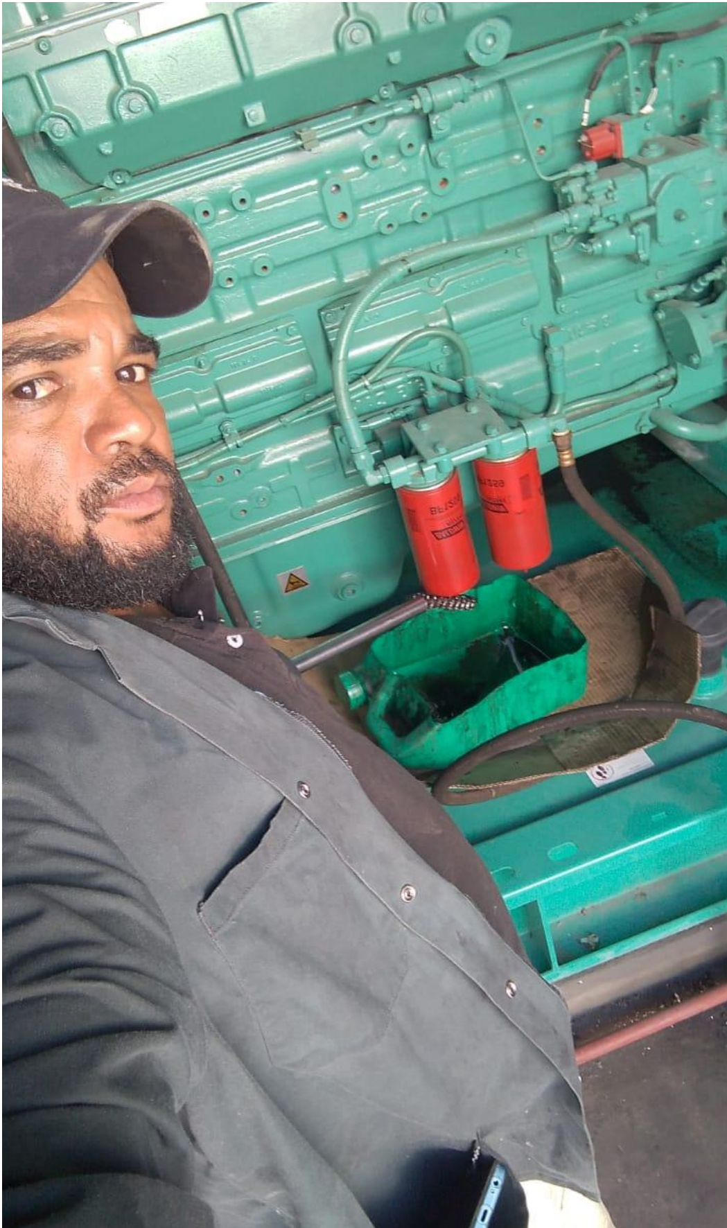
Mantenimiento a planta eléctrica 26/03/2024
