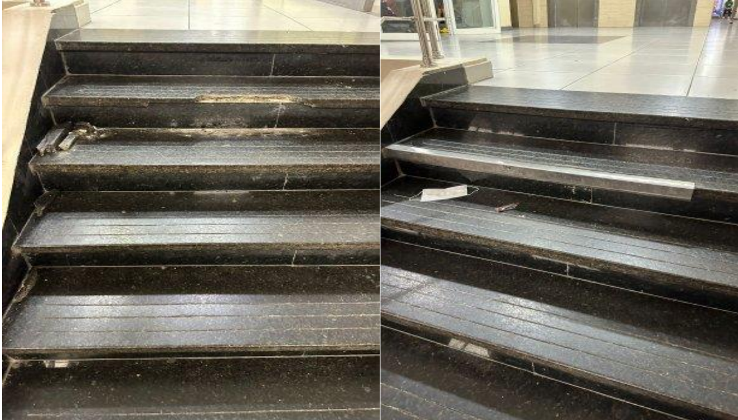
Reparación escalera del edificio de hospitalización
