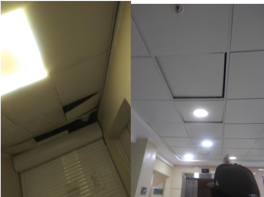
Reparación del plafón del área de imágenes diagnóstico.
