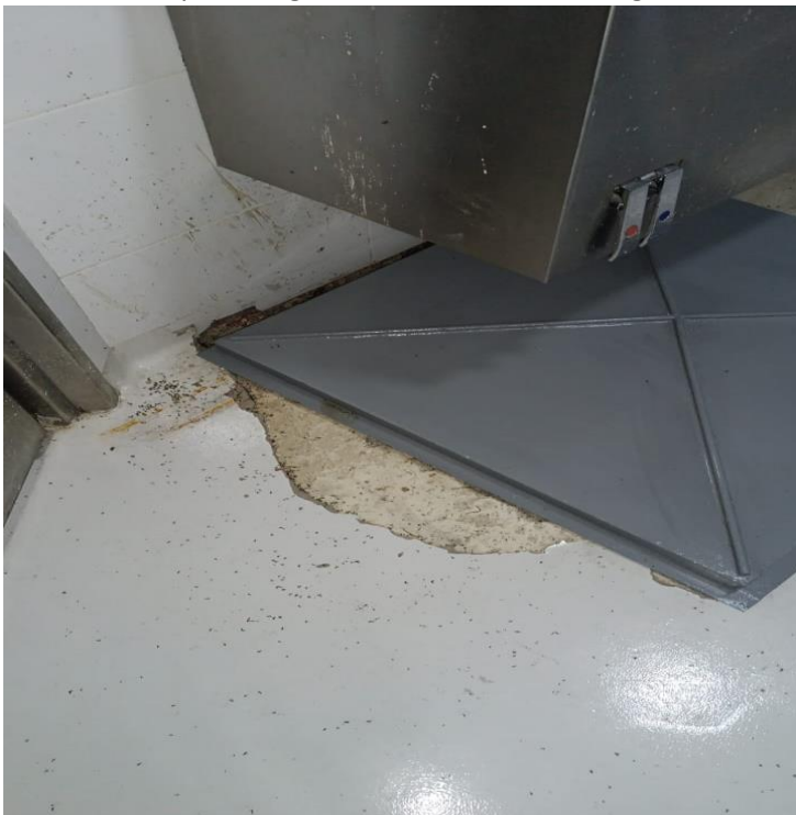
Colocación tapa de registro en el área de la morgue
