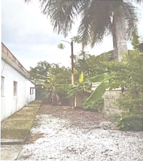
Luminaria patio Salón de Actividades
