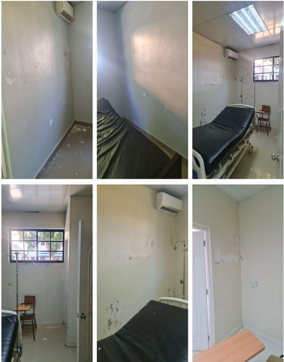
Pintura Privados Área A1 (Antes)
