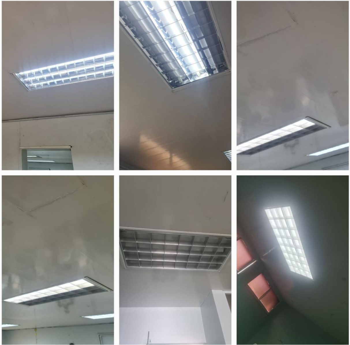
Mantenimiento de Lámparas Eléctricas techos Área Hemodiálisis (Antes)
