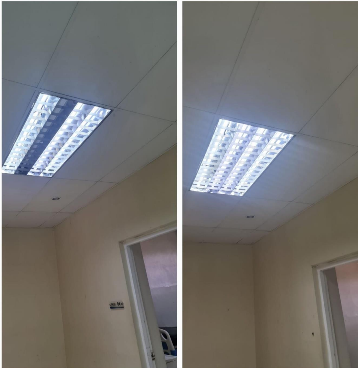
Mantenimiento de Lámparas Eléctricas techos Privados Área A1 (Antes/Ahora)
