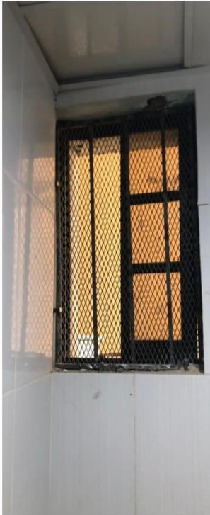
Colocación de Hierro y Malla Metálica en Habitación de Unidad en Crisis (Psiquiatría)
