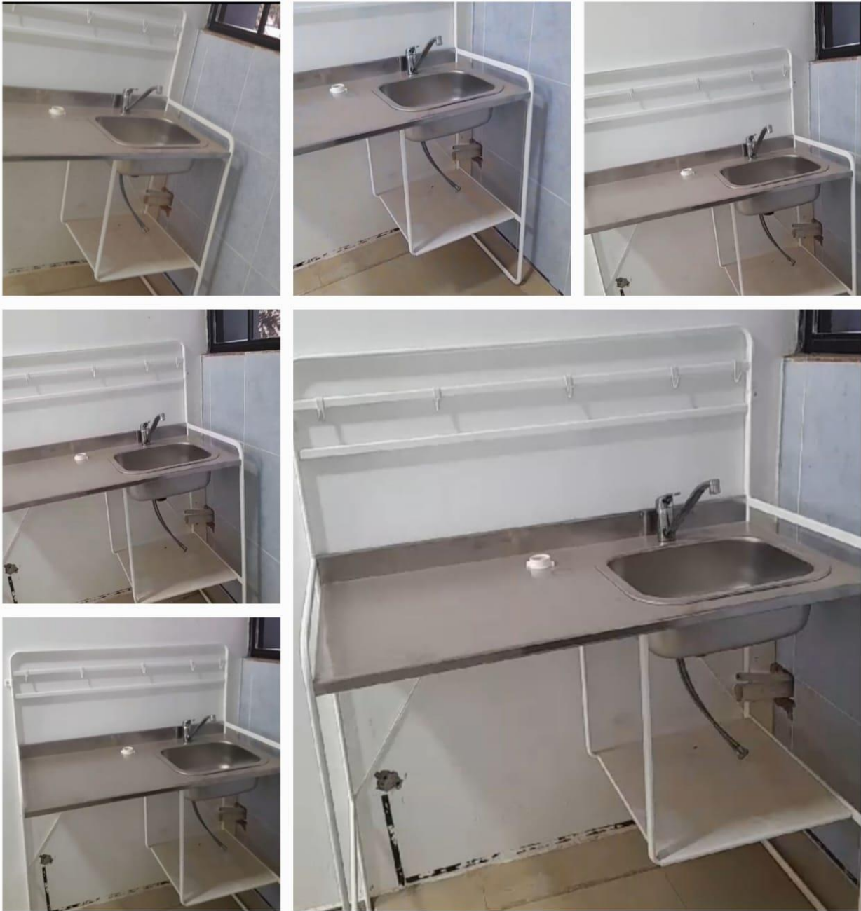
Colocación de Fregadero en Área de Terapia Ambulatoria
