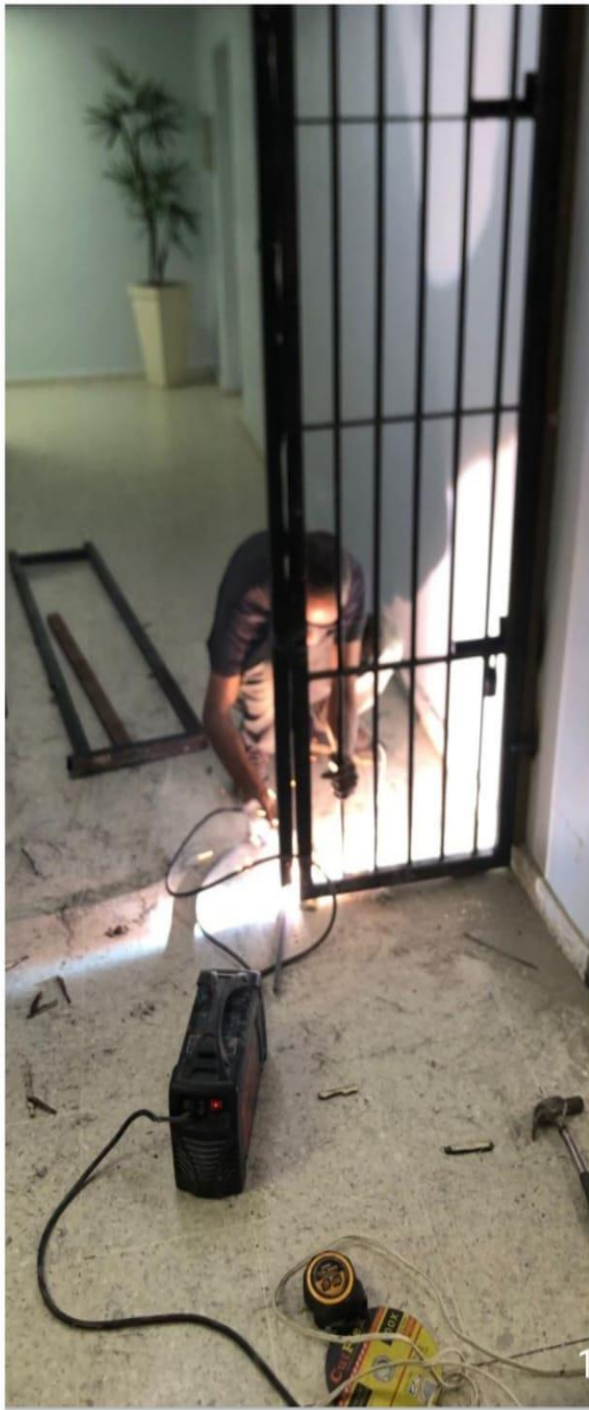
Colocación de Puertas en Hierro en Pasillo de la Emergencia de Maternidad
