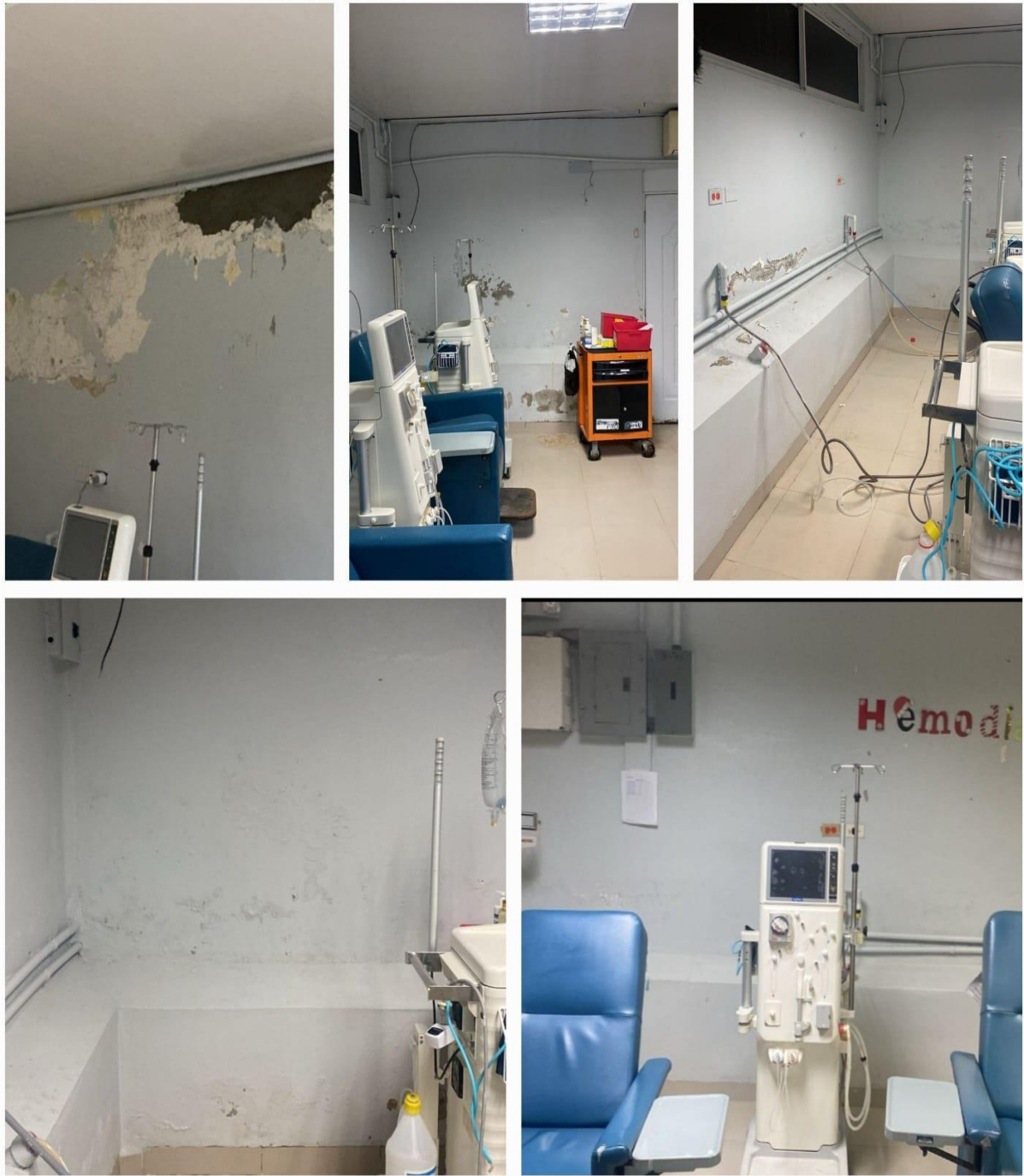
Pintura del área de Hemodiálisis (Antes)
