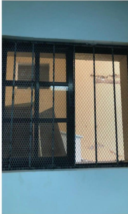
Colocación de Hierro y Malla Metálica en Habitación de Unidad en Crisis (Psiquiatría)
