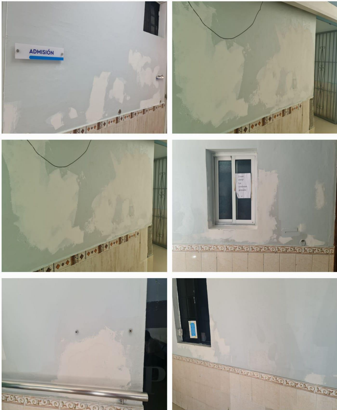
Pintura Pasillos y Áreas de Espera UCIS y Área A1 (Durante)
