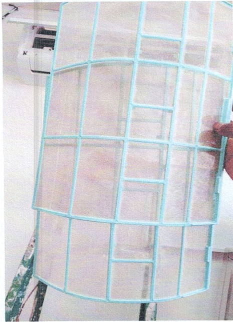
SALA DE PARTO: MANTENIMIENTO A AIRE ACONDICIONADO SPLIT TGM LIMPIEZA DE FILTROS
