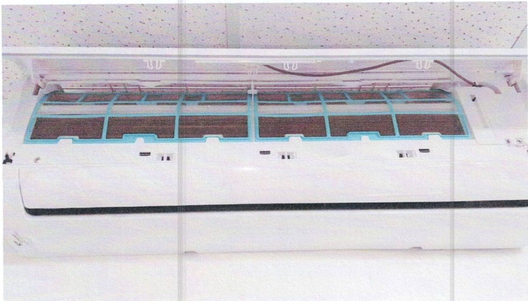
SALA DE PARTO: MANTENIMIENTO A AIRE ACONDICIONADO SPLIT TGM LIMPIEZA DE FILTROS
