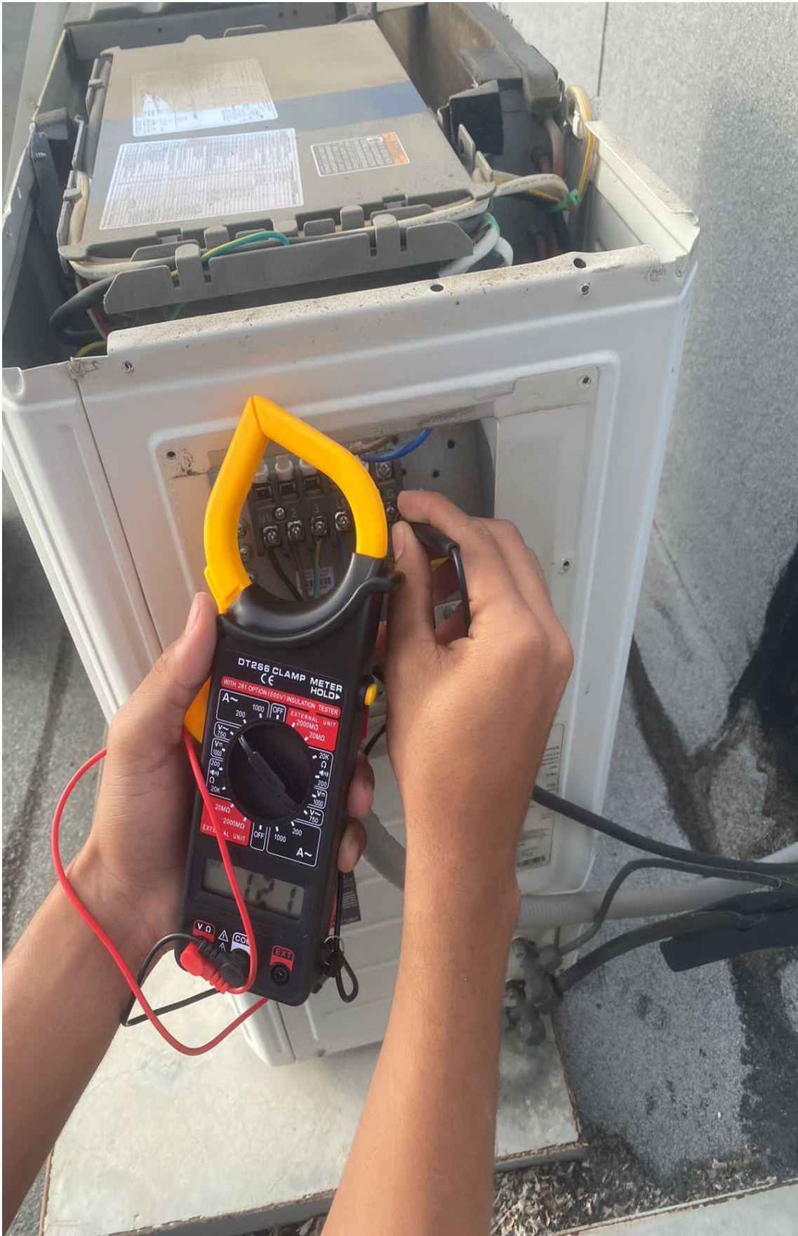
Revisión de voltaje 02/02/2024
