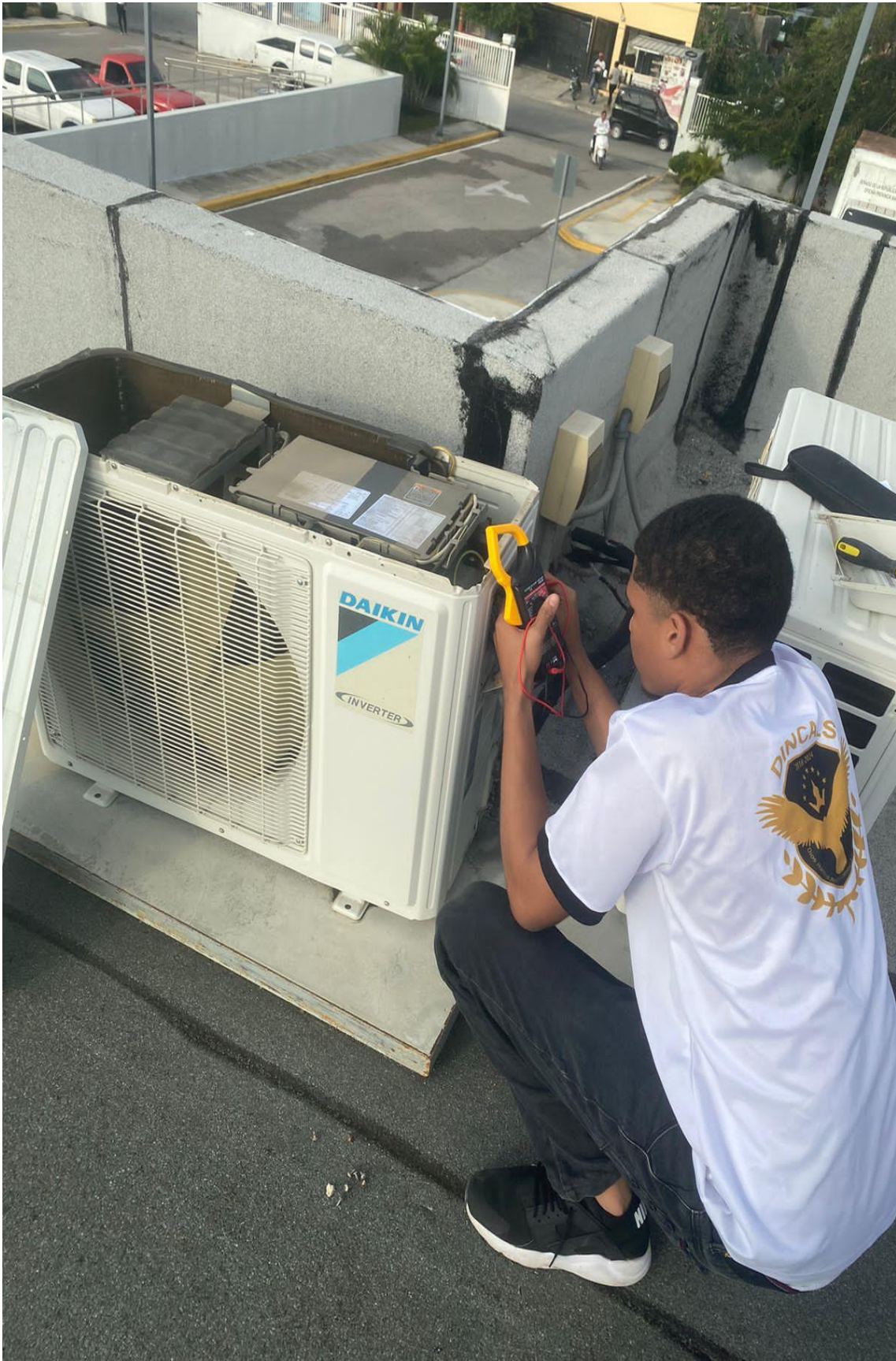
Revisión de voltaje 02/02/2024
