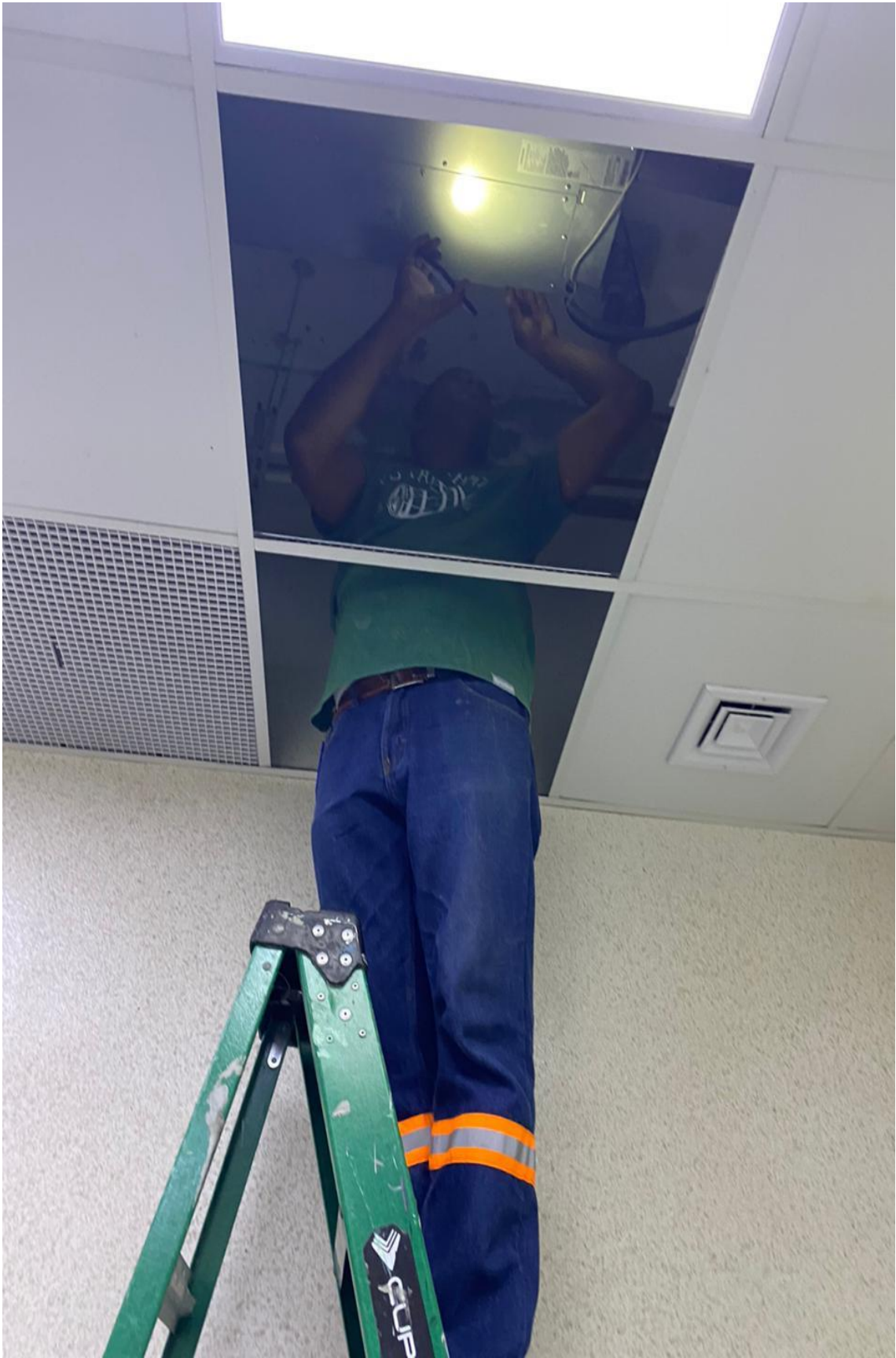
Aire acondicionado de cura 23/02/2024
