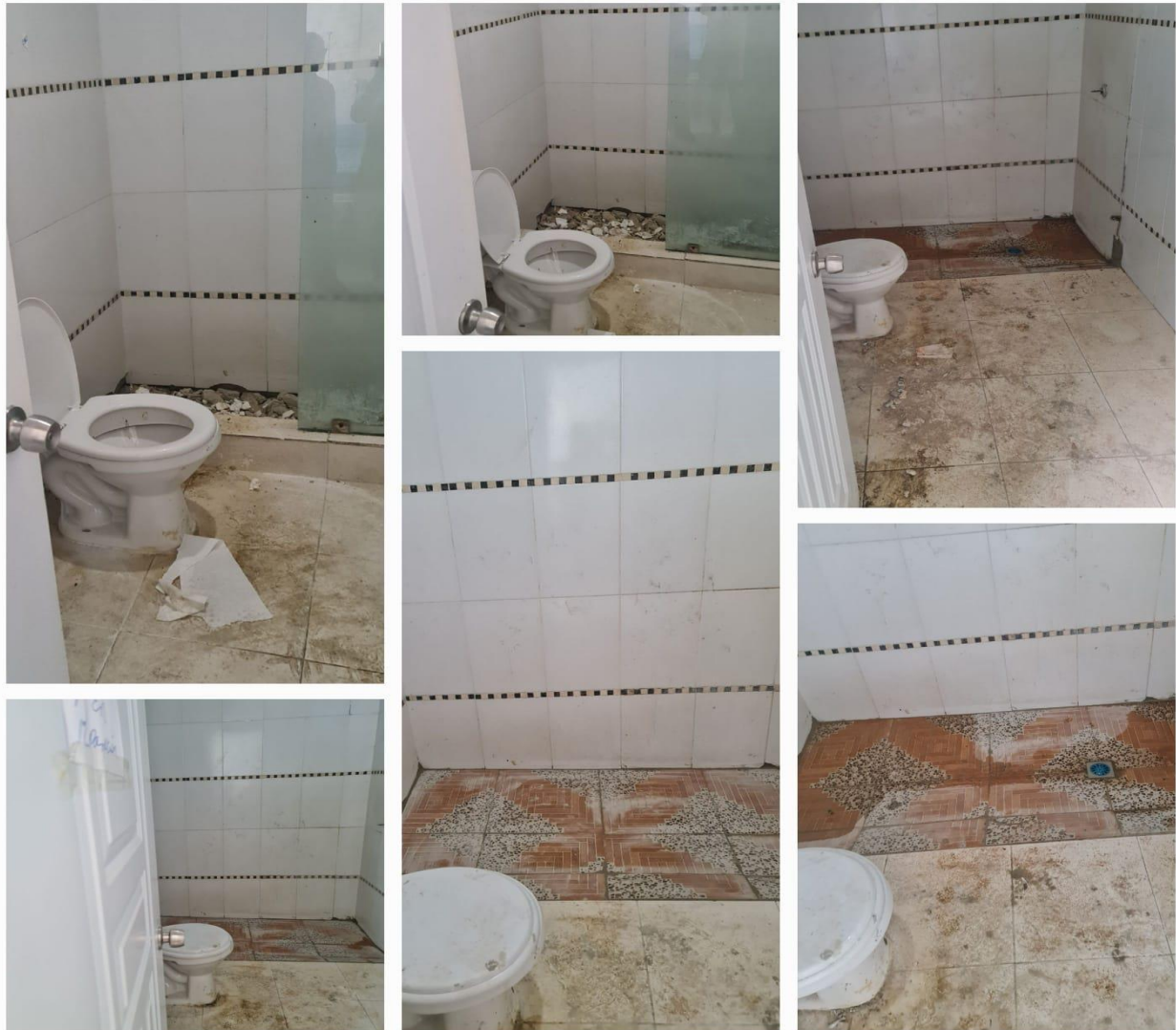
Mantenimiento de Baños: Pisos, Lavamanos, Inodoros, Desagües, Plomería (Antes, Durante y Ahora)
