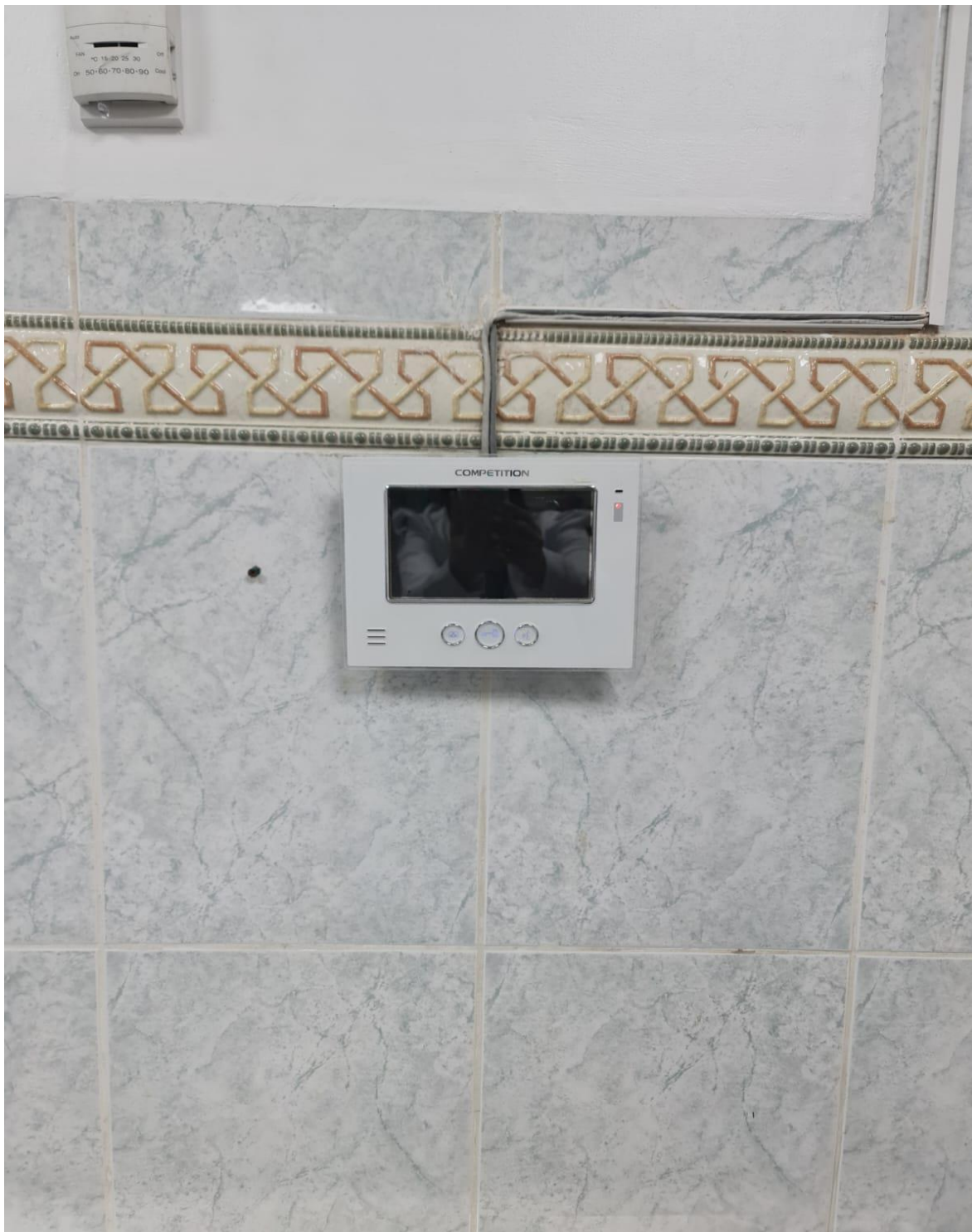
Colocación de Intercom en la UCI Polivalente
