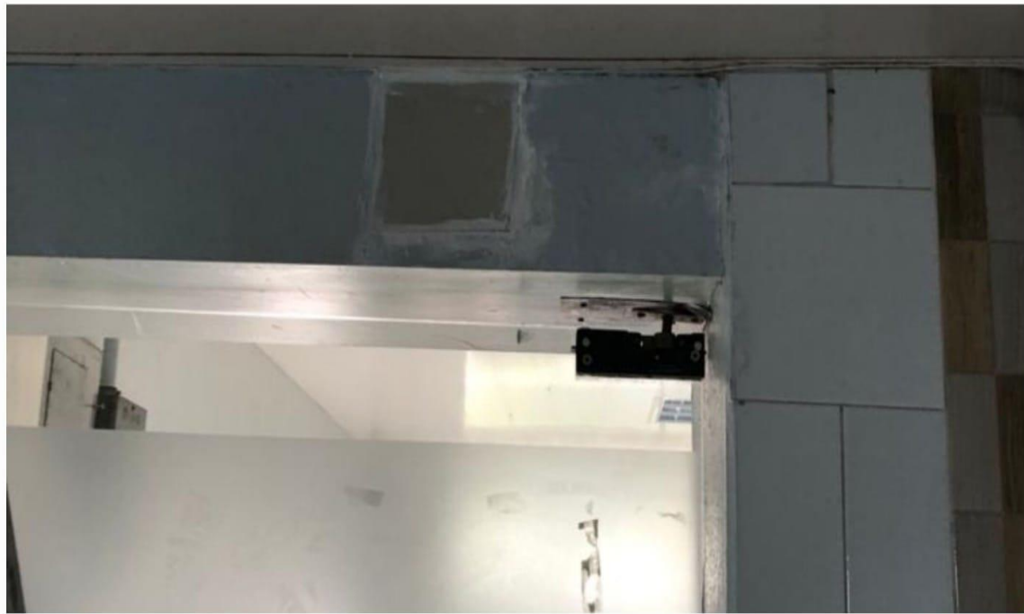
Mantenimiento de Paredes
