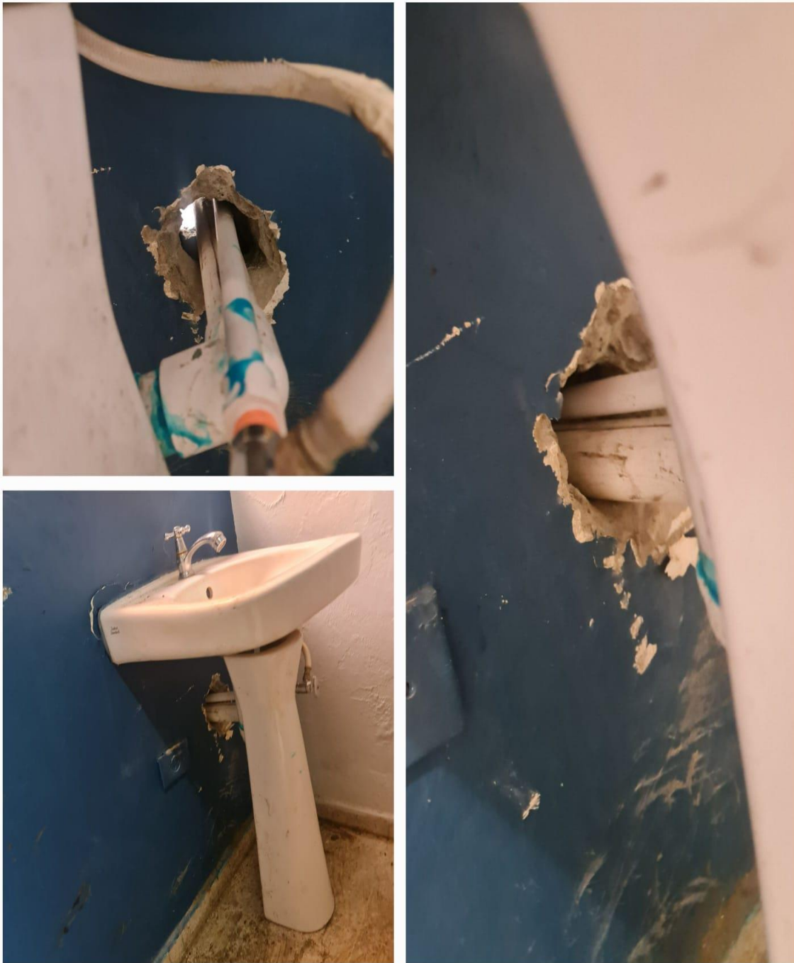
Trabajos de Plomería en Área de Vacunación
