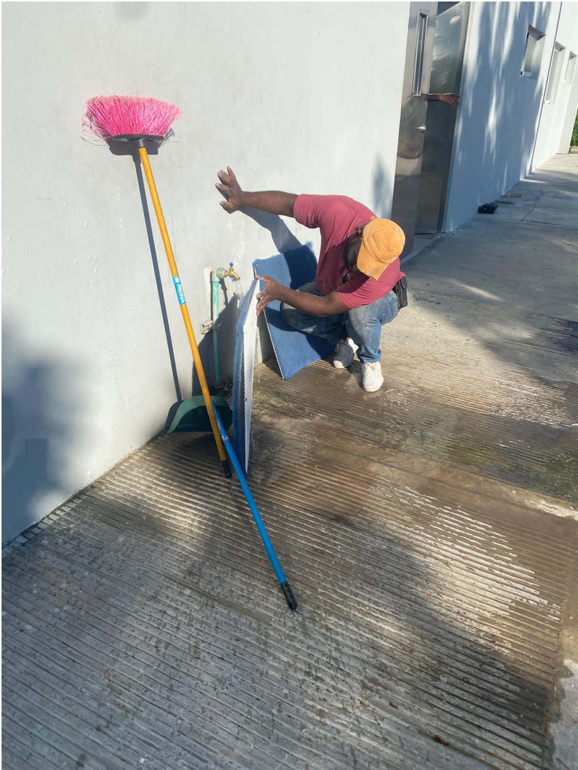
Mantenimiento de filtro de aire
