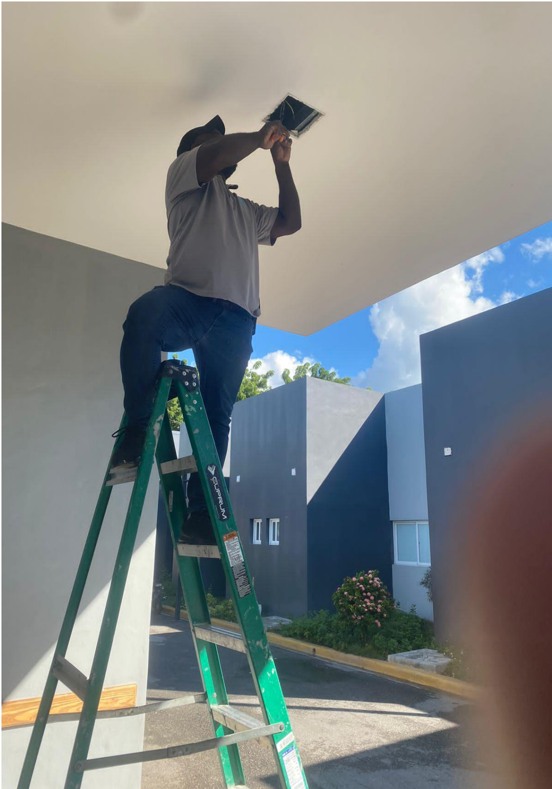
Cambio de lamparas cuadradas 18w 03/01/2024Mantenimiento de aire
