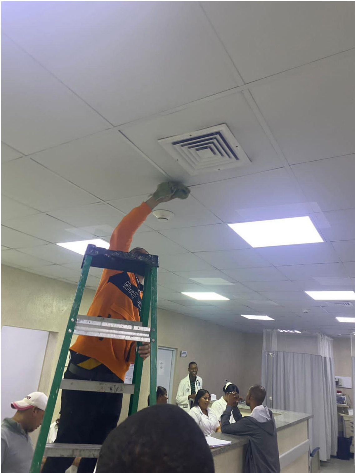
Limpieza de filtros y rendillas de aire 12/01/
