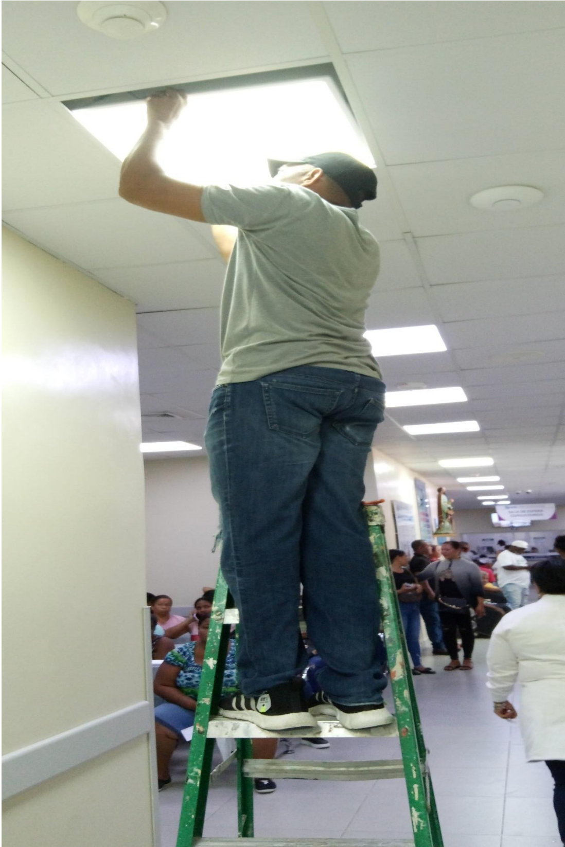
Cambio de lampara en pasillo de observacion 18/01/2024
