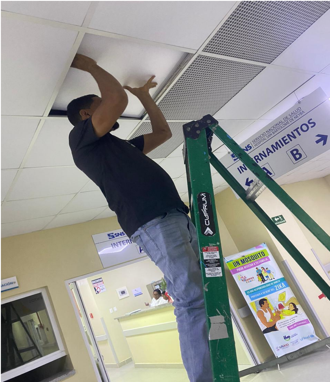
Pasillo de internamiento 01/09/2024
