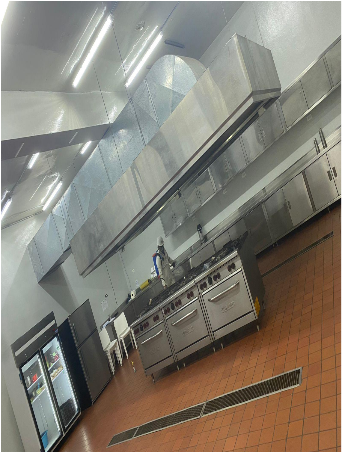
Fumigacion area de cocina 05/01/2024
