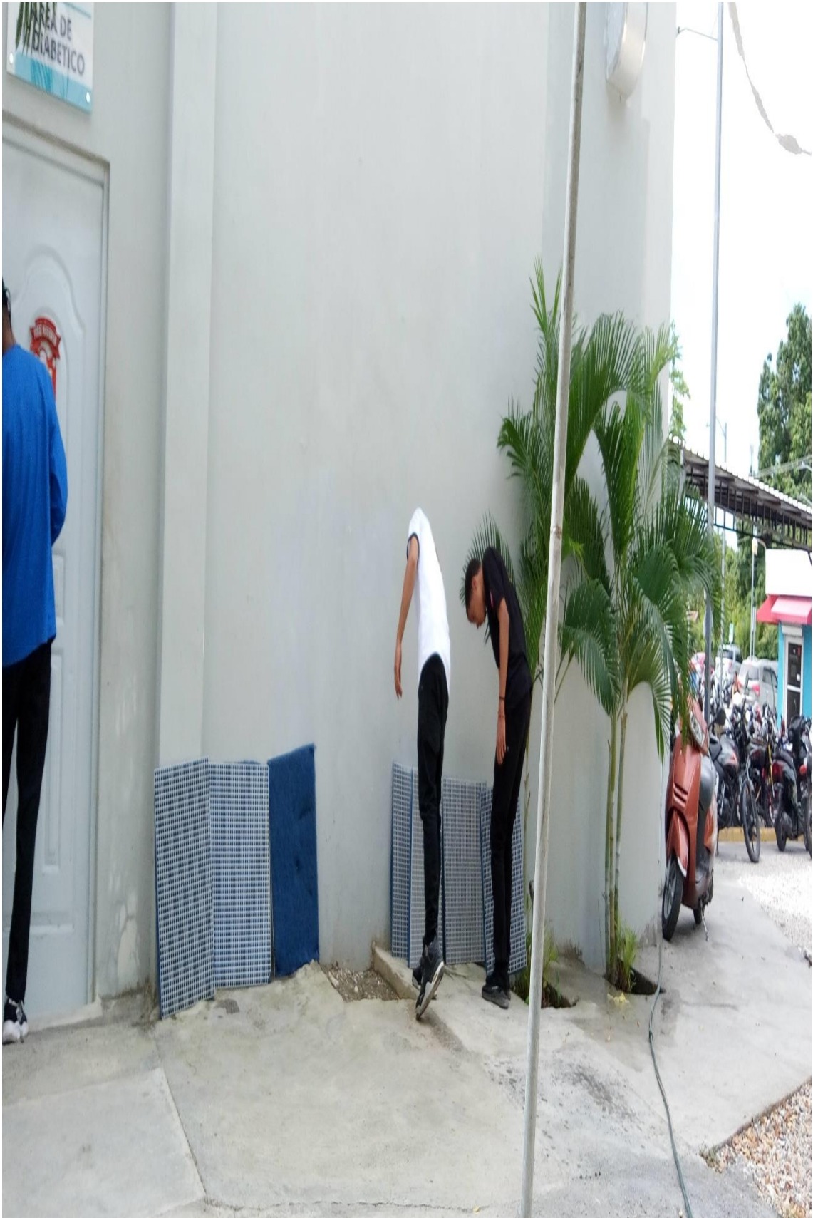
Limpieza de filtros 09/01/2024
