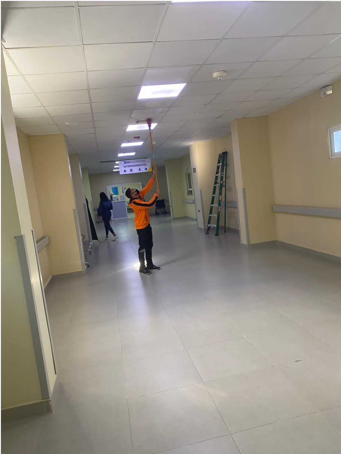
Limpieza de rejillas de aire en pasillo de internamiento 12/01/2024
