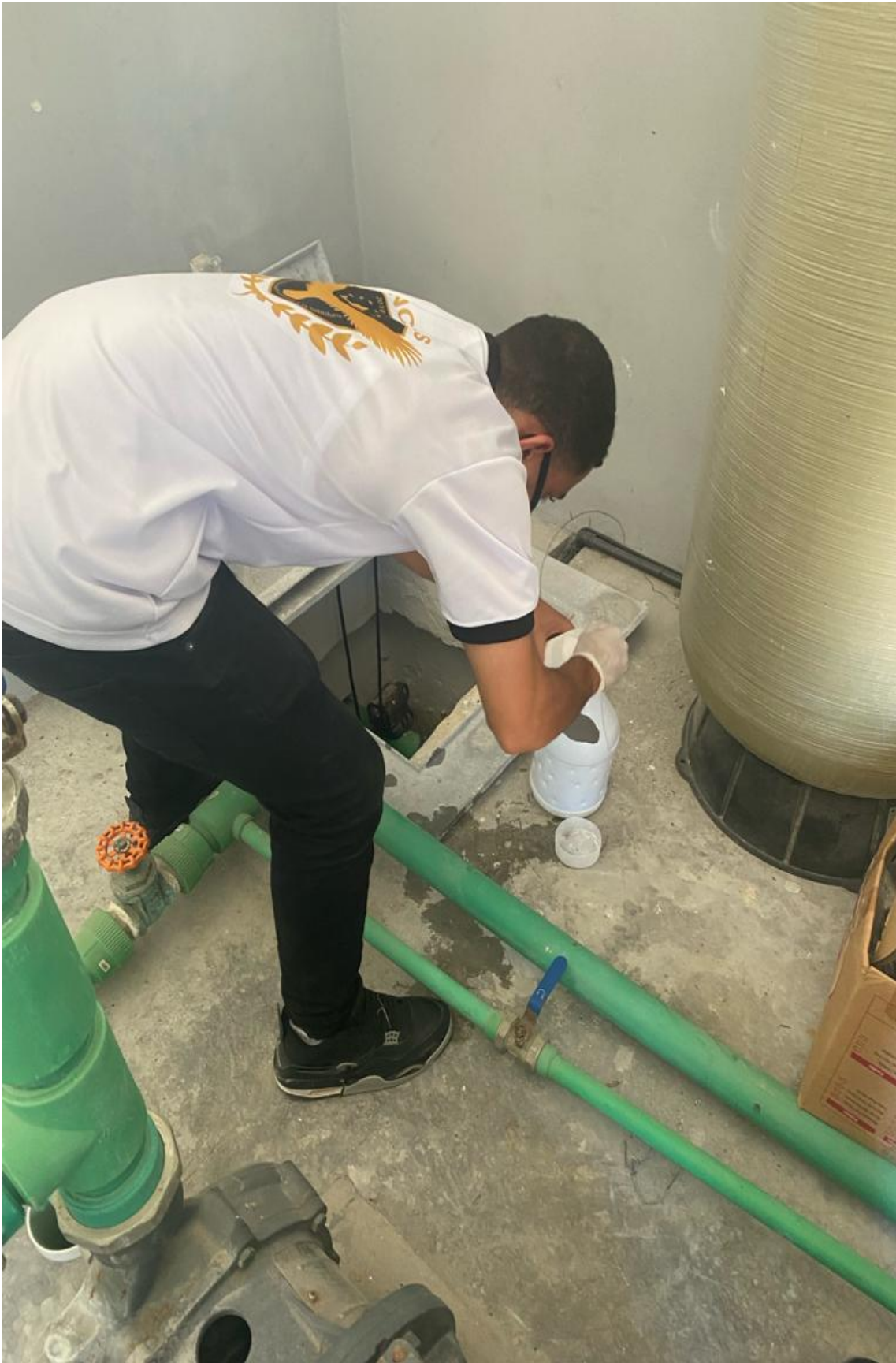
Clorificacion a cisterna 19/01/2024
