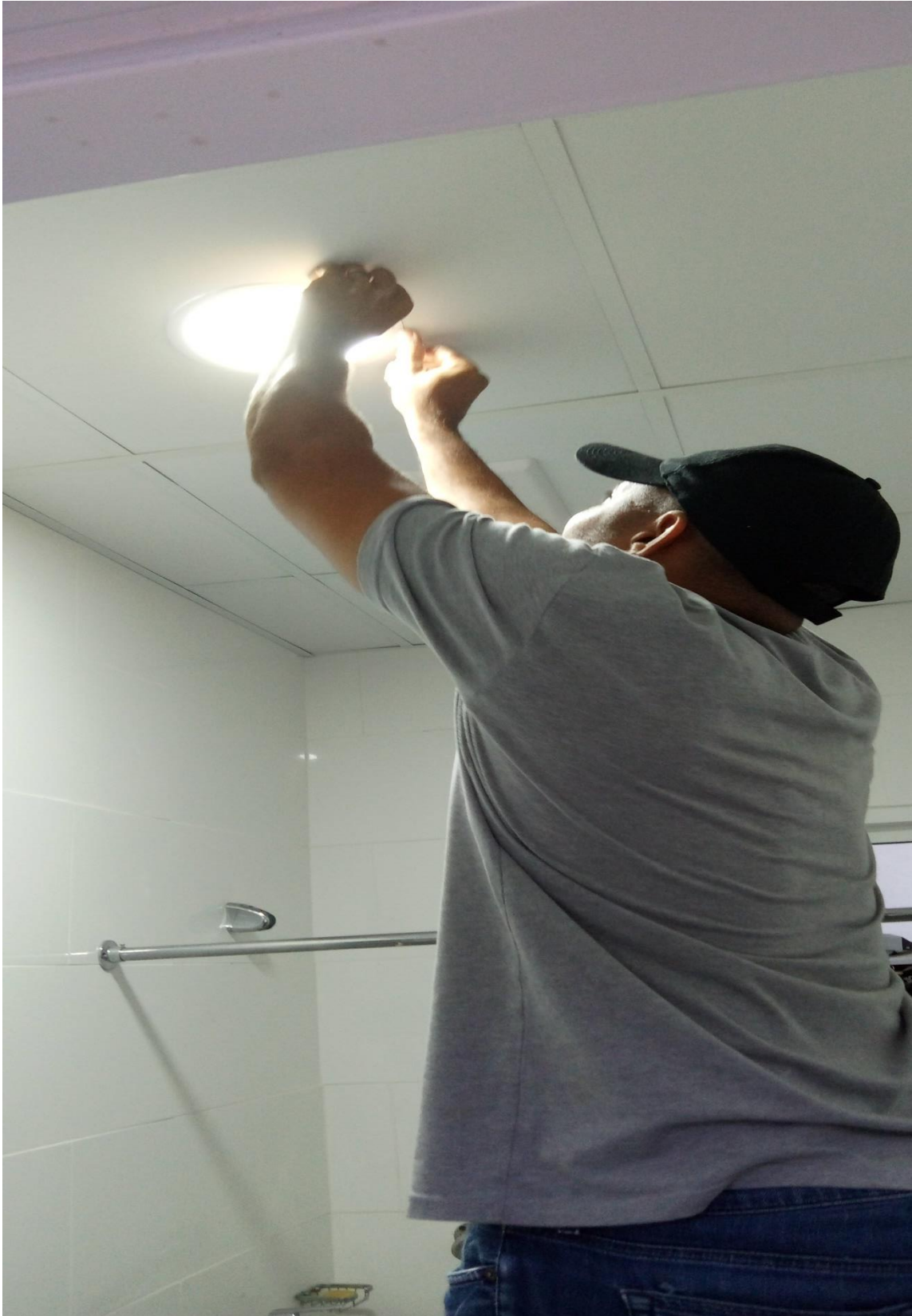
Cambio de lampara en baño de internamiento 18/01/2024
