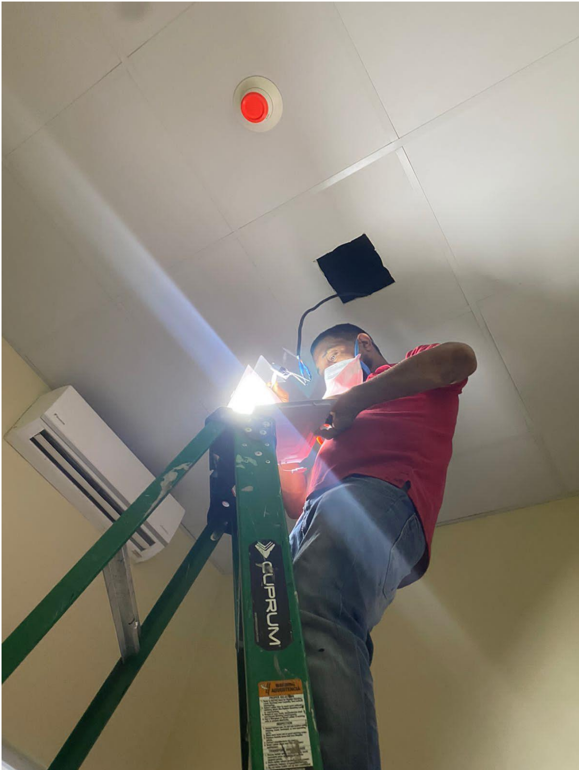
Cambio de transformador
