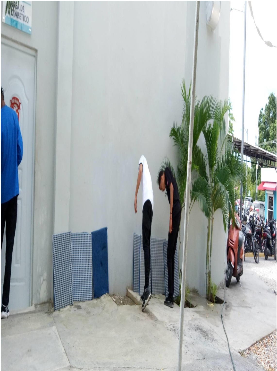
Limpieza de filtros 09/01/2024
