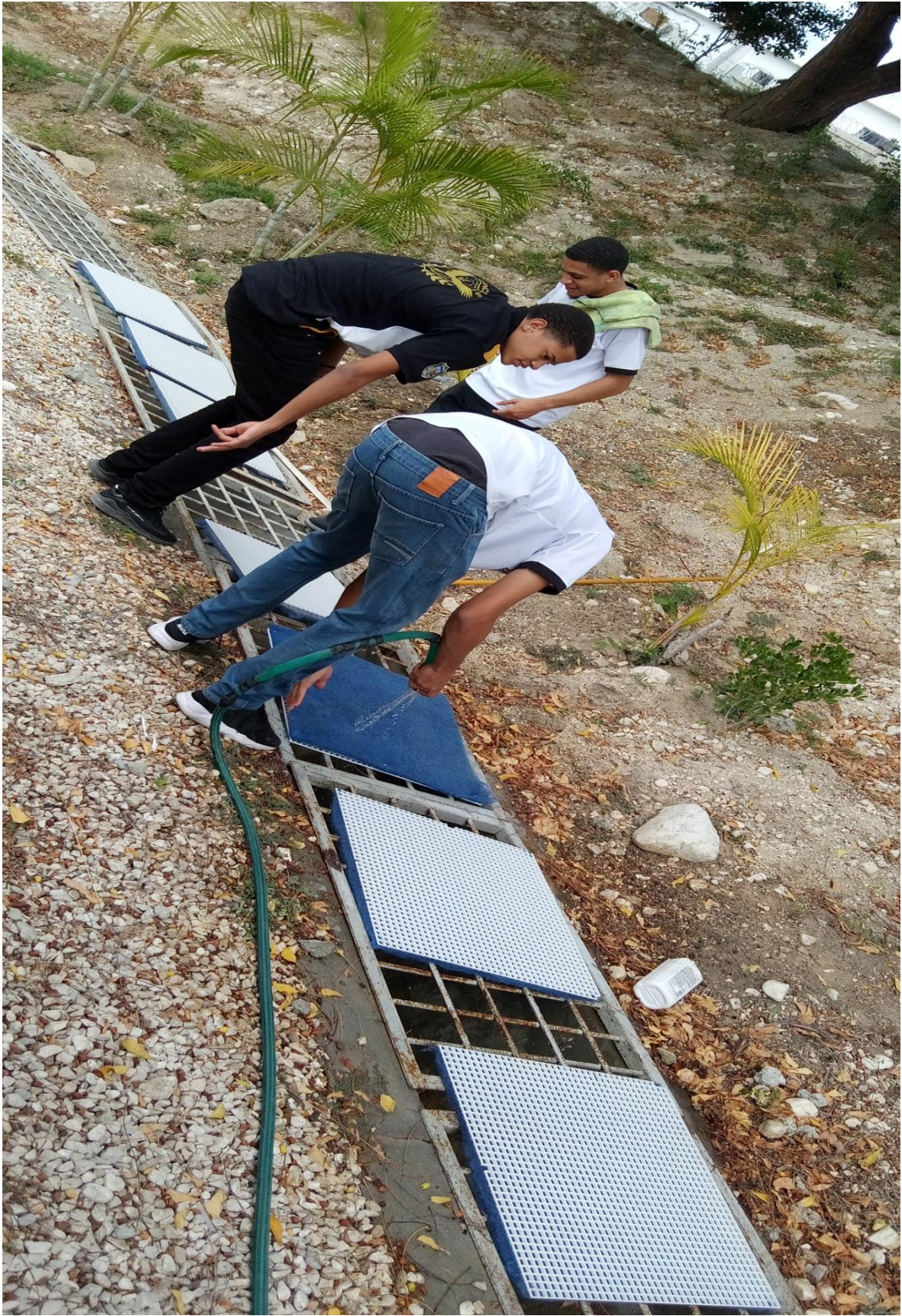
Limpieza de filtros 09/01/2024
