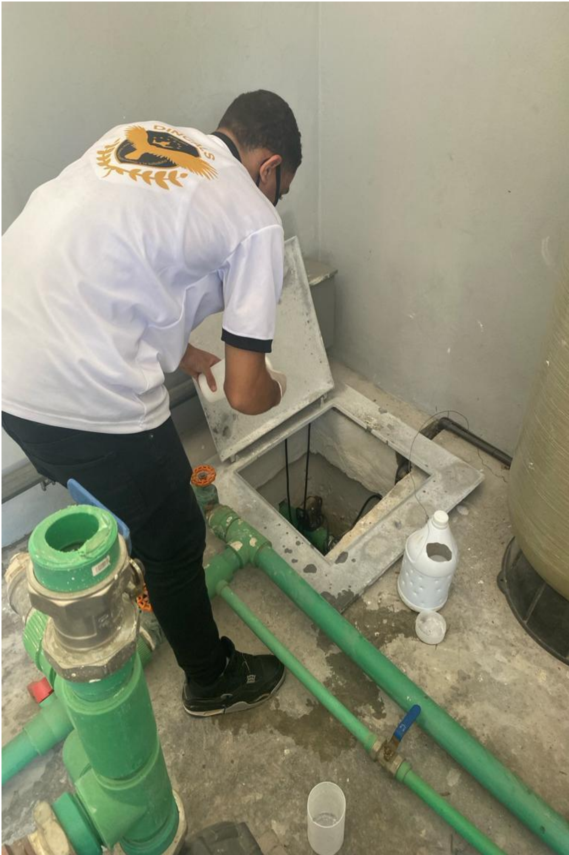
Clorificacion a cisterna 19/01/2024
