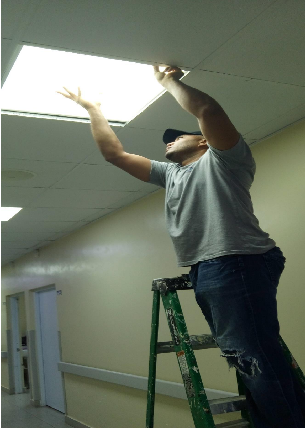
Cambio de lampara en pasillo 18/01/2024
