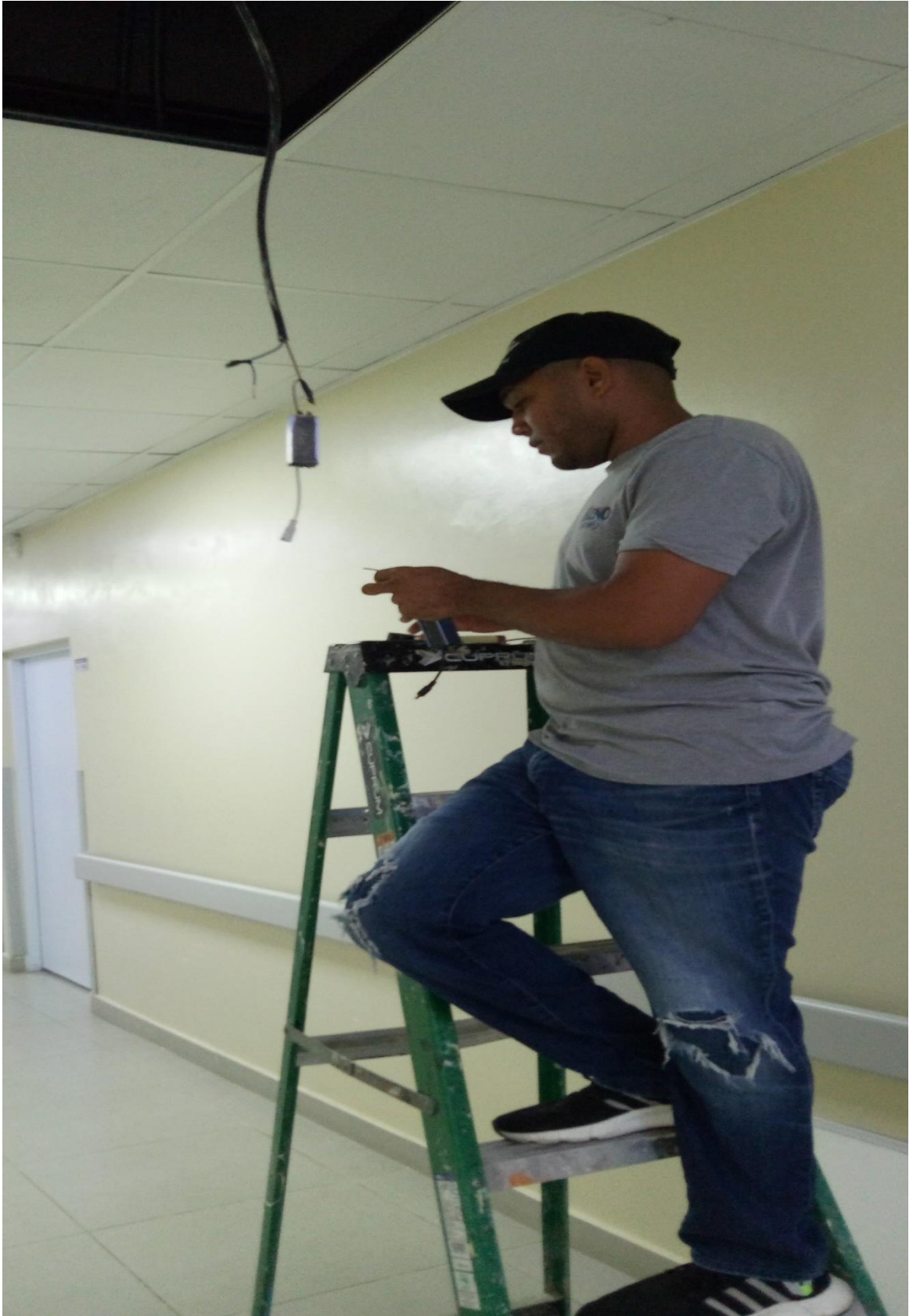
Cambio de lampara en pasillo 18/01/2024
