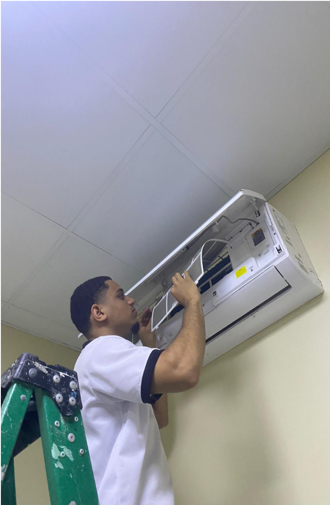
Mantenimiento aire acondicionado 26/01/2024
