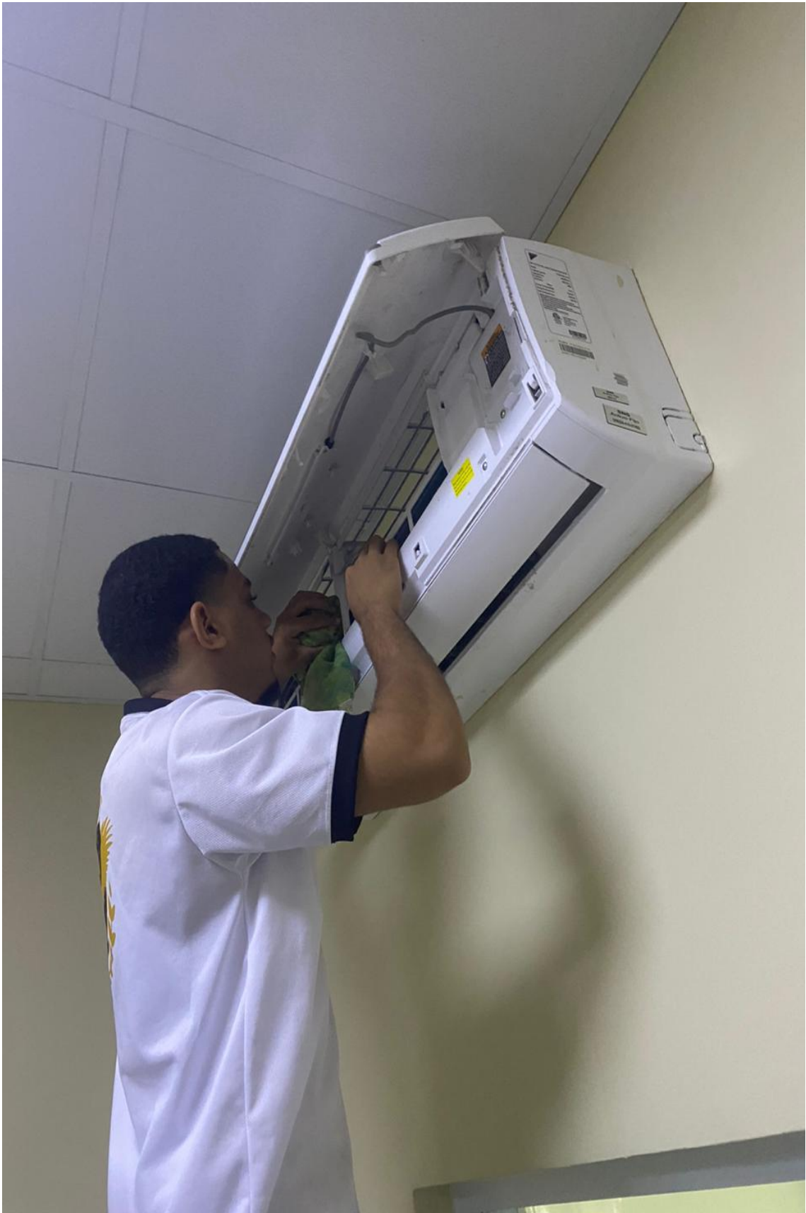
Mantenimiento aire acondicionado 26/01/2024
