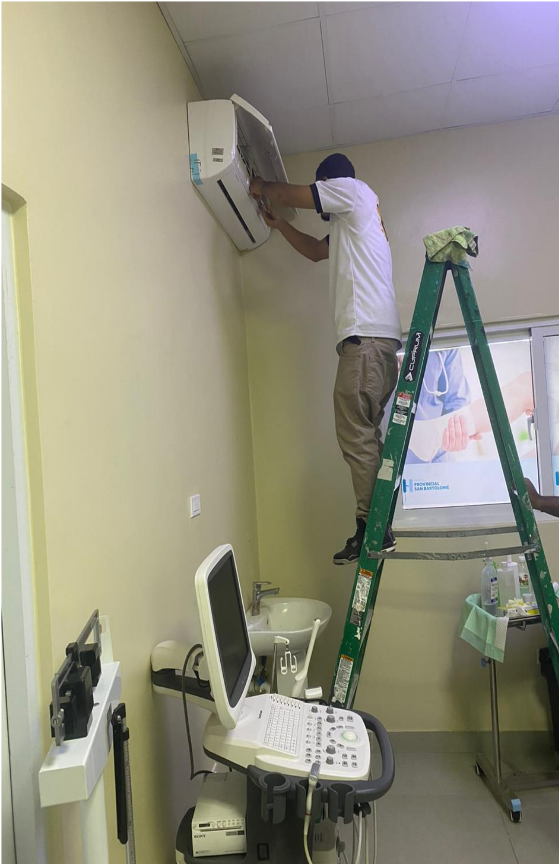
Mantenimiento aire acondicionado 26/01/2024
