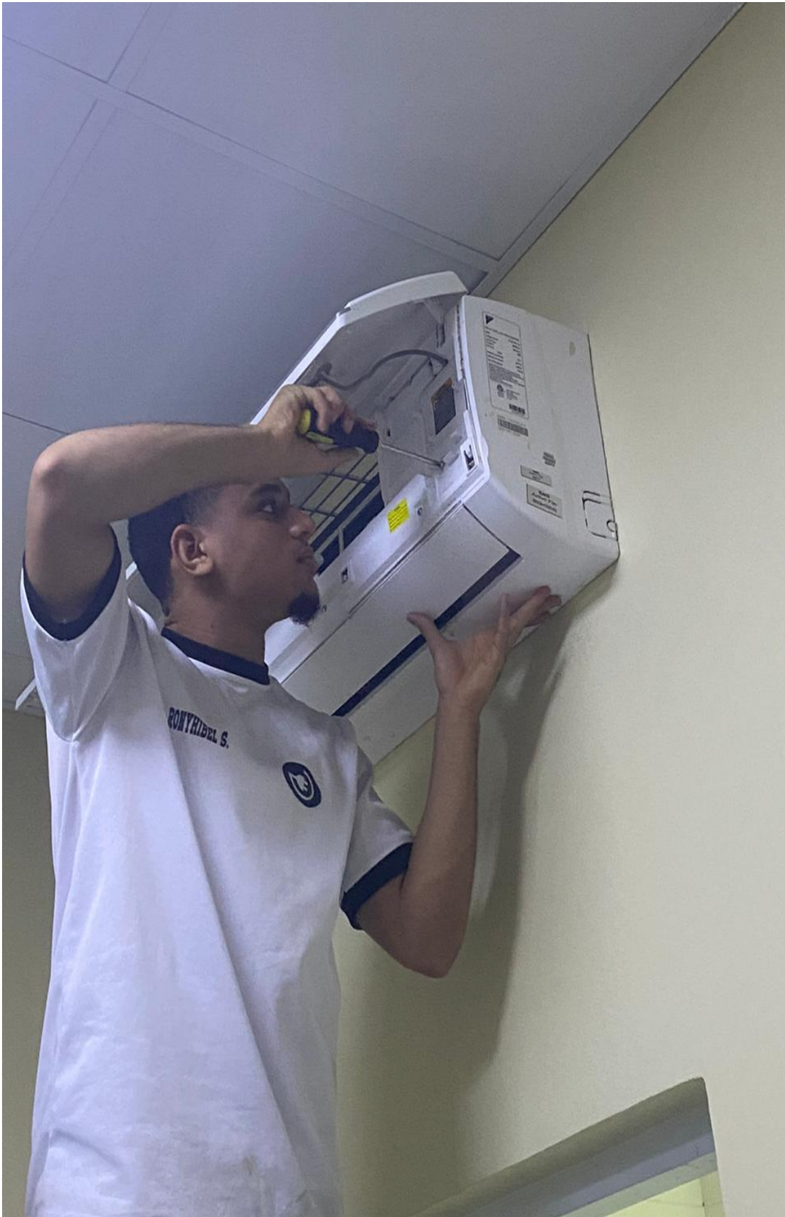
Mantenimiento aire acondicionado 26/01/2024
