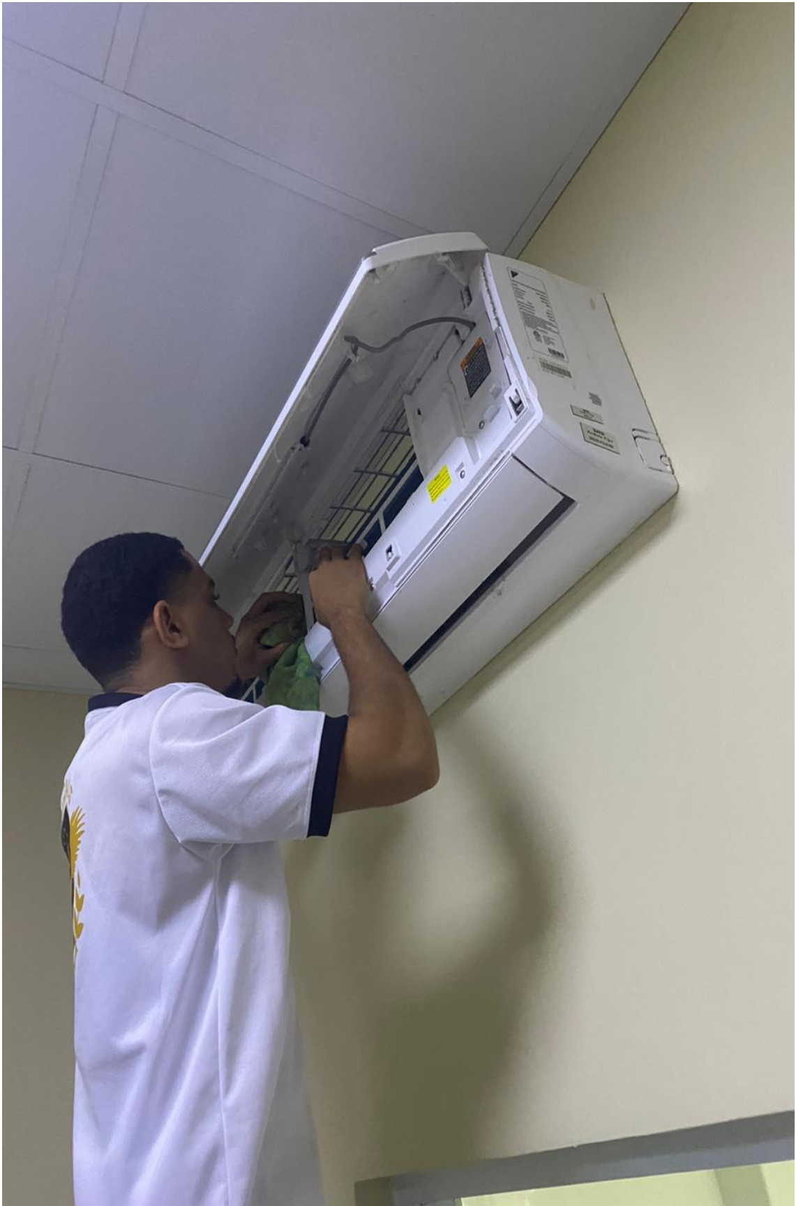
Mantenimiento aire acondicionado 26/01/2024
