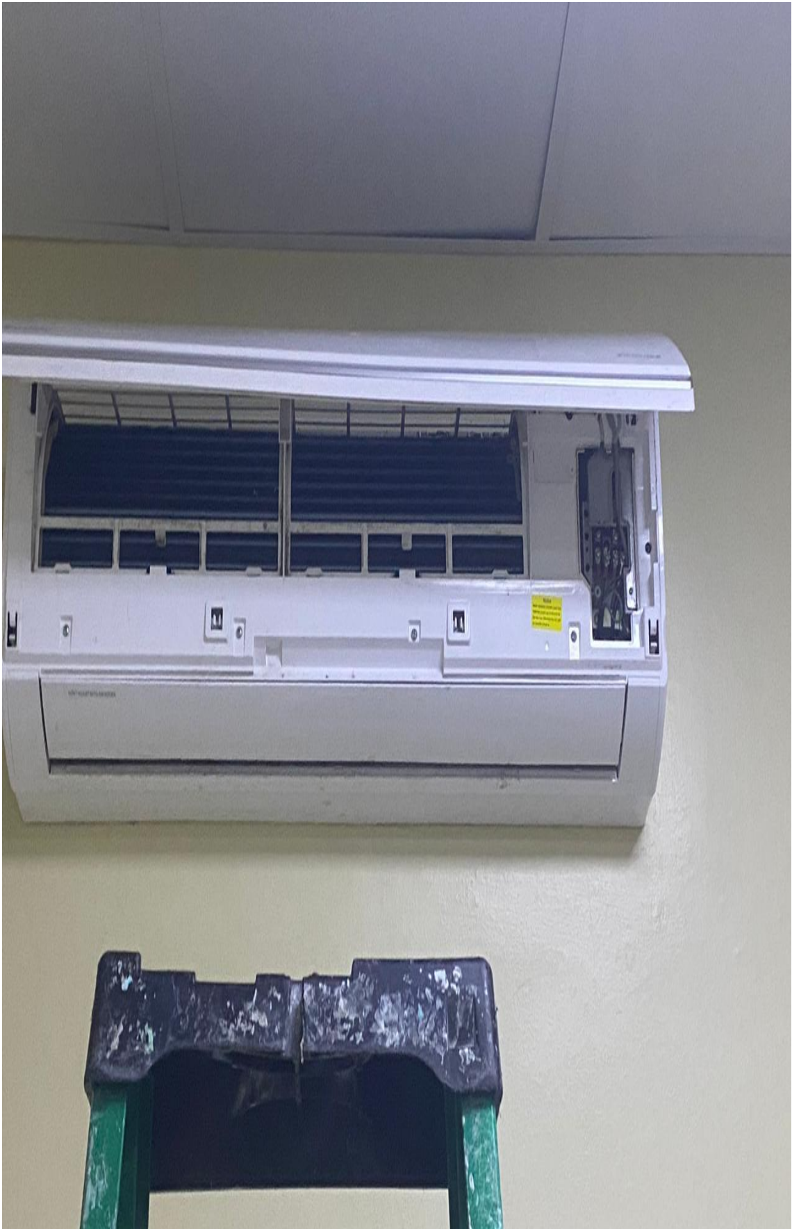
Mantenimiento aire acondicionado 26/01/2024
