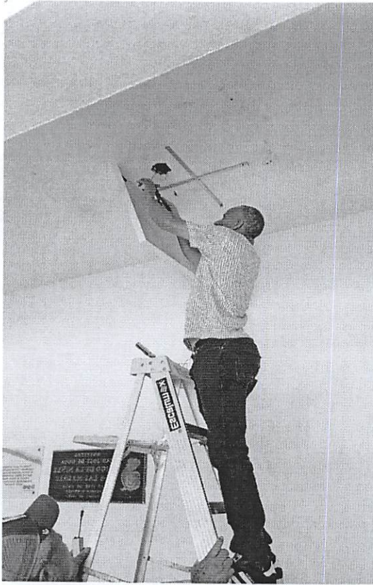
Instalación de los transformadores para la lámpara de techo del pasillo principal.
