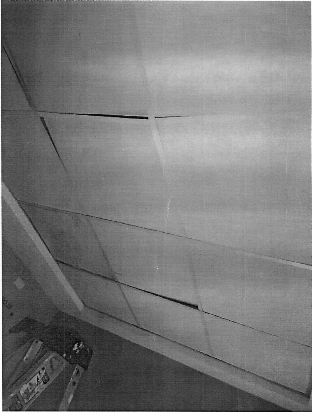
Reparación de plafón 3ra este
