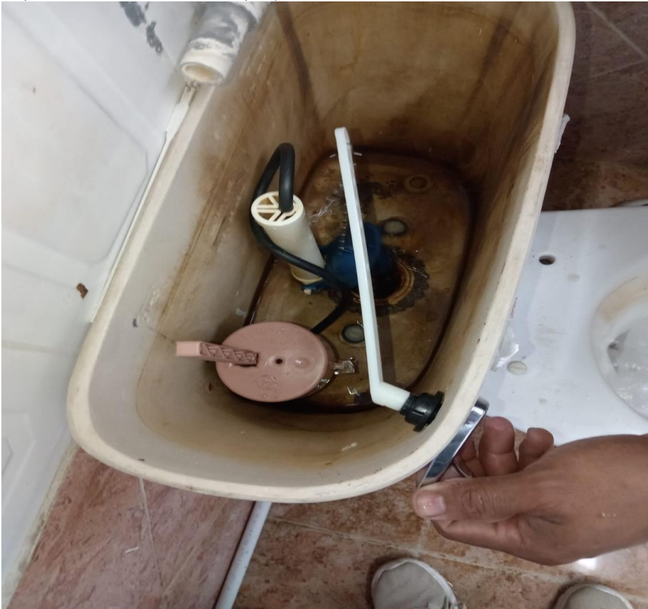
Reparación Inodoro Baño de psiquiatría, la flota dañada
