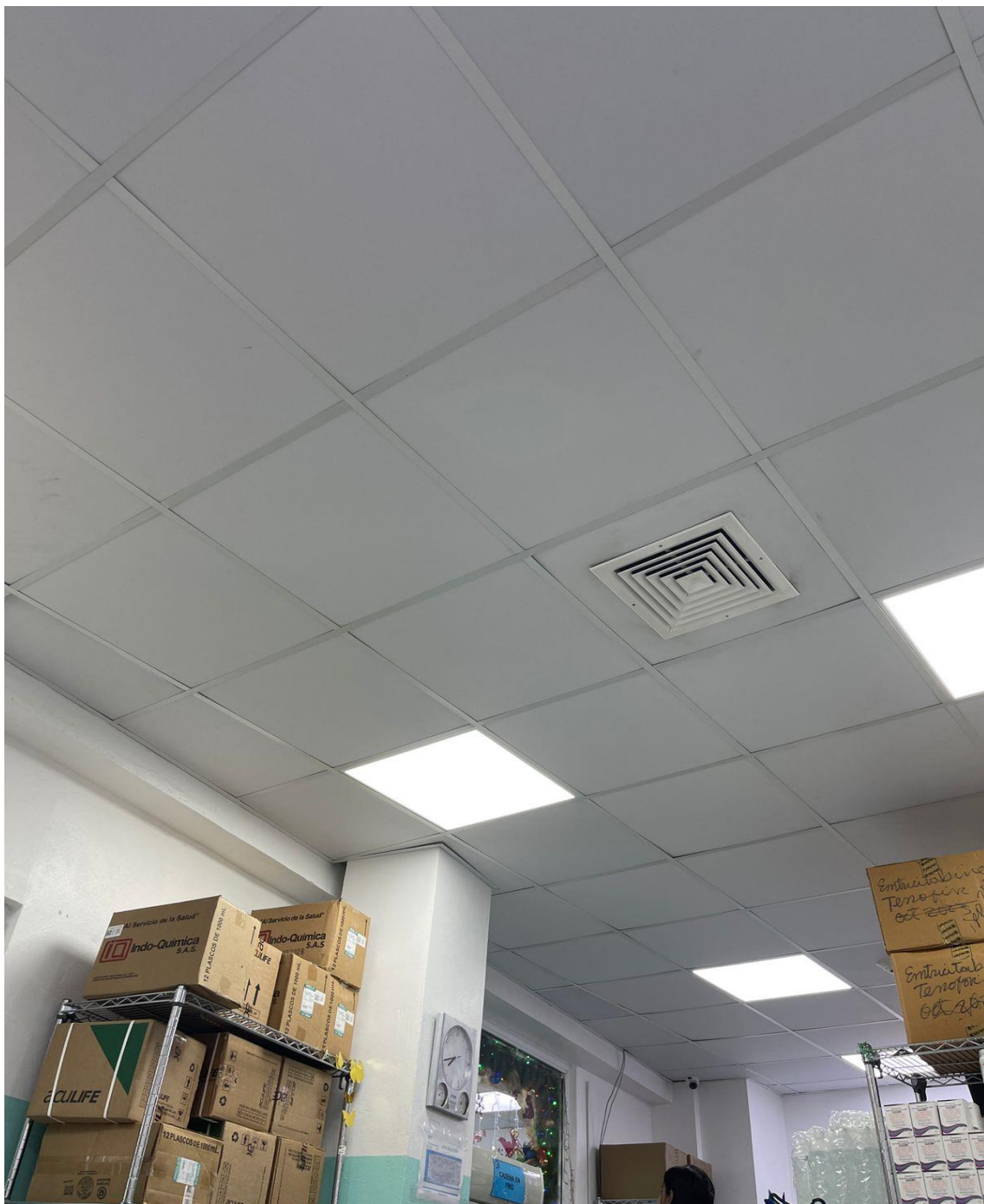
Imagen 25, techos sin filtraciones y buena iluminación.
