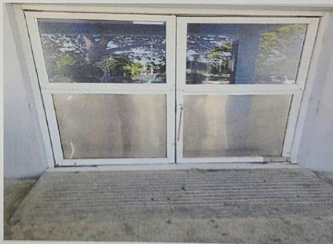
Entrada a emergencia
