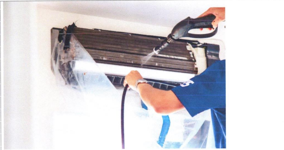
Aire acondicionado desmantelado
