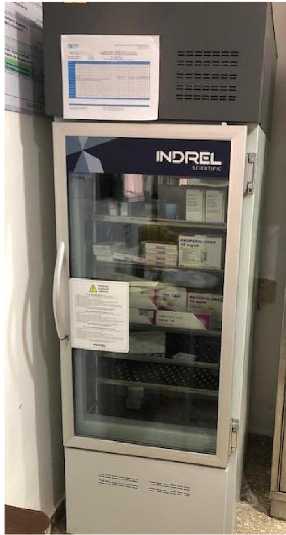
Ilustración 11 Nevera de medicamentos de cadena de frio ubicada en farmacia central con su registro de temperatura que es tomada diario a las 8:00 am y a las 1:00 pm
