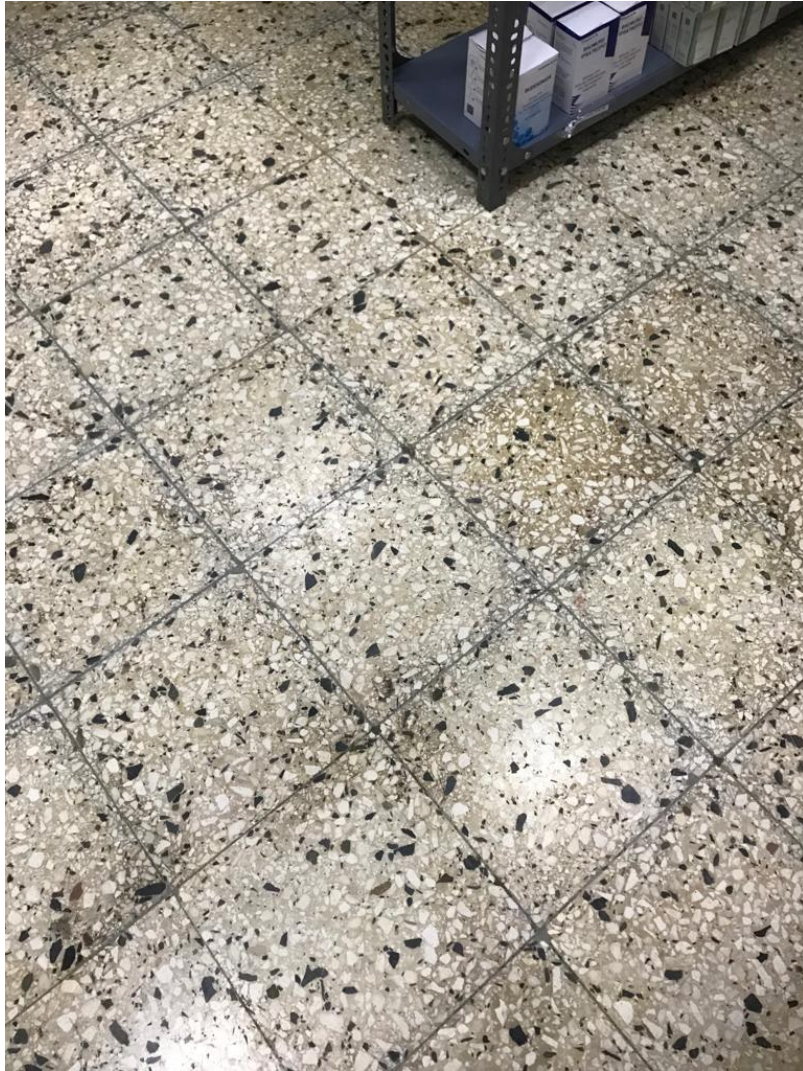
Techo, paredes y piso en almacén
