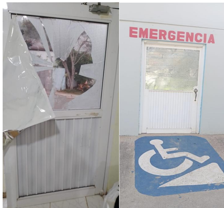
Reparación con tola de la puerta de emergencia
