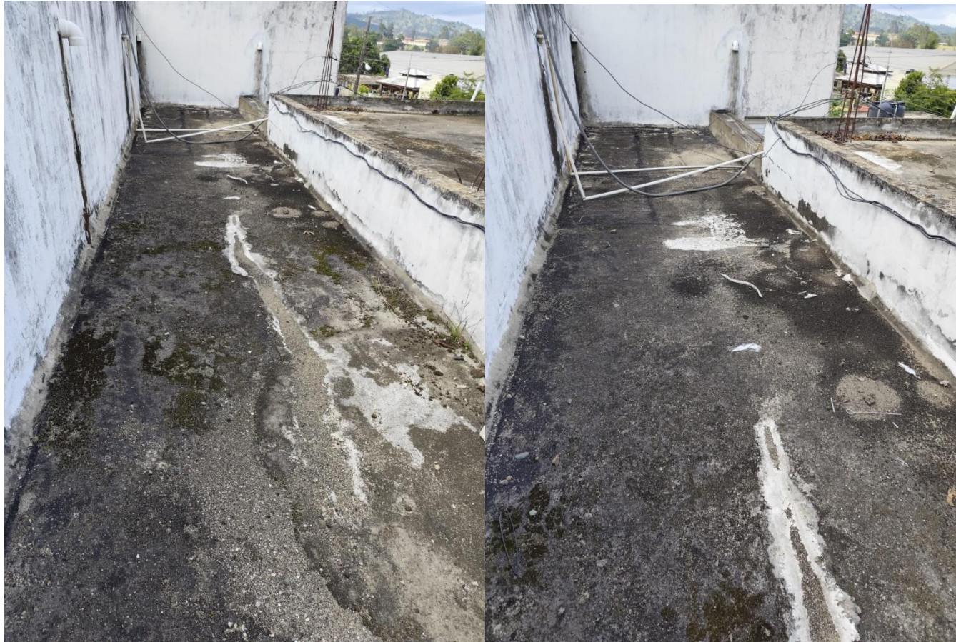
Colocación de pintura anti filtración en el techo del área de espera del laboratorio
