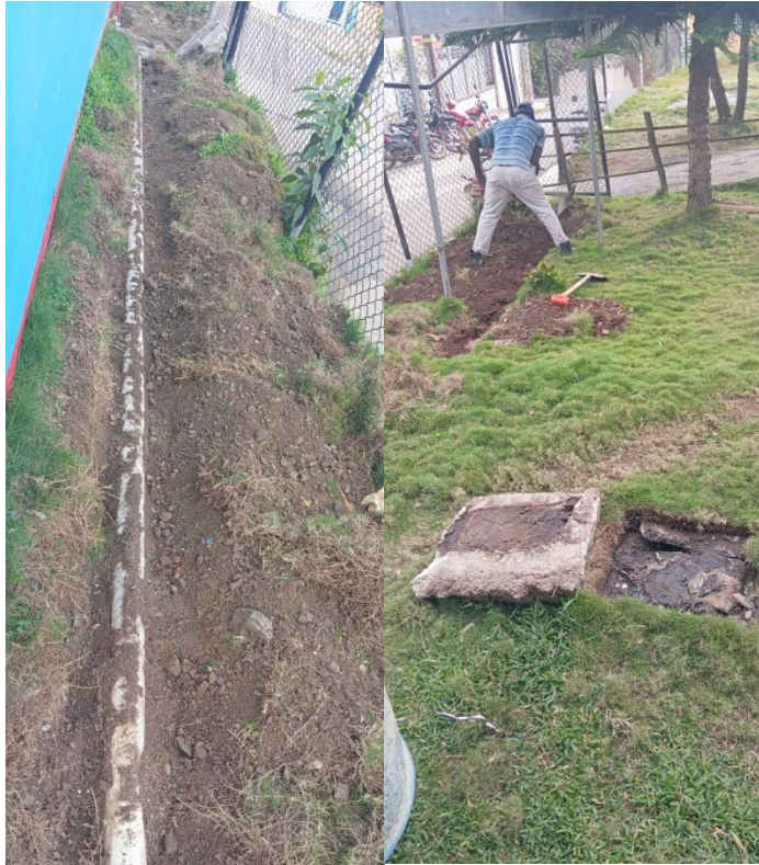
Limpieza de dos registros y la parte delantera del hospital registros y la parte delantera del hospital
