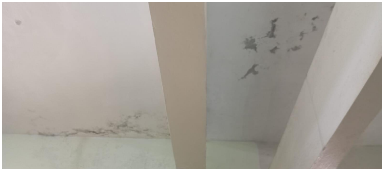
Pintura de área de hospitalización de pediatría
