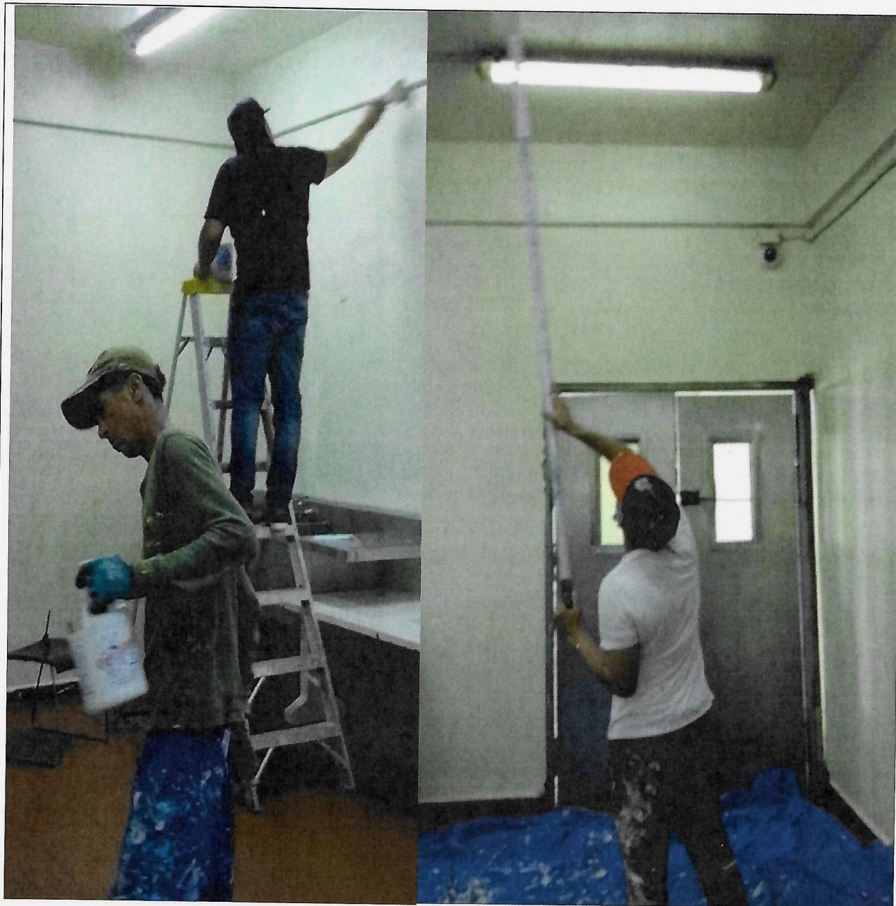
6- instalación de lona faltica
