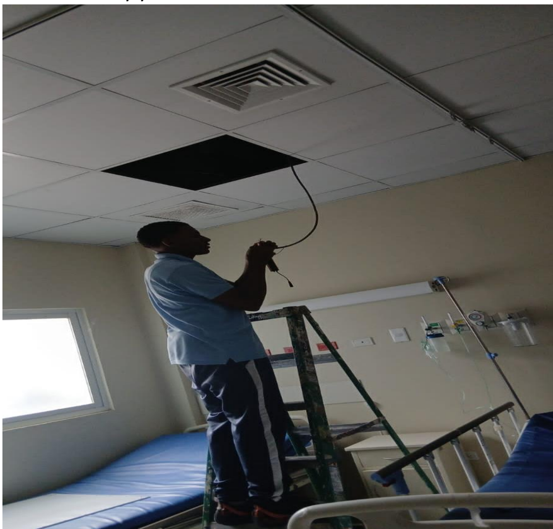
Mantenimiento Correctivo Cambio de Lampara LED Habitación 103 area de internamiento B 13/5/26
