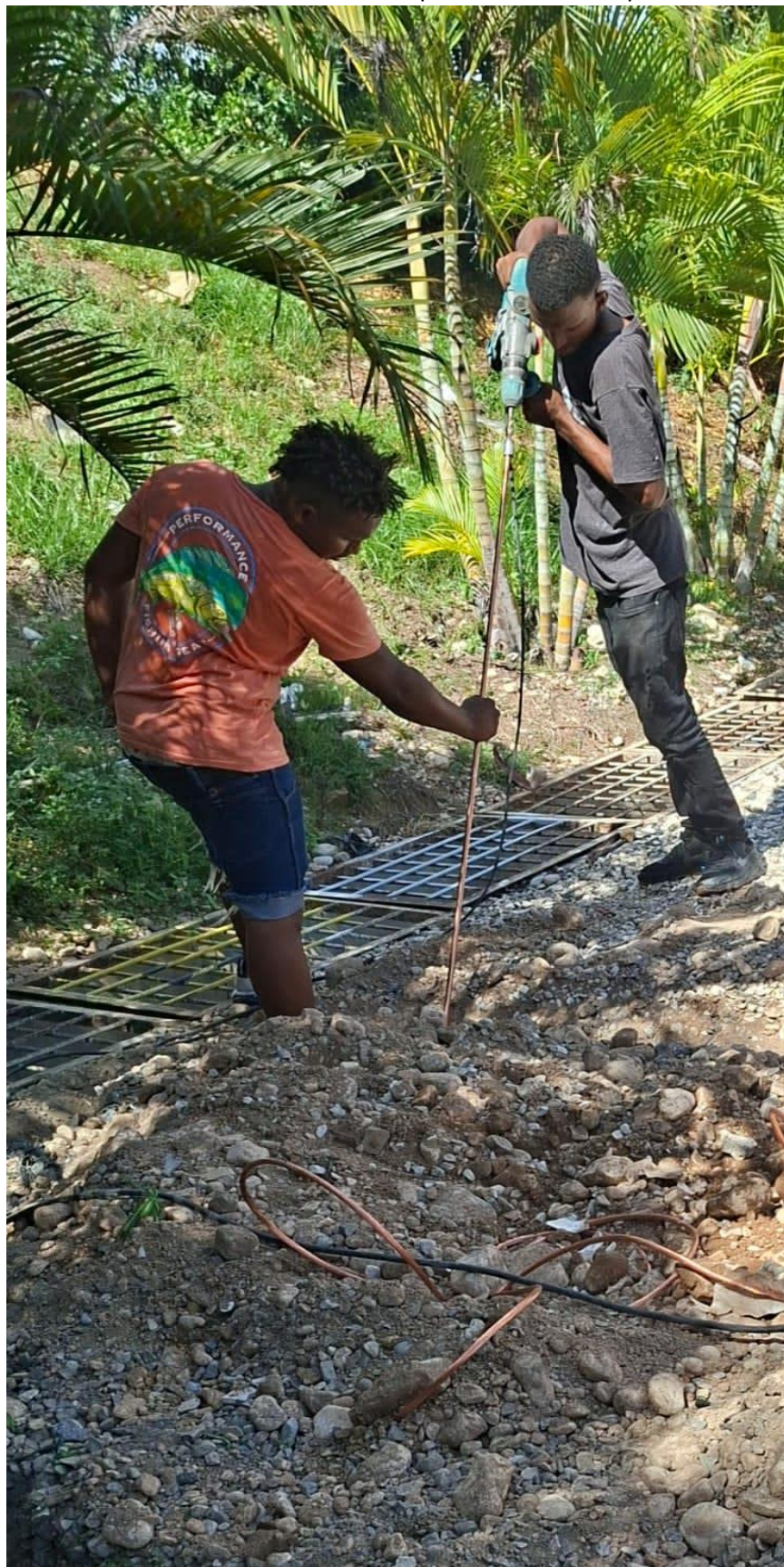
Mantenimiento correctivo Cambio de puesta a tierra a la planta eléctrica industrial 01/05/26
