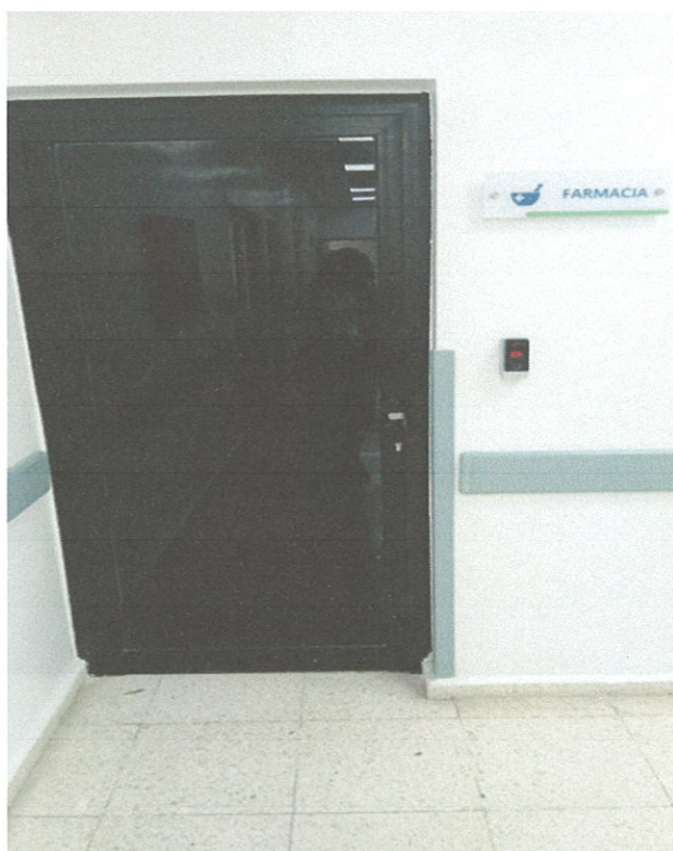
Puerta principal identificada
