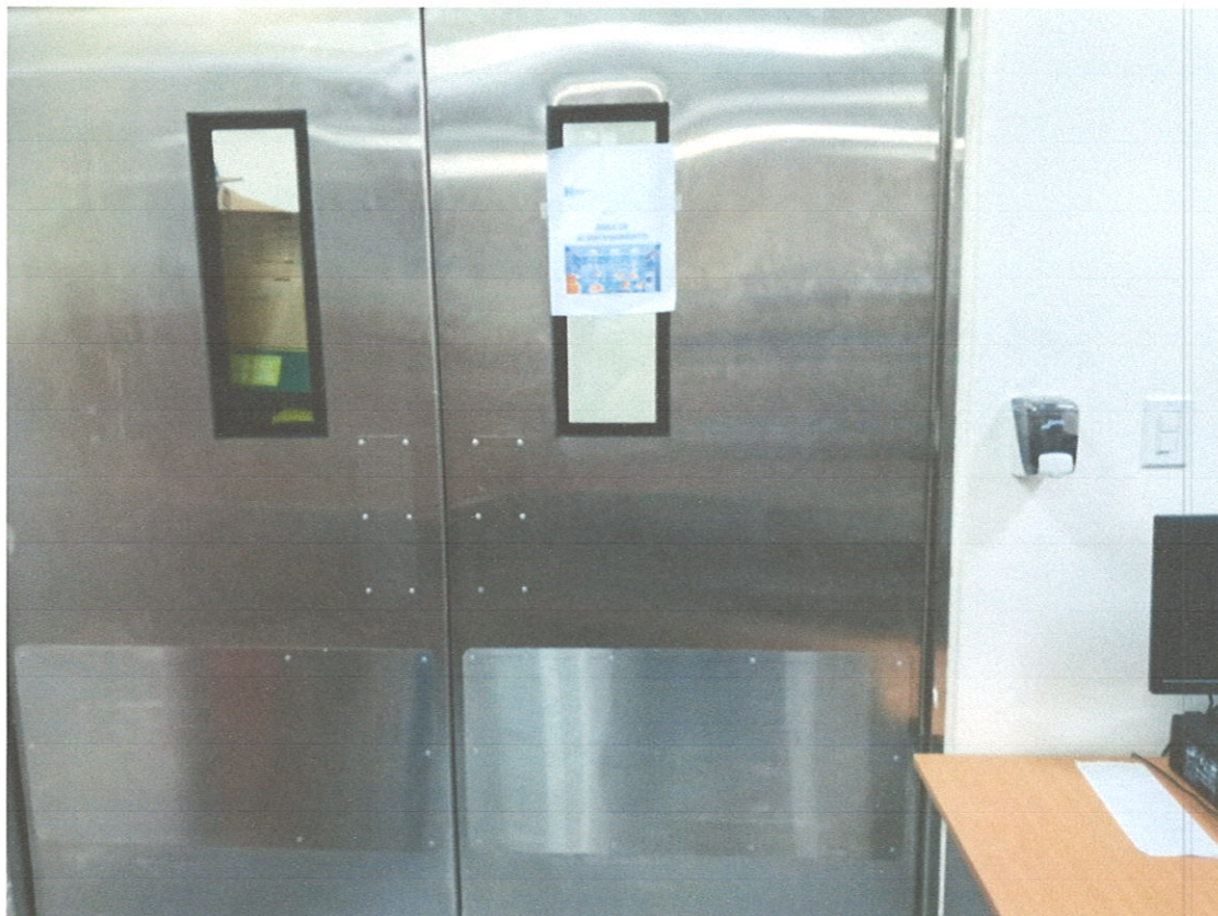
Puerta de entrada hacia el almacén
