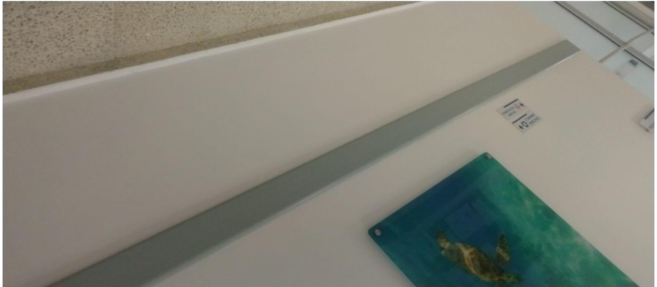
Aspecto de pintura de paredes internas
