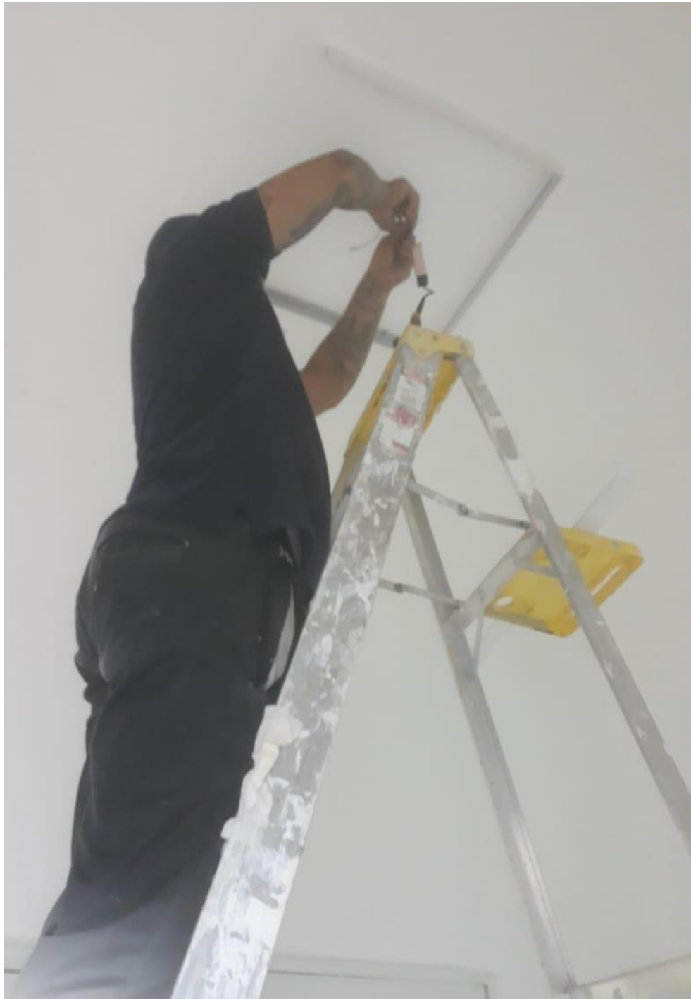
Cambio Iluminarias internas de cirugía
