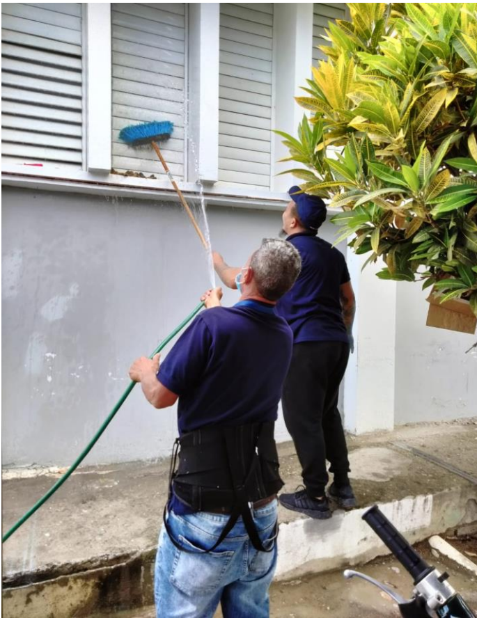
Lavado de Ventanas
