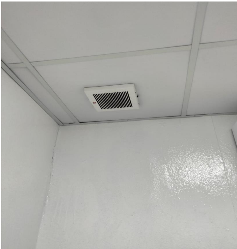
Mantenimiento Extractor de aire de emergencia
