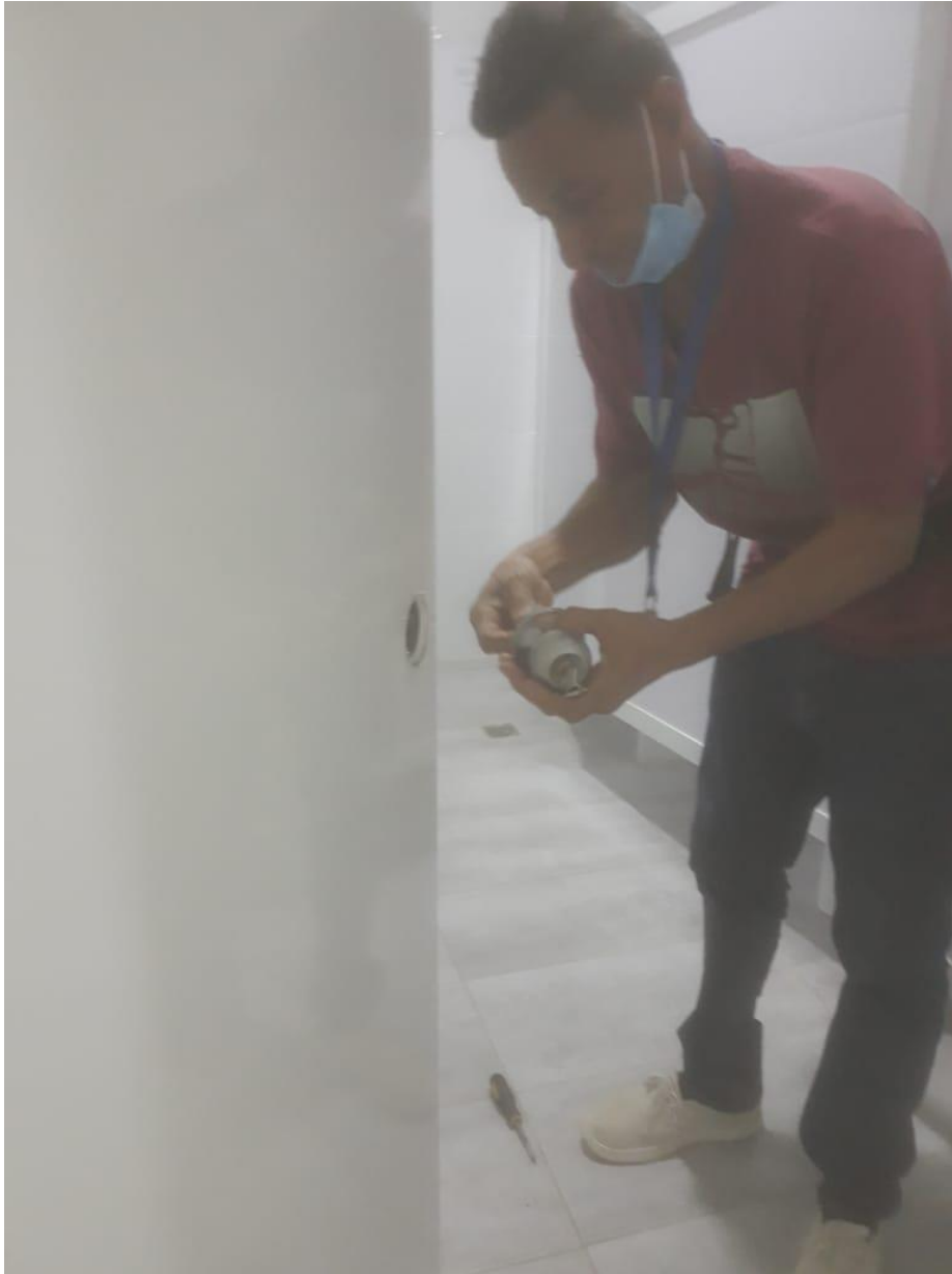
Cambio cerradura Puertas de baño área nueva
