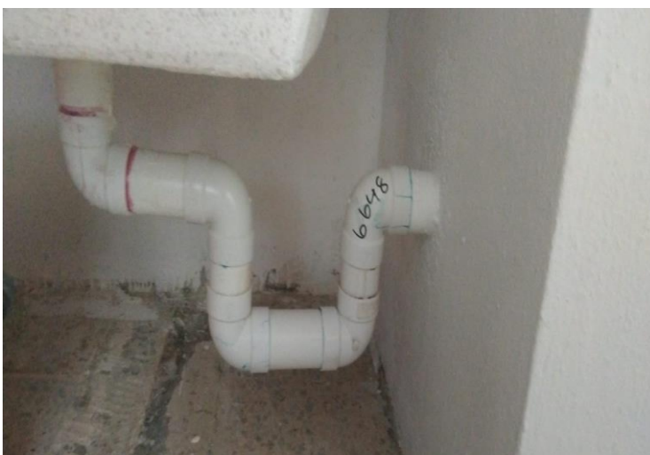
Tubería de drenaje
