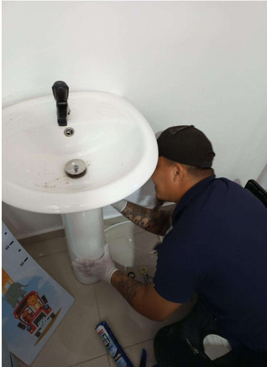
Reparación y mantenimiento del lavamanos del baño ubicado frente al departamento de archivo
