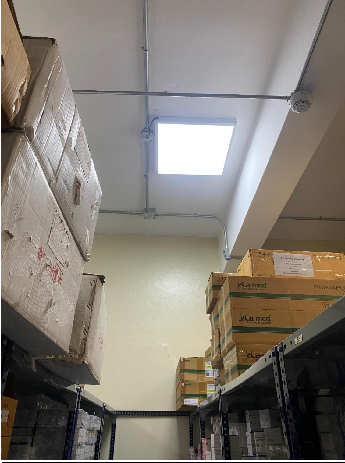
ILUMINACION Y TECHO ALMACEN DE MEDICAMENTOS
