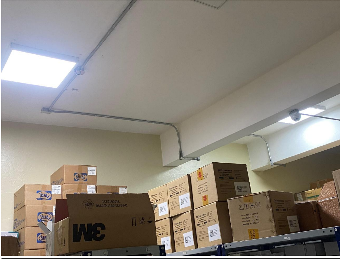
ILUMINACION Y TECHO ALMACEN DE MEDICAMENTOS
