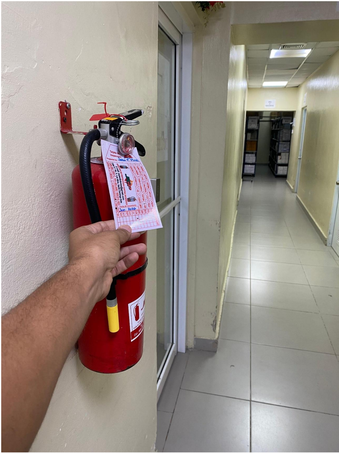
EXTINTOR DE ALMACEN DE MEDICAMENTOS EN FECHA VIGENTE JULIO 2026
