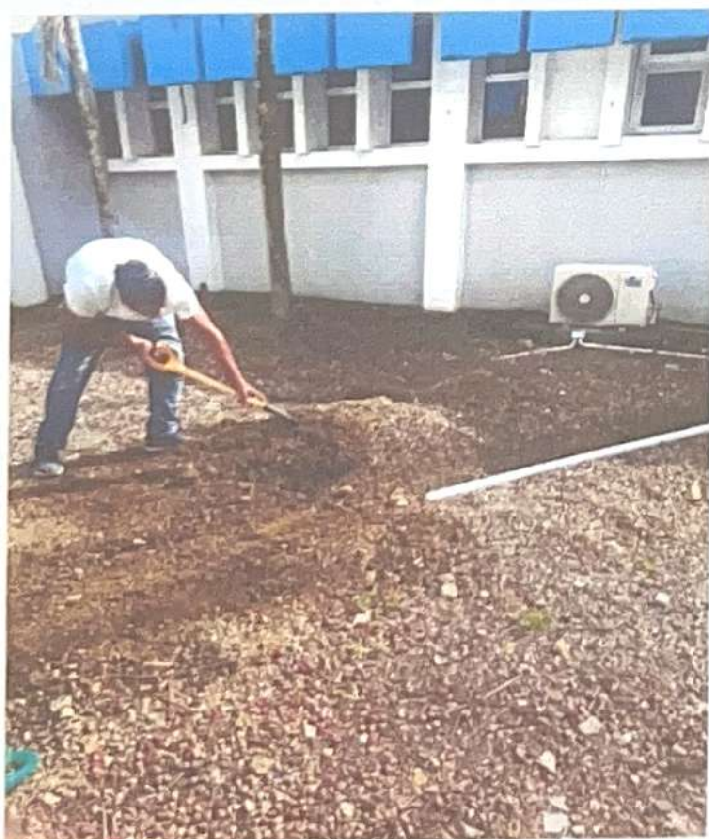
Tubería de drenaje:
