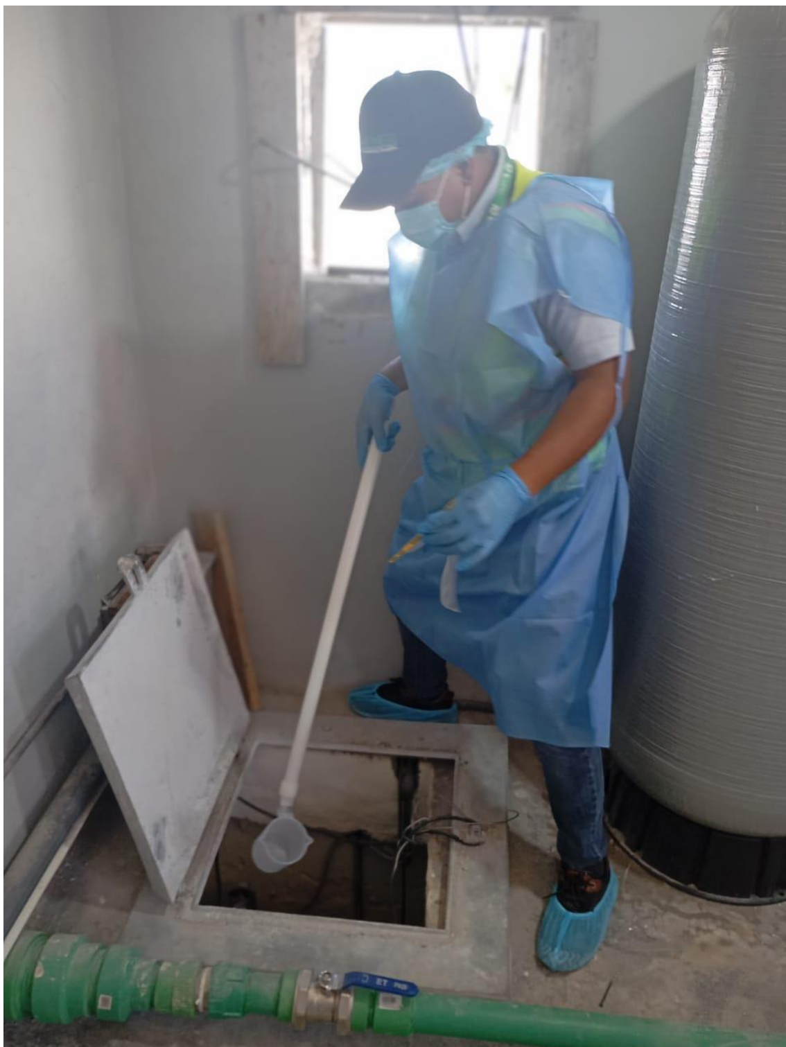
Mantenimiento Correctivo prueba de agua en la cisterna 23/03/2026
