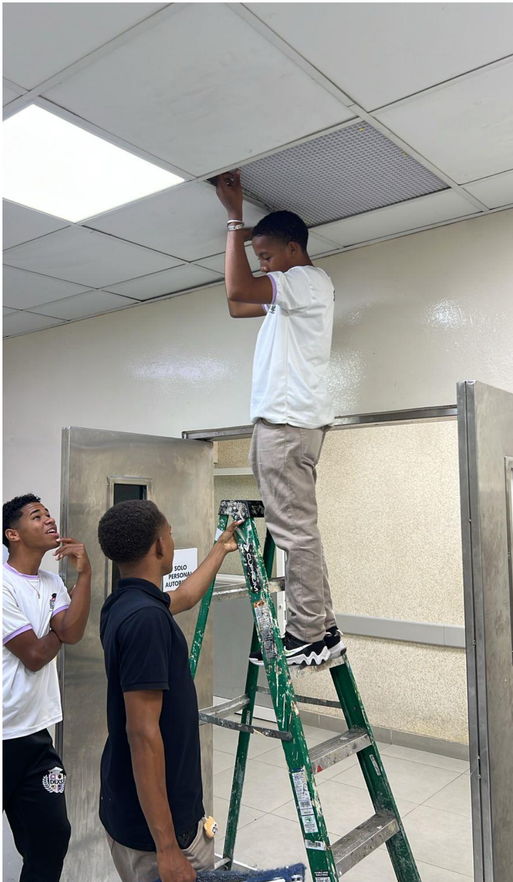
Mantenimiento Correctivo cambio de Lampara LED en la sala de Observacion 23/03/26
