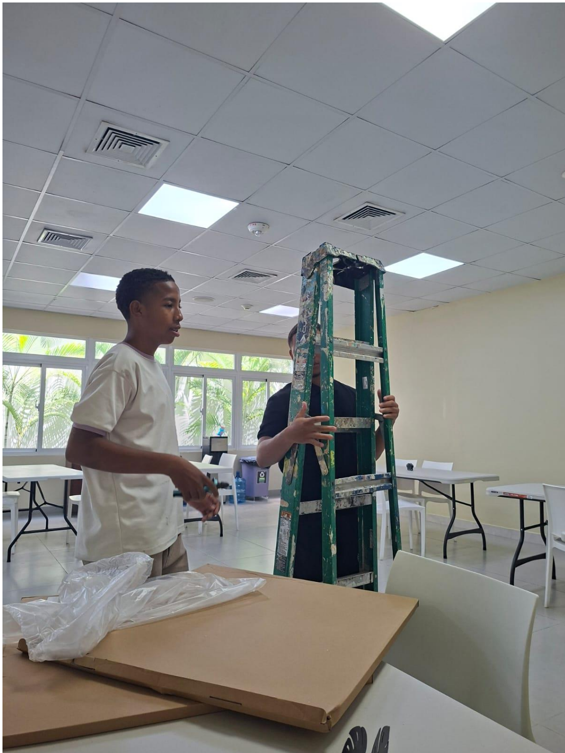
Mantenimiento Correctivo cambio de Lampara LED en el Comedor 23/03/26
