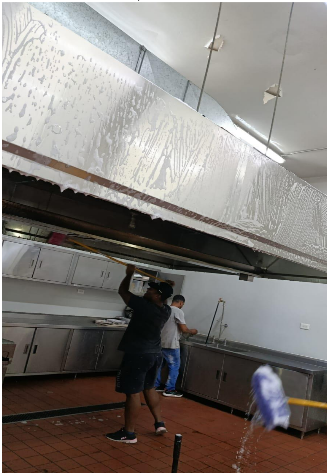
Mantenimiento correctivo limpieza de extractor 23/1/2026
