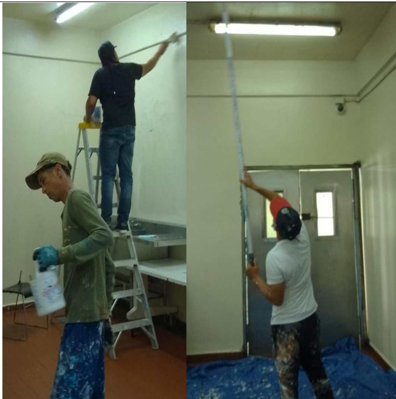
6- instalación de lona faltica
