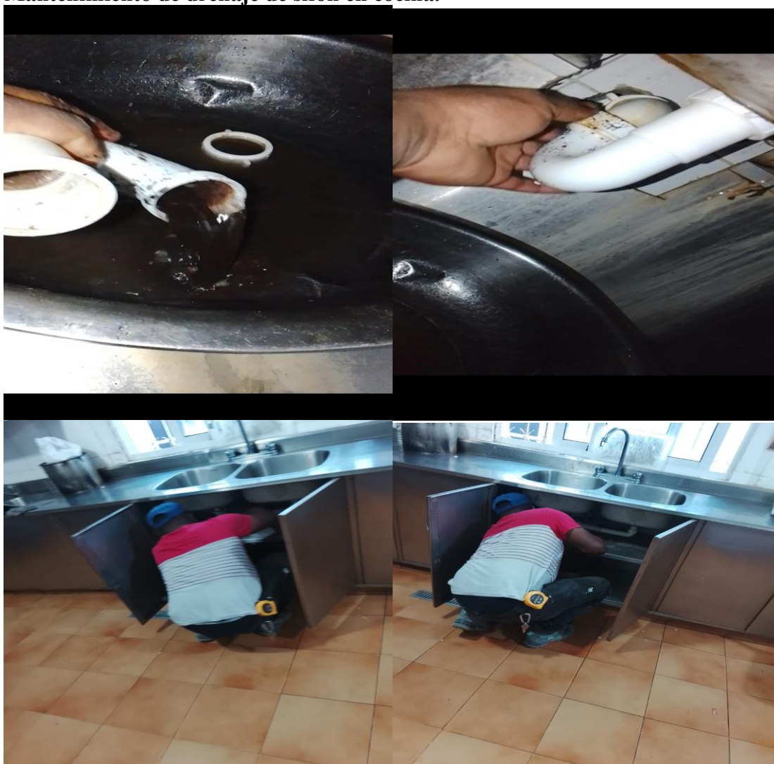
Mantenimiento de drenaje de sifón en cocina.
