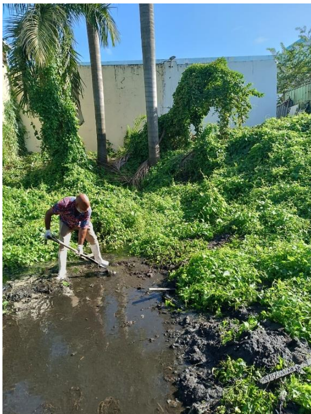
Limpieza de plantas de tratamiento
