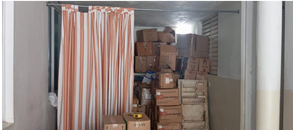
Fabricación de división y puerta del almacén de farmacia.
