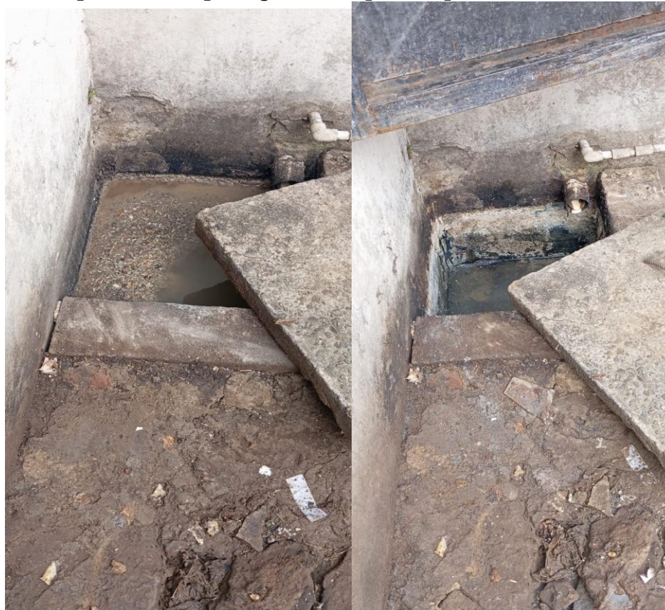
Limpieza de trampa de grasa en el patio de parte atrás de cocina
