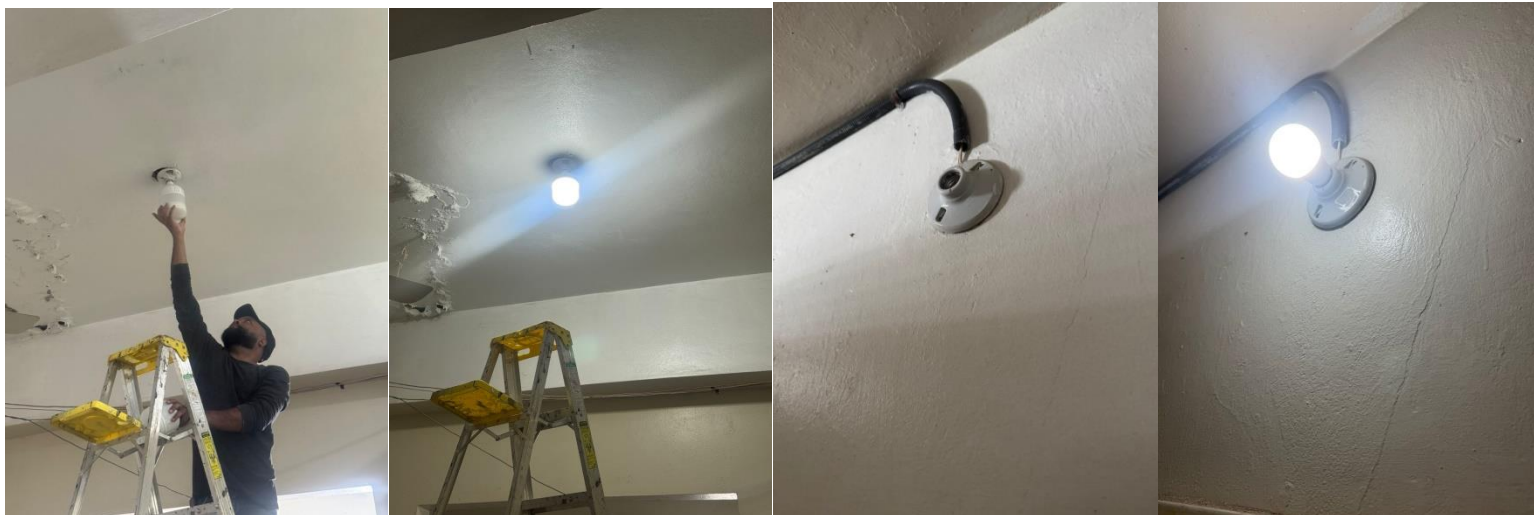
Sustitución de bombillos dañados.
