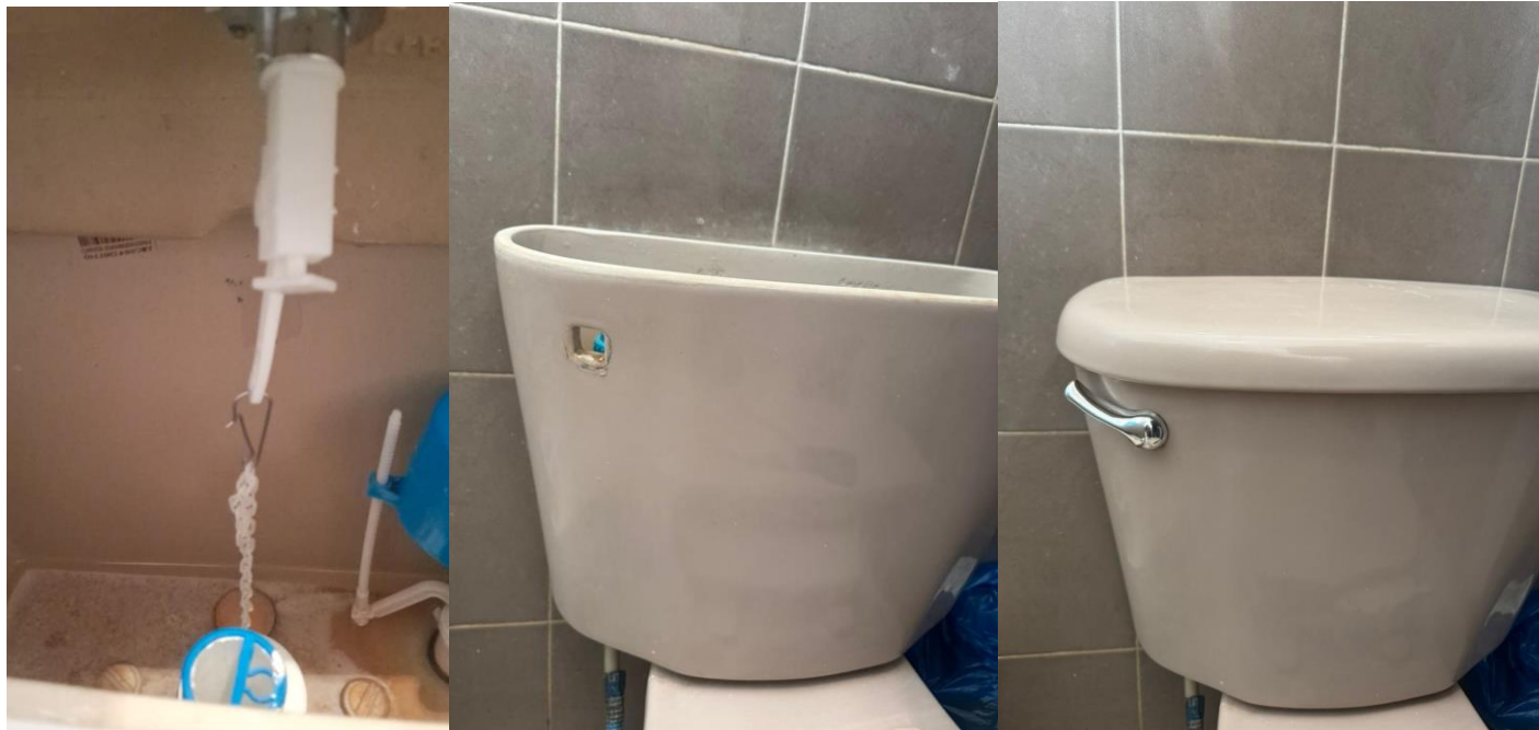
Colocación de palanca de inodoro
