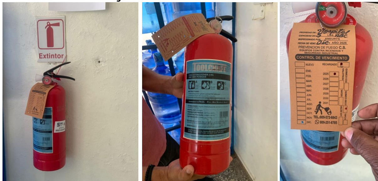
Recarga de los extintores de Laboratorio, Sala de espera de Consulta, Farmacia, Pasillo frente a Recursos Humanos
