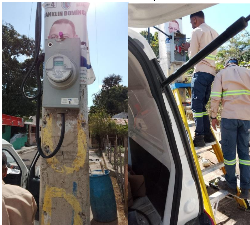
Cambio de contador obsoleto por un moderno.
