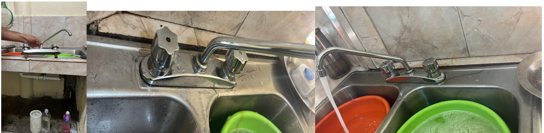
Sustitución de llave del lavamanos de cocina
