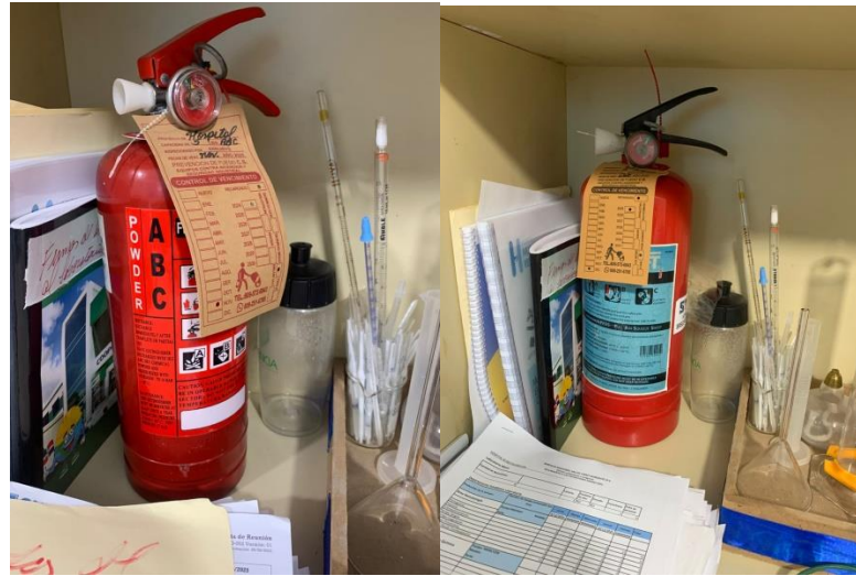
Recarga de los extintores de Sala de espera de Consulta
