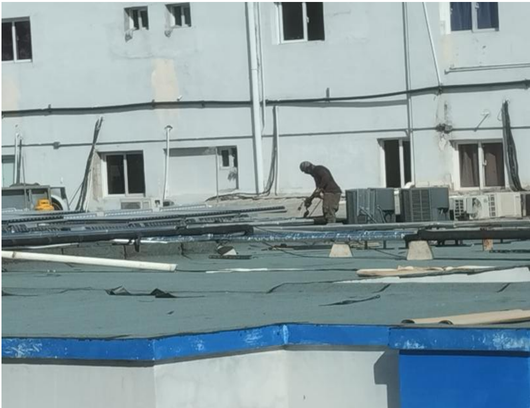
Mantenimiento en techo paneles de filtro para techo
