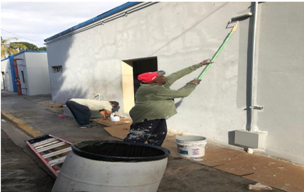
Mantenimiento de Pintura en paredes
