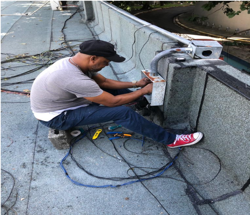
Limpieza de aires
