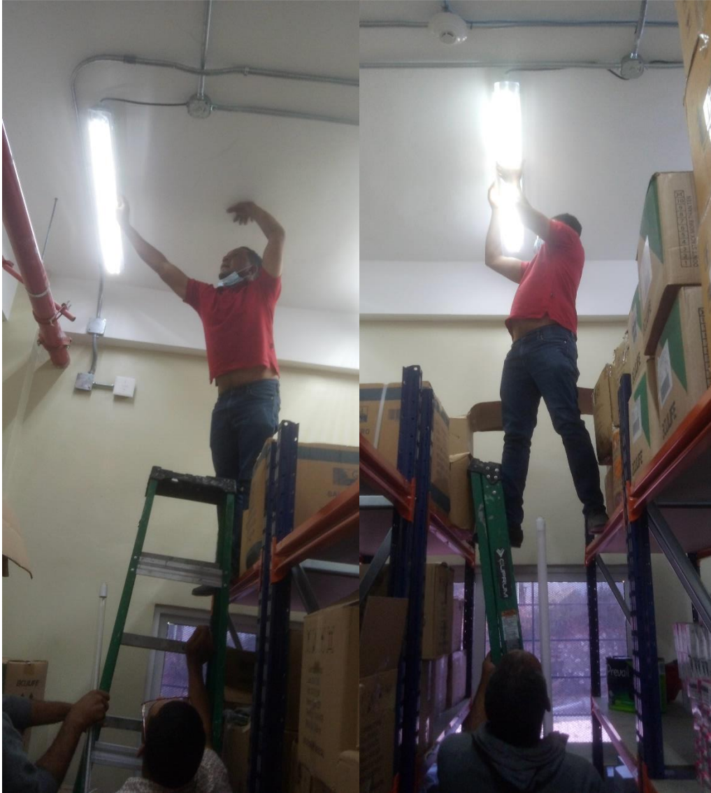
Mantenimiento Correctivo Cambio de tubo led Farmacia 24/04/2025.
