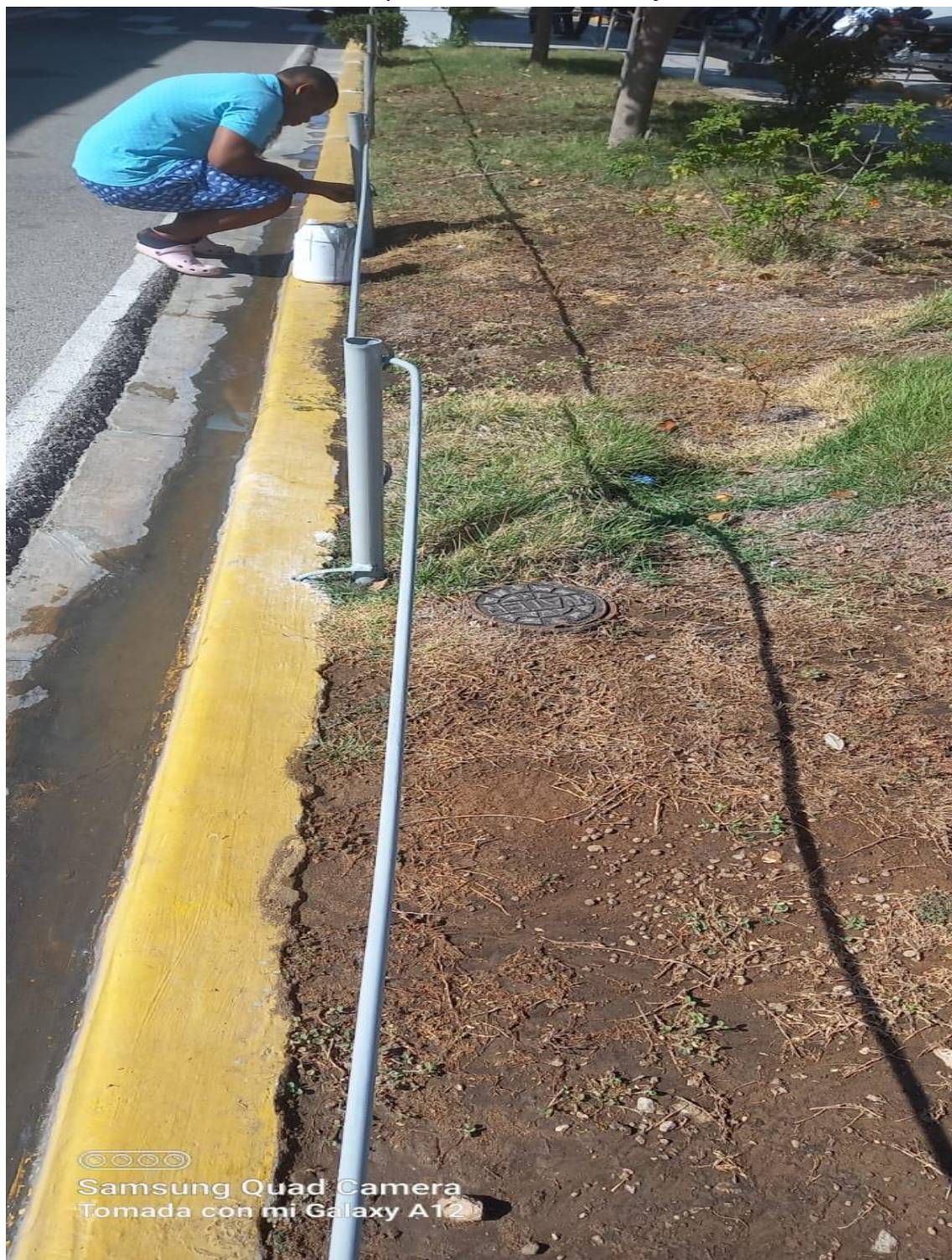
Mantenimiento Correctivo Reparación del tubo de jardinería 03/06/2025.
