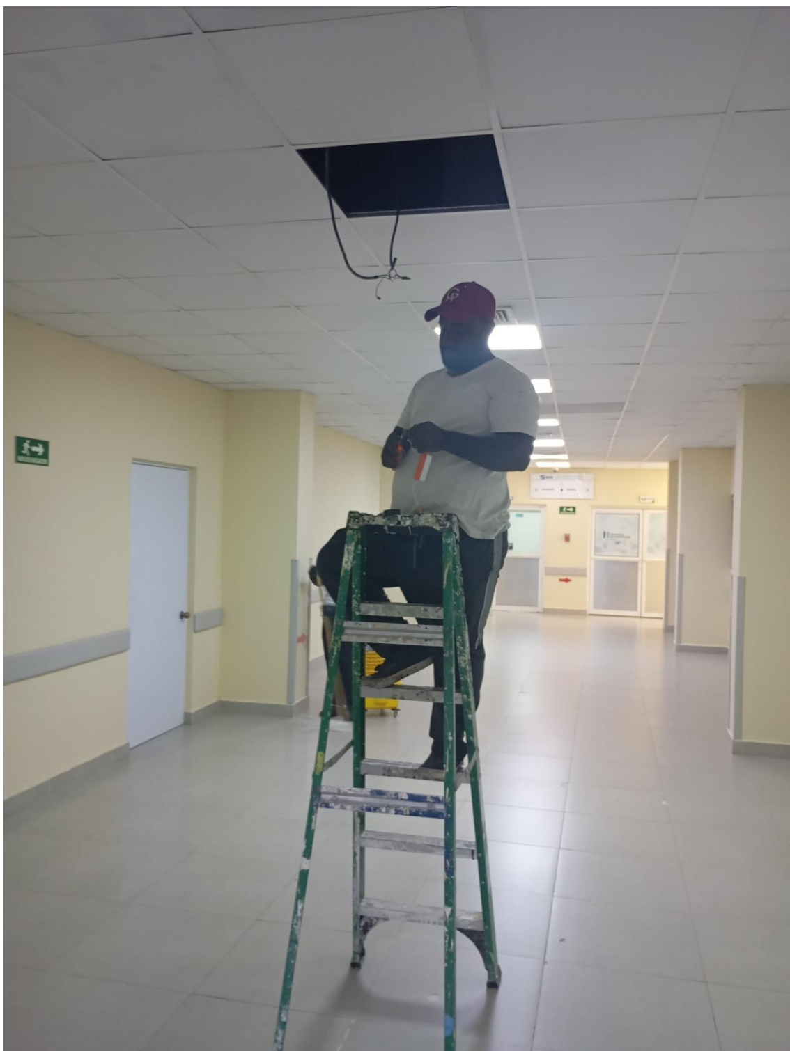
Mantenimiento Correctivo de lámpara 2x2 en el pasillo de Cirugía y Parto 21/04/2025.
