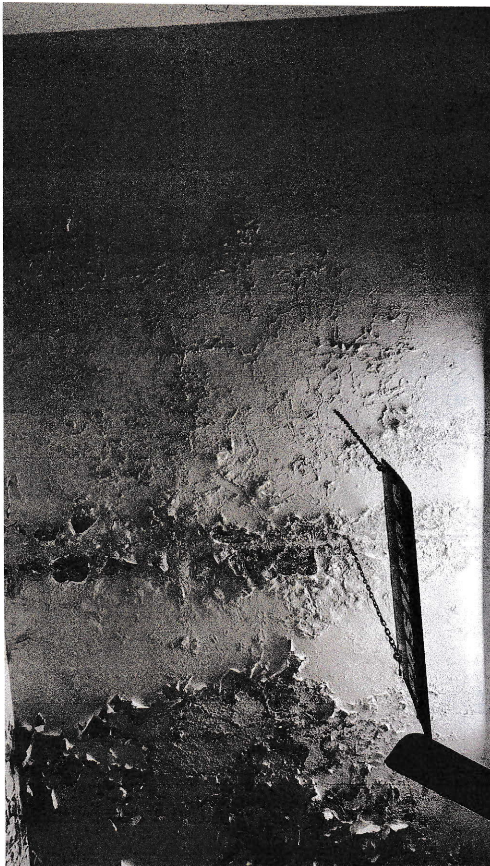
Techo de Almacén
