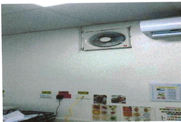
instalación de ventilador en área de laboratorio.
