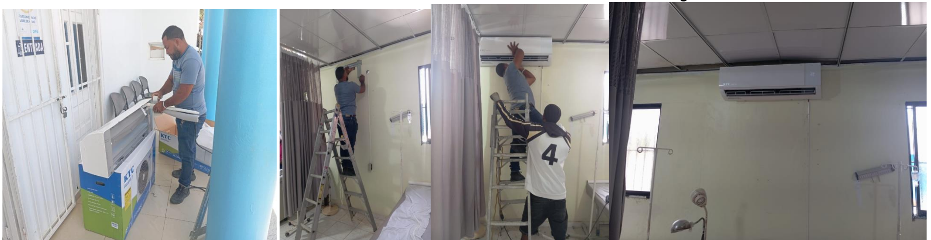
Instalacion de nuevo Aire Acondicionado en la Subdivision de Emergencia
