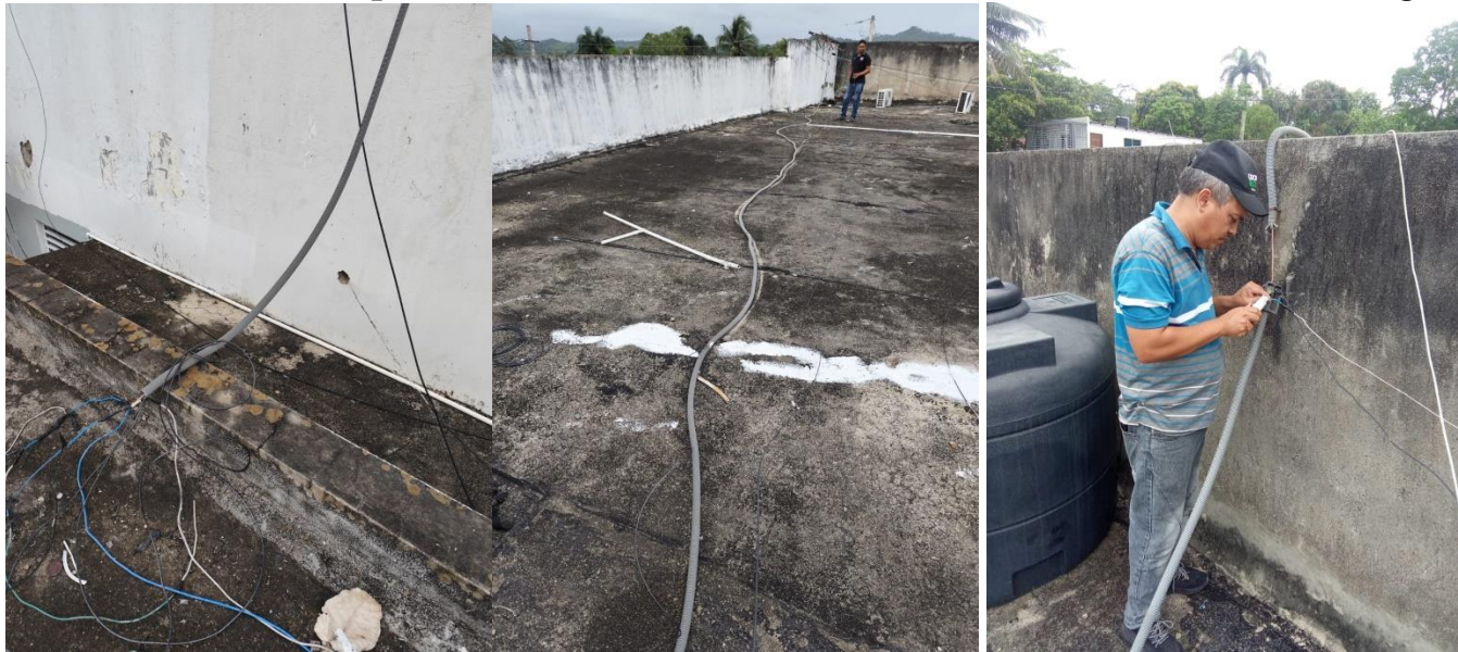
Instalacion de otra linea para colocacion de Aire Acondicionado en la Subdivision de Emergencia
