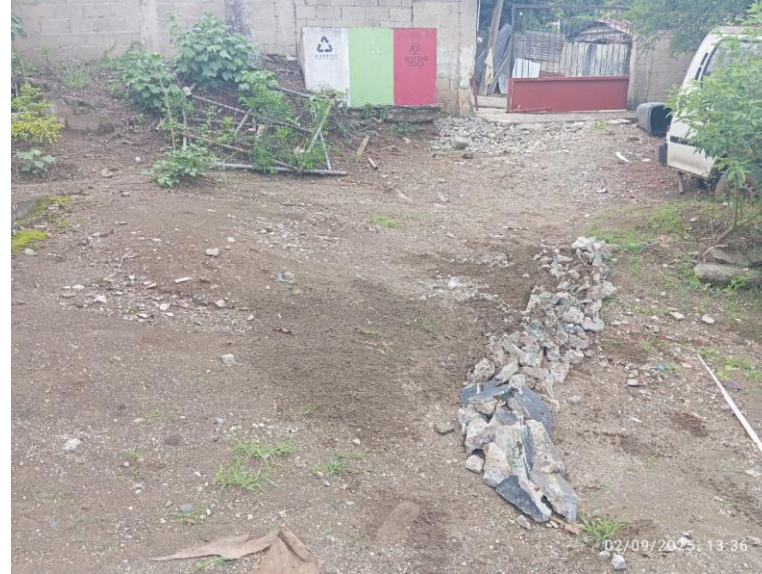
Colocacion de relleno para retener la tierra durante la lluvia
