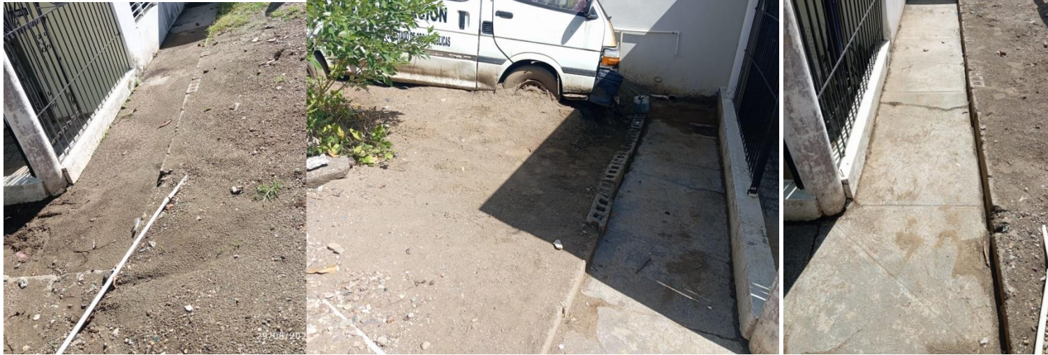
Eliminacion de tierra acumulada a causa de la lluvia
