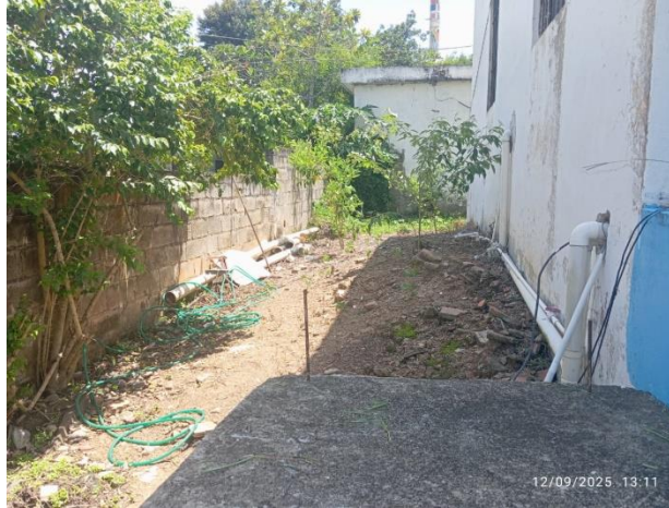
Limpieza de Parte lateral izquierdo Hospital
