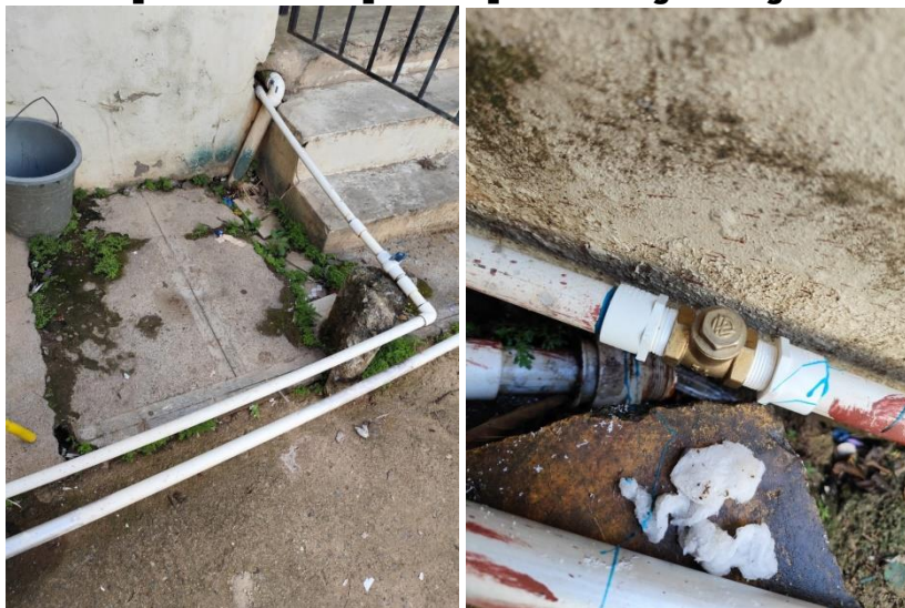
Colocacion de cheque horizontal para impedir la fuga de agua hacia el exterior
