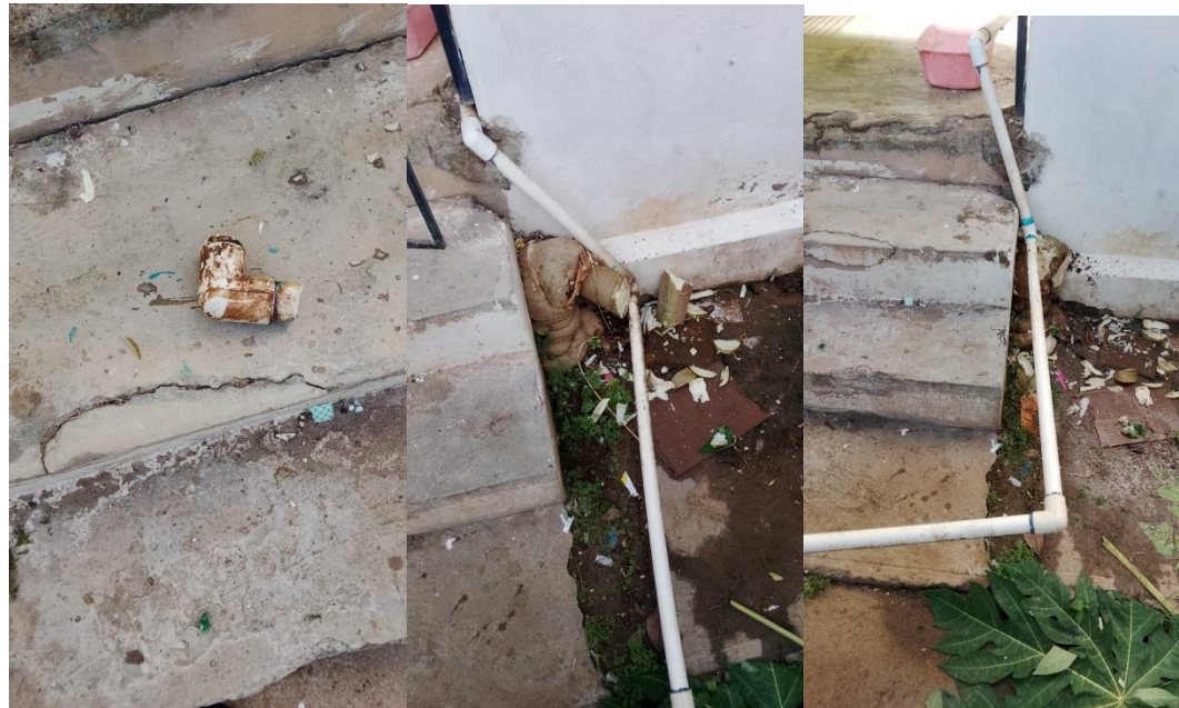
Coreccion de tuberia Avariada en el Patio del area de la Boma
