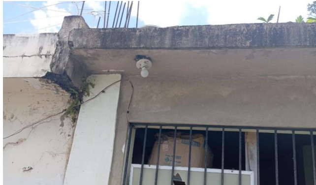
Cambio de Bombillo Frente a Lavanderia
