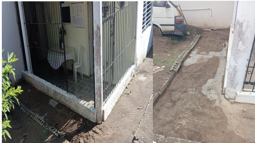
Eliminacion de tierra acumulada a causa de la lluvia
