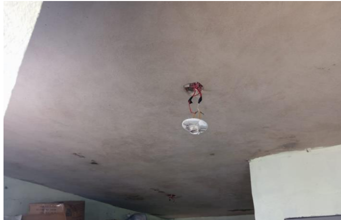
Colocacion de Bombillo en el techo de Lavanderia
