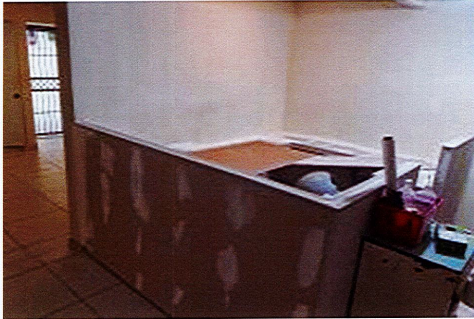
Area de Emergencia en Remoción
