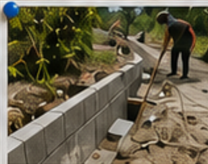
Construcción de contenes
