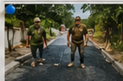
Bacheo y reparación de calles
