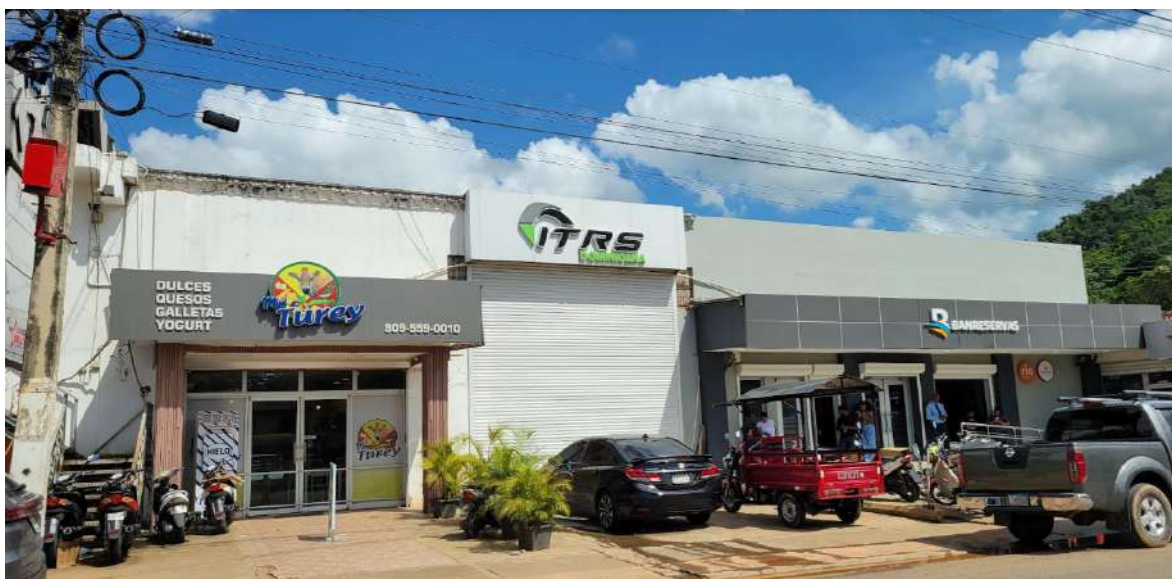
Banreservas Maimón en la Carretera Maimón-Cotuí en la Plaza Turey.
