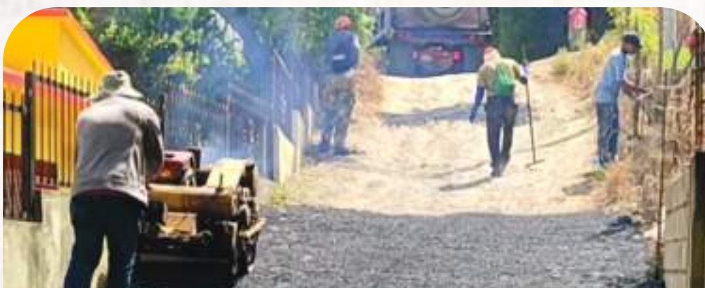
El alcalde Pedro Estrella inició el asfaltado del Kilombo y anunció la construcción de badenes para el desagüe. Los trabajos continuarán hasta completar toda la comunidad. Agradeció al Ministerio de Obras Públicas por su apoyo.
