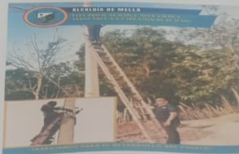
Electrificación de la calle Oliva Mancebo (Circunvalación)
