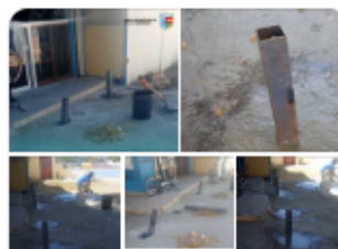
Iniciamos la colocación de barandillas en el... 1 de mayo
