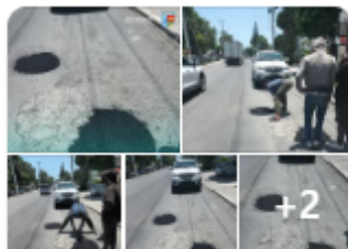
Inician trabajos de bacheo en la calle... 23 de mayo a las 7:30 a. m.
