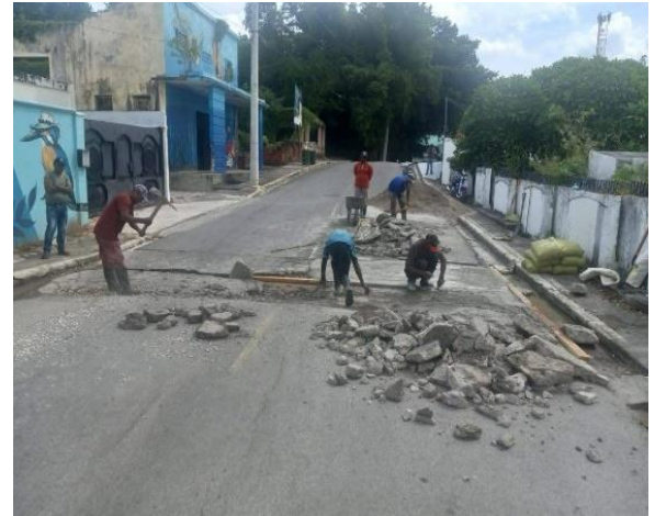
Badén Calle Sánchez
