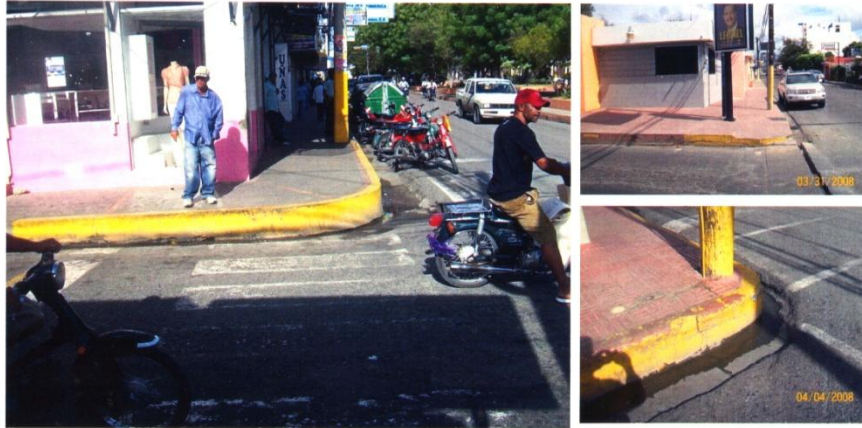
Aceras elevadas que impiden el paso a los discapacitados.
