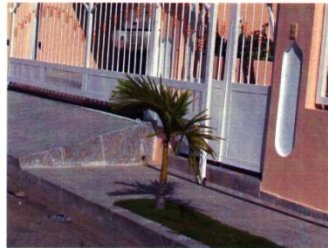
Colocación de materiales resbaladizos en las aceras y rampas inadecuadas.
