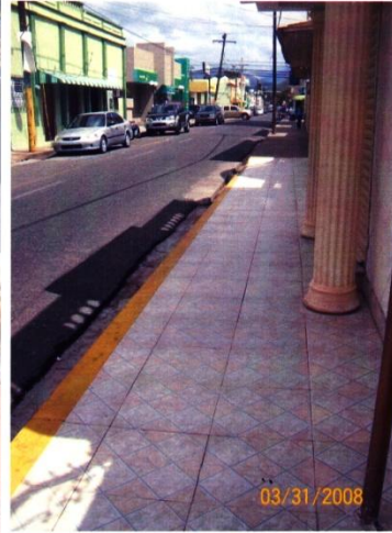
Colocación de materiales resbaladizos en las aceras y rampas inadecuadas.
