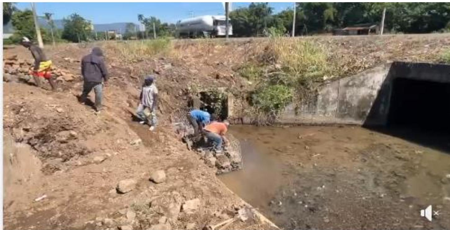
Así avanza los trabajos de construcción de la entrada de Caño Piedra, donde nos encontramos trabajando en los gaviones y con el relleno.
