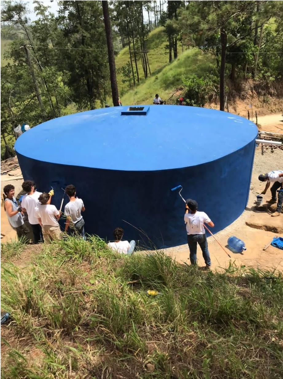
**Construcción tanque en ferro cemento para abastecimiento de agua en la sección de COROCITO**
