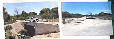
Etapa final del puente Ana Lucila II
