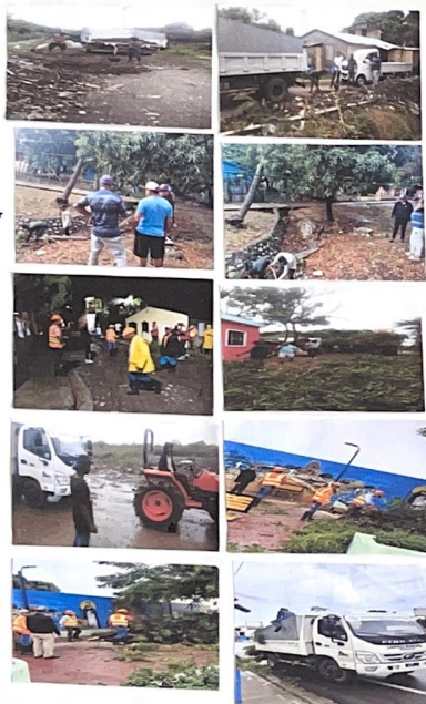
Limpeza y acondicionamientos en el municipio por el paso de la tormenta FRANKLIN
