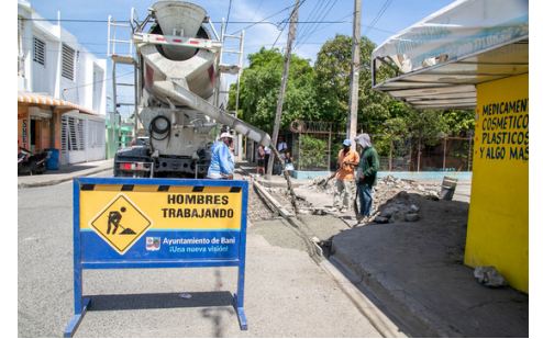
CONSTRUCCIÓN DE BADEN, AV. FABIO HERRERA
