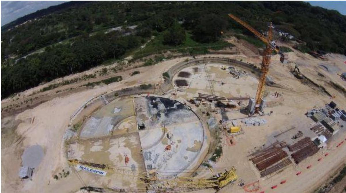
Más de 30 mil metros cúbicos de excavaciones fueron realizados en el lugar de depósito de las aguas negras, conjuntamente con la instalación de la nueva Planta de Tratamiento de Aguas Residuales a Lodos Activados (PTAR), también serán rehabilitadas casi 60 kilómetros de redes (tuberías). “La planta tendrá reactores biológicos y clasificadores”, expresó.
